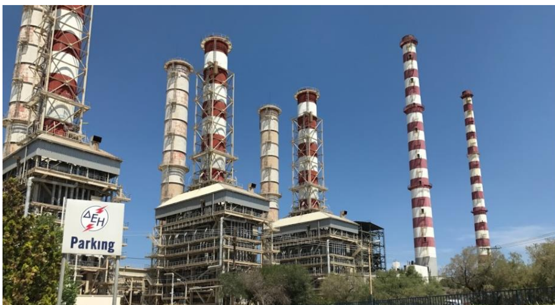
Εικόνα 3-1 : Γενική άποψη Μονάδας VI του ΑΗΣ Λαυρίου
