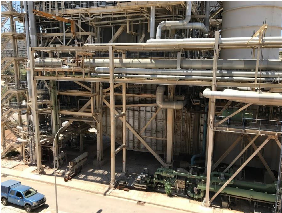
Εικόνα 3-2 : Λέβητας ανάκτησης θερμότητας
