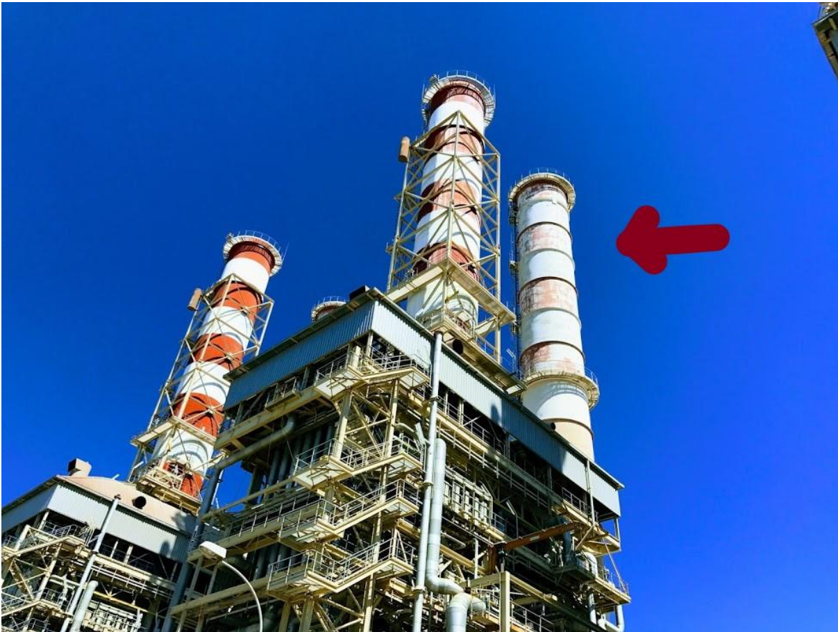
Εικόνα 3-4 : Υπό μελέτη παρακαμπτήριος καπνοδόχος
