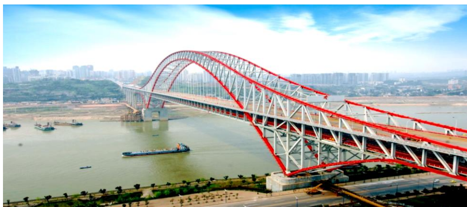
Εικόνα 1.5 : Η γέφυρα Chaotianmen πάνω από τον ποταμό Yangtze στην Κίνα με την μεγαλύτερη αψίδα στον κόσμο. Μήκος δικτυώματος 552 μέτρα, συνολικό μήκος 1,741 μέτρα.
