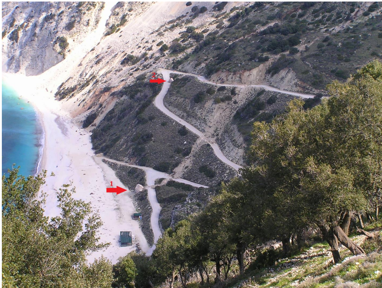
Εικόνα 4.15: Αποψη του ανατολικού πρανούς της παραλίας του Μύρτου από νότια, στο οποίο διακρίνονται οι καταπτώσεις των δύο βράχων. Με τον αριθμό 1 σημειώνεται ο μεγάλος βράχος όγκου 180 \text{ m}^3 και με τον αριθμό 2 ο μικρότερος (φωτογραφία Ε. Λέκκας, 2014).
