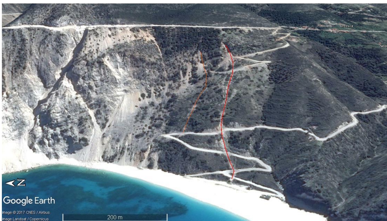
Εικόνα 4.19: Η παραλία του Μύρτου το Μάρτιο του 2016 (πηγή: Google Earth). Είναι εμφανές το αποτύπωμα των τροχιών της κατάπτωσης των δύο βράχων πάνω στην πλαγιά. Σημειώνεται με κόκκινη γραμμή η τροχιά του βράχου (1) και με πορτοκαλί γραμμή του βράχου (2). Στο τέλος της κόκκινης γραμμής διακρίνεται ο βράχος (1).
