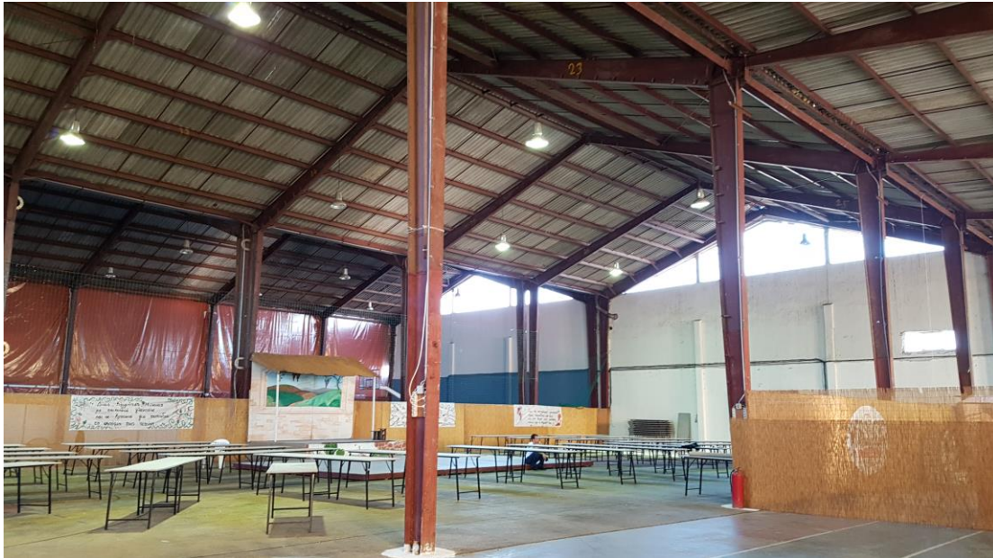
Σχήμα 3-1: Εσωτερική όψη του βιομηχανικού κτιρίου.
