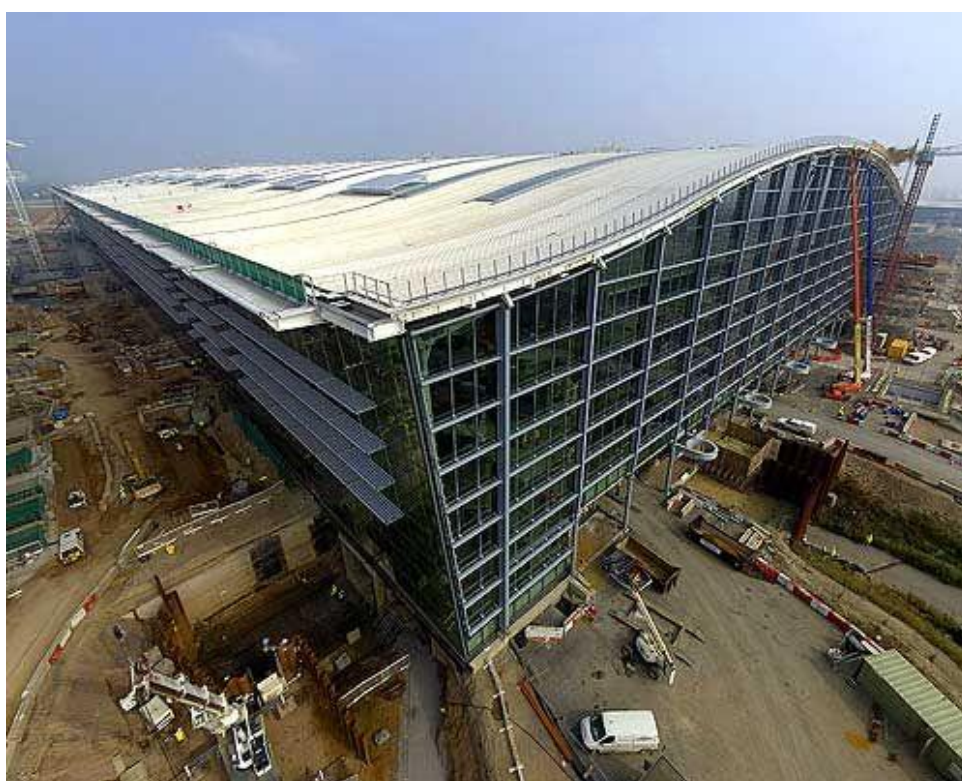
Σχήμα 1-9: Τερματικός σταθμός 5, Αεροδρόμιο Χίθρου, Αγγλία [6]
