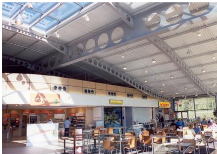
Σχήμα 1-3: Σταθμός αυτοκινητοδρόμου με δοκούς μεγάλων ανοιγμάτων [2]
