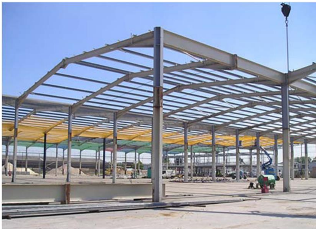
Σχήμα 1-15: Νέα υποστυλώματα 3 μέτρων για την κατακόρυφη επέκταση του φορέα [2]
