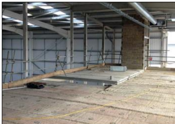
Σχήμα 1-17: Επανεγκατάσταση των προκατασκευασμένων δοκών σκυροδέματος [2]
