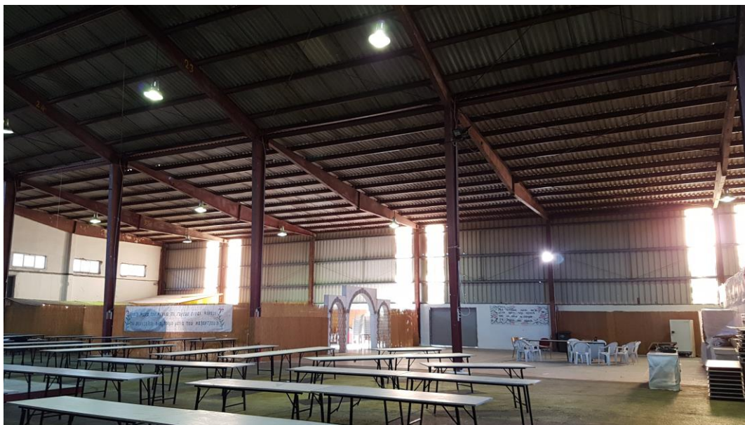
Σχήμα 3-3: Εσωτερική όψη του βιομηχανικού κτιρίου
