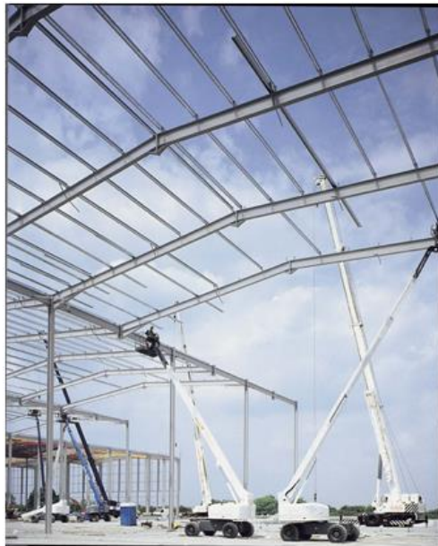
Σχήμα 1-4: Αποθήκη και κέντρο διανομής, όπου η ανέγερση 1.600 τόνων δομικού χάλυβα διήρκεσε 21 ημέρες [2]
