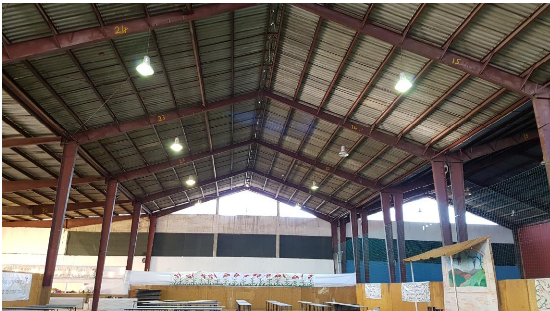
Σχήμα 3-2: Εσωτερική όψη του βιομηχανικού κτιρίου
