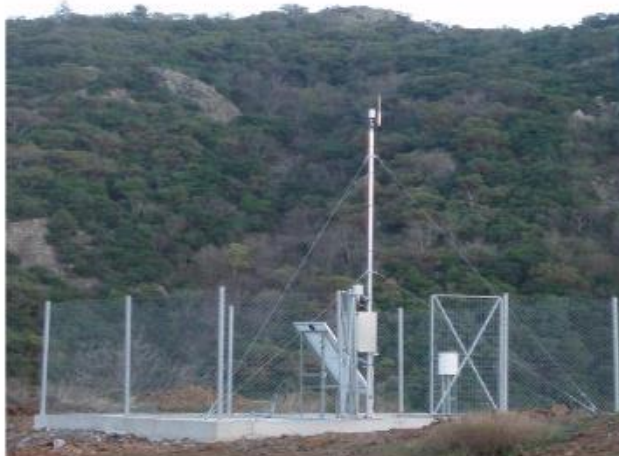
Εικόνα 6. Περιοχή εγκατάστασης στο φράγμα του Διποτάμου (Πηγή: http://www.metrice.gr/ ).
