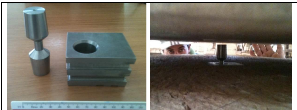
Εικ. 2.19: Πόλος και εμπόλιο από τιτάνιο, λίγο πριν (αριστερά) και κατά την τοποθέτησή του σε κίονα της περιστάσης του ναού του Επικούριου Απόλλωνα.
