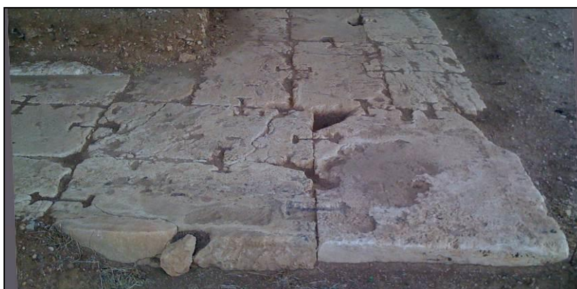
Εικ. 2.3: Σύνδεσμοι διπλού T στη νοτιοδυτική γωνία του αρχαϊκού ναού στην περιοχή Τραπεζά Αγίου, ο οποίος χρονολογείται περί το 540 π.Χ.
