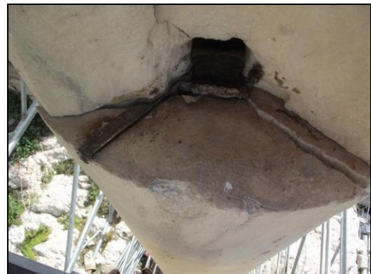
Εικ. 2.18: Γόμφος σε διεπιφάνεια του Α. χορηγικού κίονα στη νότια κλιτύ 97 .
