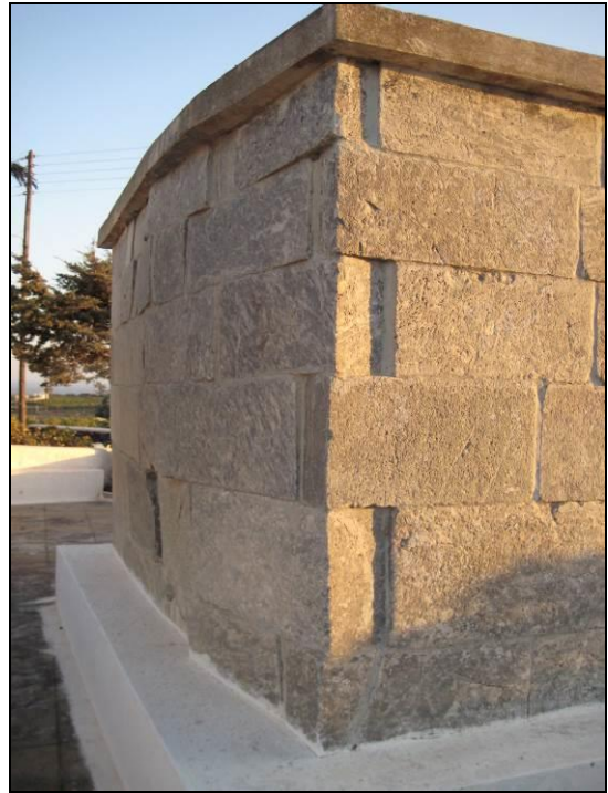
Εικ. 1.8: Παραμορφώσεις οπίσθιου τοίχου ναΐσκου του 3 ου αι. π.Χ. που έχει μετατραπεί σε εκκλησία αφιερωμένη στον Άγιο Νικόλαο στην Σαντορίνη.
