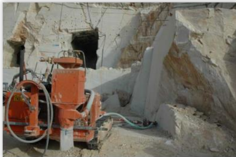
Εικόνα 2.5i: Crawler διενεργεί διάνοιξη διατρήμάτων
