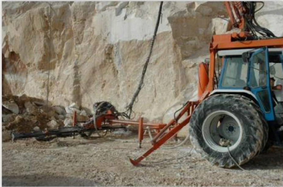
Εικόνα 2.9m: Αυτομεταφερόμενο διατρητικό φορείο για όρυξη οριζόντιων διατρημάτων (liner)
