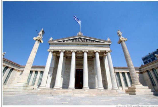
Εικόνα 1.3c: Η Ακαδημία Αθηνών, κατασκευή που φιλοτεχνήθηκε με Λευκό Πεντελικό Μάρμαρο
