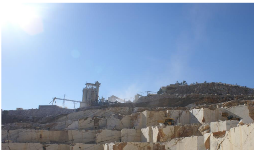
Εικόνα 2.3g: Σπαστηροτριβείο κατά τη λειτουργία του σε λήψη από το λατομικό χώρο
