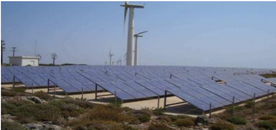
Εικόνα 23 : Το φωτοβολταϊκό πάρκο με τα πάνελ να έχουν γωνία 30° και προσανατολισμό προς το Νότο.
