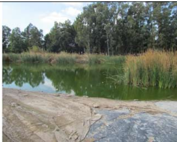
Εικόνα 23, Μεγάλες απώλειες στις τεχνητές λίμνες λόγω της κακής στεγάνωσης και συντήρησης
