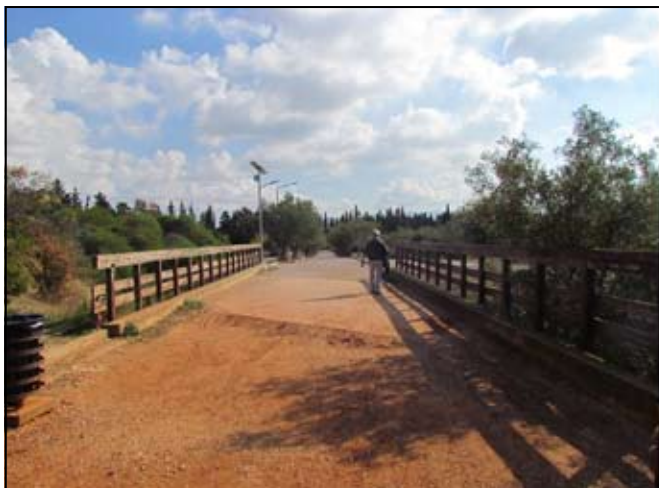
Εικόνα 31 , Είσοδος από την οδό Χασιάς και κατεύθυνση προς το κεντρικό κανάλι
