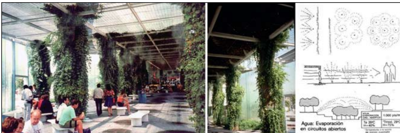
Εικόνα 12 , Αριστερά σύστημα μικροψεκαστήρων ενσωματωμένο σε πέργκολα με αναρριχητικά φυτά, EXPO 92, Σεβίλλη / Δεξιά: σχεδιάγραμμα χρήσης μικροψεκαστήρων, πηγή Sistemas de enfriamiento pasivo, casos de estudio, Espacio abiertos Exposición Universal 1992, J.Pérez de Lama, Arquitectura y Medio Ambiente ETSA Universidad de Sevilla, 2008
