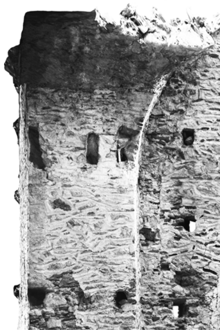
εικ. 68, Ορθοεικόνα, ποδαρικό σταυροθολίου Γ' ορόφου. Στην στάθμη της γέννησης του σταυροθολίου παρατηρούνται οι τρεις οπές στήριξης των ικριωμάτων.
