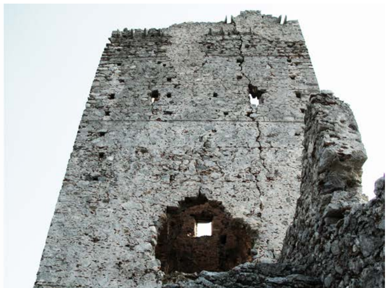
εικ. 79, κατακόρυφες καμπτικές διαμπερείς ρωγμές στην νότια και βόρεια όψη αντίστοιχα
