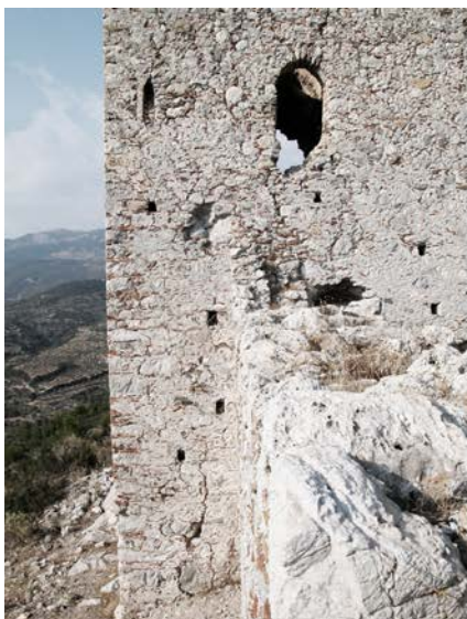
εικ. 79, κατακόρυφες καμπτικές διαμπερείς ρωγμές στην νότια και βόρεια όψη αντίστοιχα
