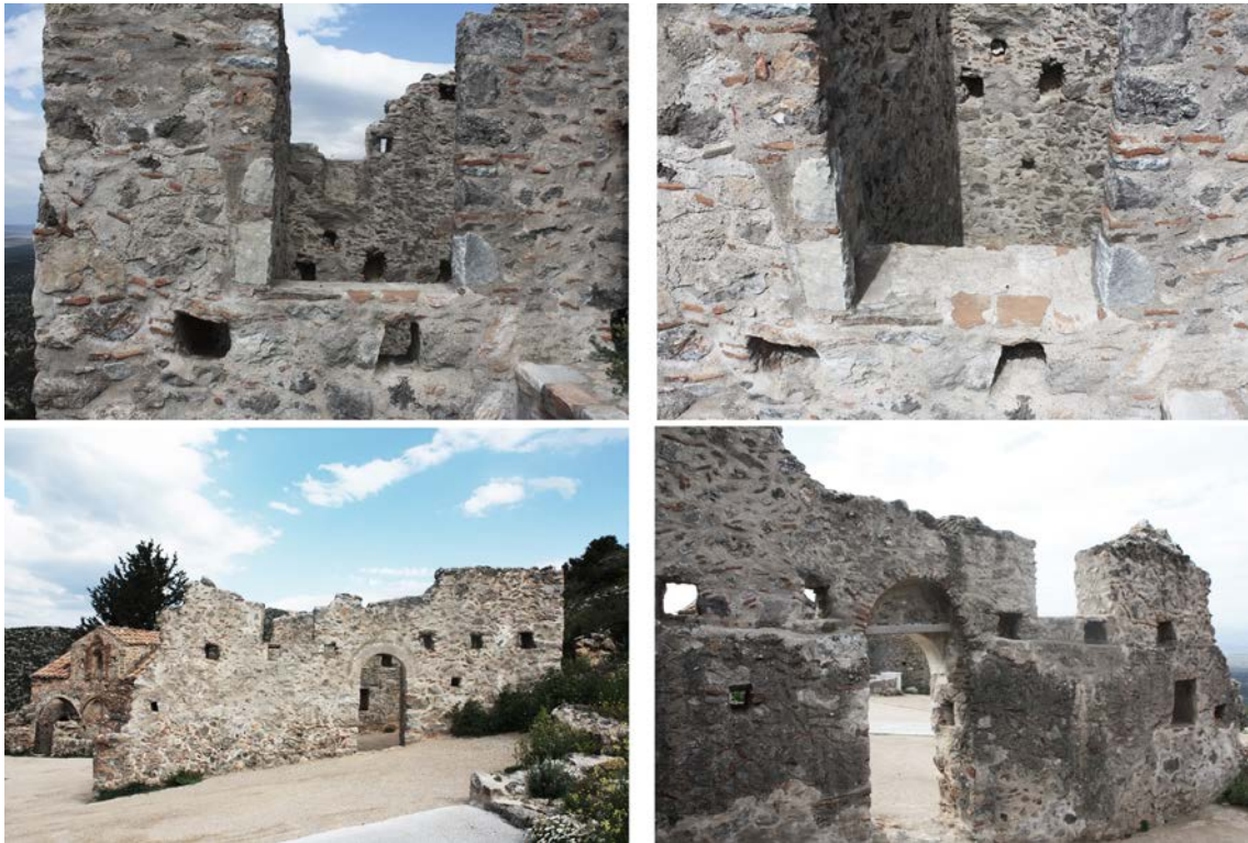
εικ. 64. Μεσαιωνικός οικισμός Γεράκι, οι διαμπερείς δοκοθήκες
