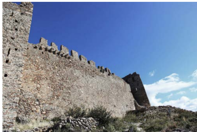
εικ. 34. Νότιος τείχος περιβόλου του μεσαιωνικού κάστρου Γερακίου. Διακρίνεται η σειρά με τους κιλλίβαντες και καταχύστρα που επικοινωνεί με τρύπα από την έπαλξη.
