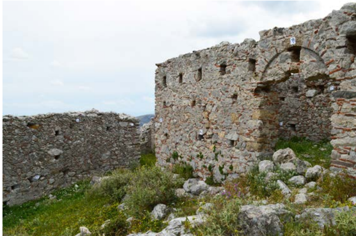
εικ. 61. Κάστρο Ζαραφώνας, παράσπιτο, οι διαμπερείς δοκοθήκες
