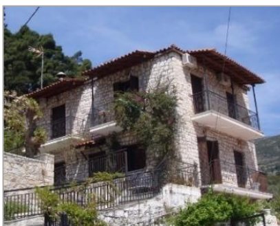
Εικ. II.A.21: Κτήριο σύμφωνα με τις διατάξεις του 1976 στο άνω τμήμα του κάτω περιβόλου
