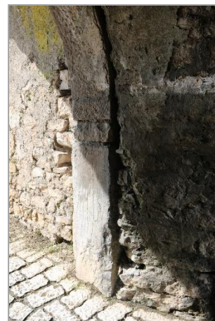
Εικ. II.Γ.17: Ο κατασκευαστικός αρμός μεταξύ του λιθόκτιστου θυρώματος και του νότιου τοίχου του ορθογωνικού προμαχώνα.
