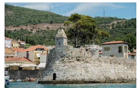
Εικ. II.B.03-04: Όψεις του ανατολικού λιμενοβραχίονα
