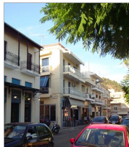
Εικ. II.A.25: Άποψη της ζώνης Β1 στο ύψος του λιμανιού
