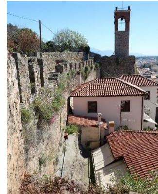
Εικ. II.B.35: Κατασκευές και επεμβάσεις στο τείχος. (τμήμα IV)
