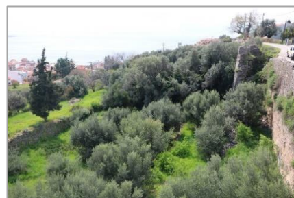
Εικ. II.B.32: Άποψη της τάφρου στο τμήμα I.
