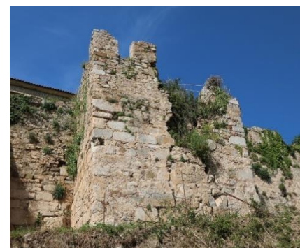
Εικ. II.B.34: Η βόρεια πλευρά του τετραγωνικού πύργου είναι ετοιμόρροπη
