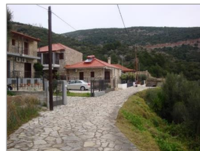
Εικ. II.Γ.27: Όψη της οδού Σουλίου στο σημείο που έχει γκρεμιστεί το τείχος.
