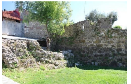
Εικ. II.B.40: Οι επεμβάσεις και οι προσθήκες στο τείχος στο τμήμα V11
