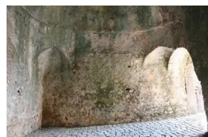
Εικ. II.Γ.16: Εσωτερική όψη του ορθογωνικού προμαχώνα
