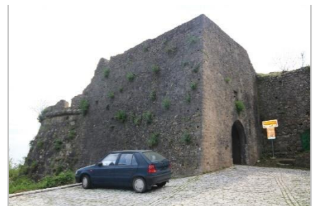
Εικ. II.B.07: Εξωτερική όψη της πύλης Φαλτσοπόρτι
