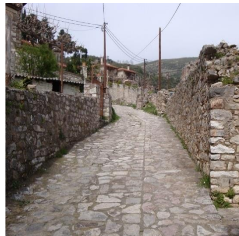
Εικ. II.A.12: Πλακόστρωση με ακανόνιστες πλάκες
