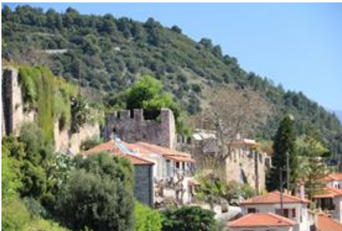
Εικ. II.B.37: Όμορες ιδιοκτησίες στο τείχος στο τμήμα V με αποτέλεσμα να μην είναι δυνατή η προσέγγιση.
