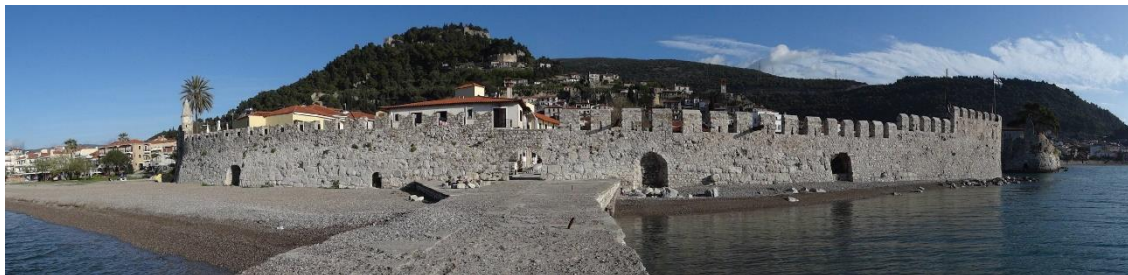
Εικ. II.B.05: Όψη του δυτικού λιμενοβραχίονα
