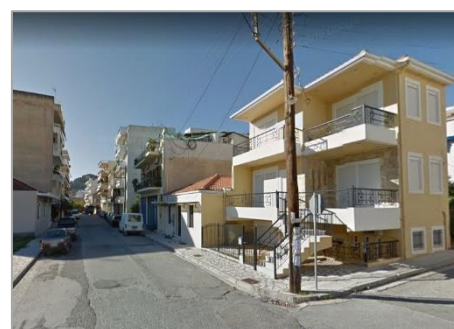
Εικ. Ι.Γ.13: Κτήριο χτισμένο σύμφωνα με τους όρους δόμησης του 2002 (σ.δ.=1,2) γειτνιάζει με τετραώροφες πολυκατοικίες (στο βάθος)
