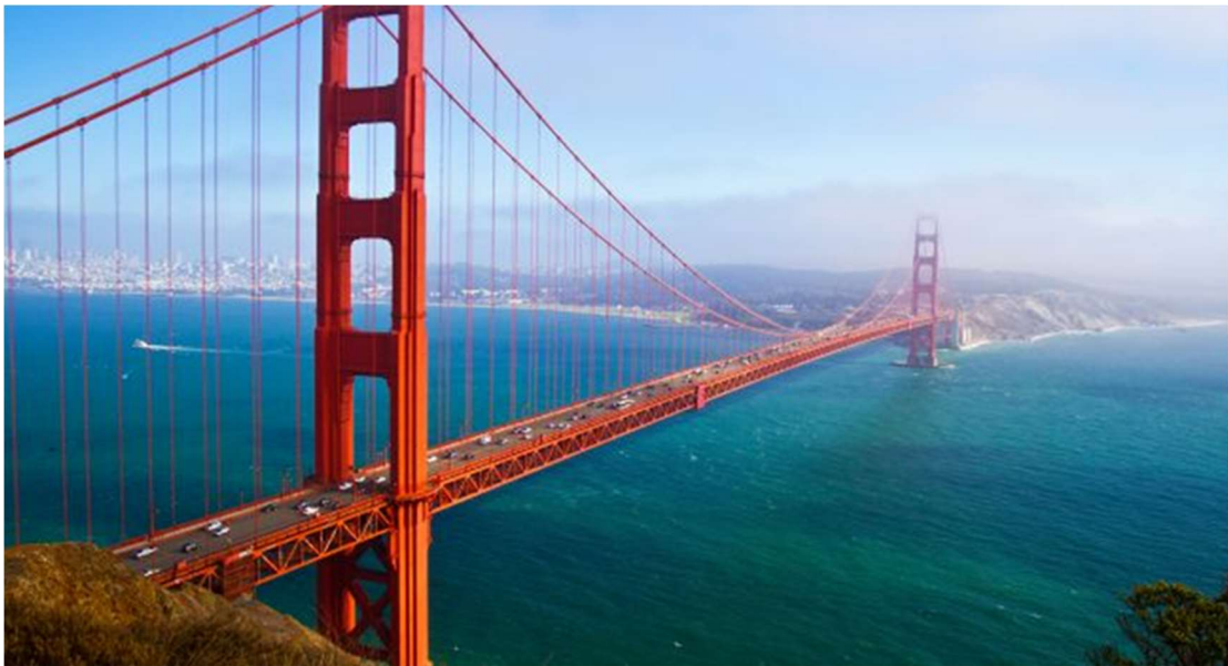
Εικόνα 1.19 Γέφυρα Golden Gate, Σαν Φρανσίσκο, Ηνωμένες Πολιτείες
