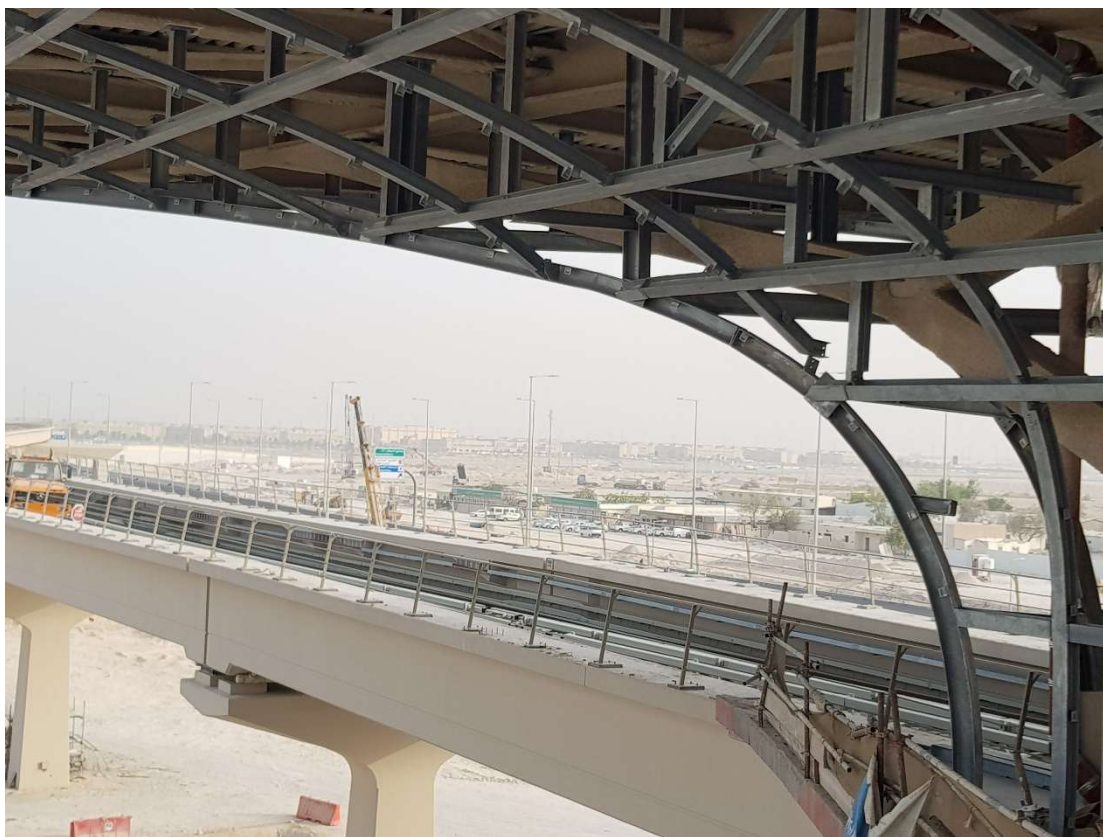
Εικόνα 2.7 Άποψη ολοκληρωμένων έργων στη γραμμή ΜΕΤΡΟ της Ντόχα
