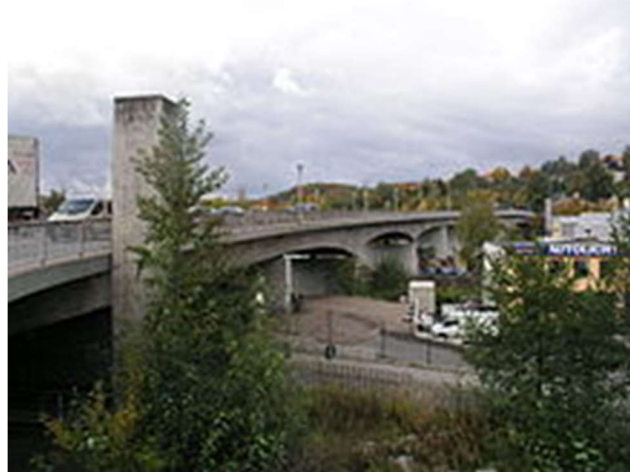
Εικόνα 1.21 Γέφυρα στο Aue, Γερμανία
