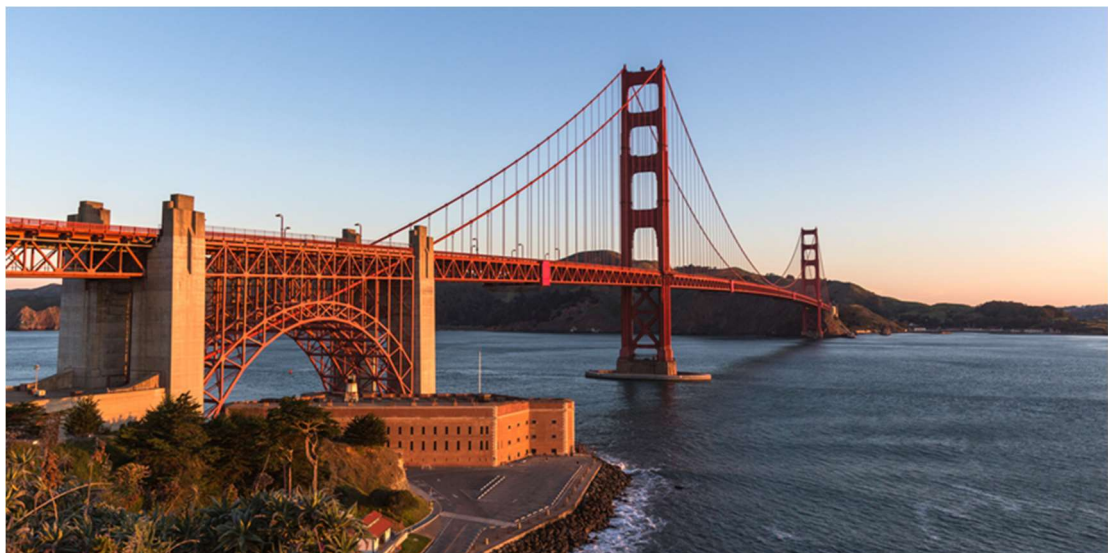
Εικόνα 1.20 Γέφυρα Golden Gate, Σαν Φρανσίσκο, Ηνωμένες Πολιτείες
