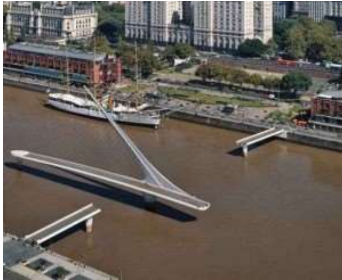
Εικόνα 1.34 Περιστρεφόμενη γέφυρα
