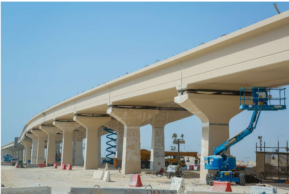
Εικόνα 2.6 Κατασκευή τμήματος της γραμμής ΜΕΤΡΟ στη Ντόχα
