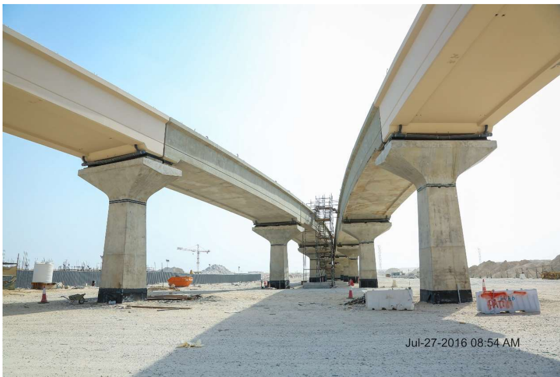
Εικόνα 2.5 Κατασκευή τμήματος της γραμμής ΜΕΤΡΟ στη Ντόχα
