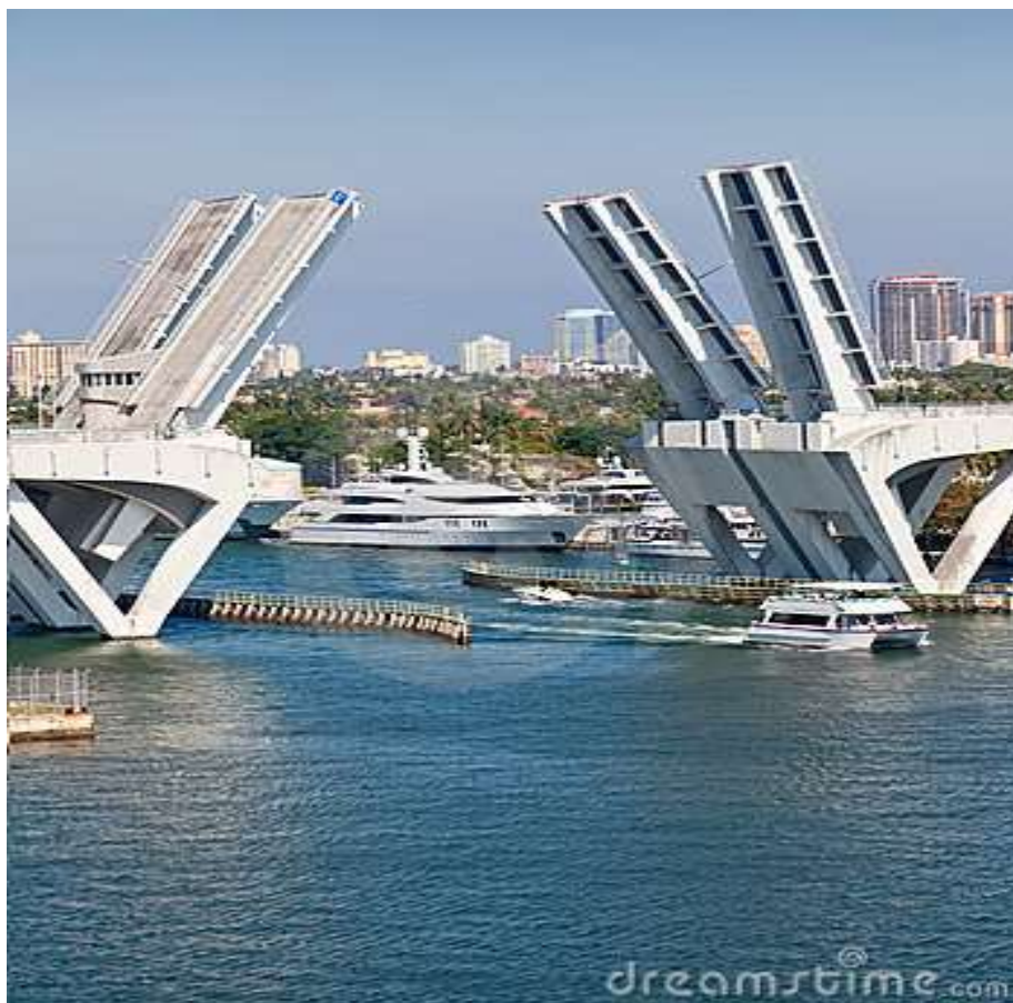
Εικόνα 1.37 Ανυψούμενη γέφυρα
