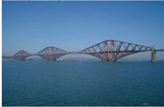
δ. Γέφυρα μεταλλική
