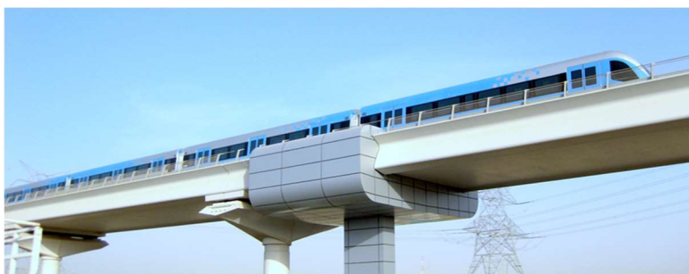
Εικόνα 2.1 Τυπική όψη φορέα σκαφοειδούς μορφής
