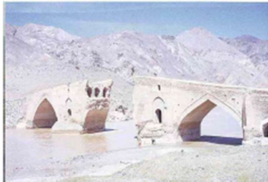
β. Γέφυρα λίθινη
