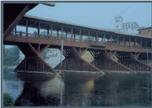
α. Γέφυρα ξύλινη
