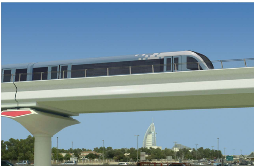
Εικόνα 2.2 Χρήση φορέα διατομής U στις αστικές σιδηροδρομικές συγκοινωνίες (Dubai)
