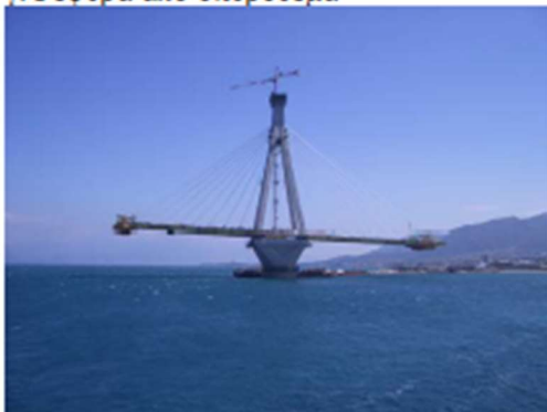
ε. Γέφυρα σύμμικτη
