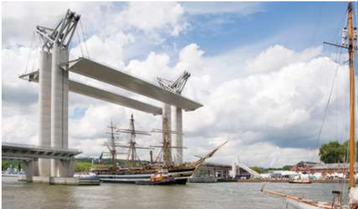
Εικόνα 1.36 Ανυψούμενη γέφυρα
