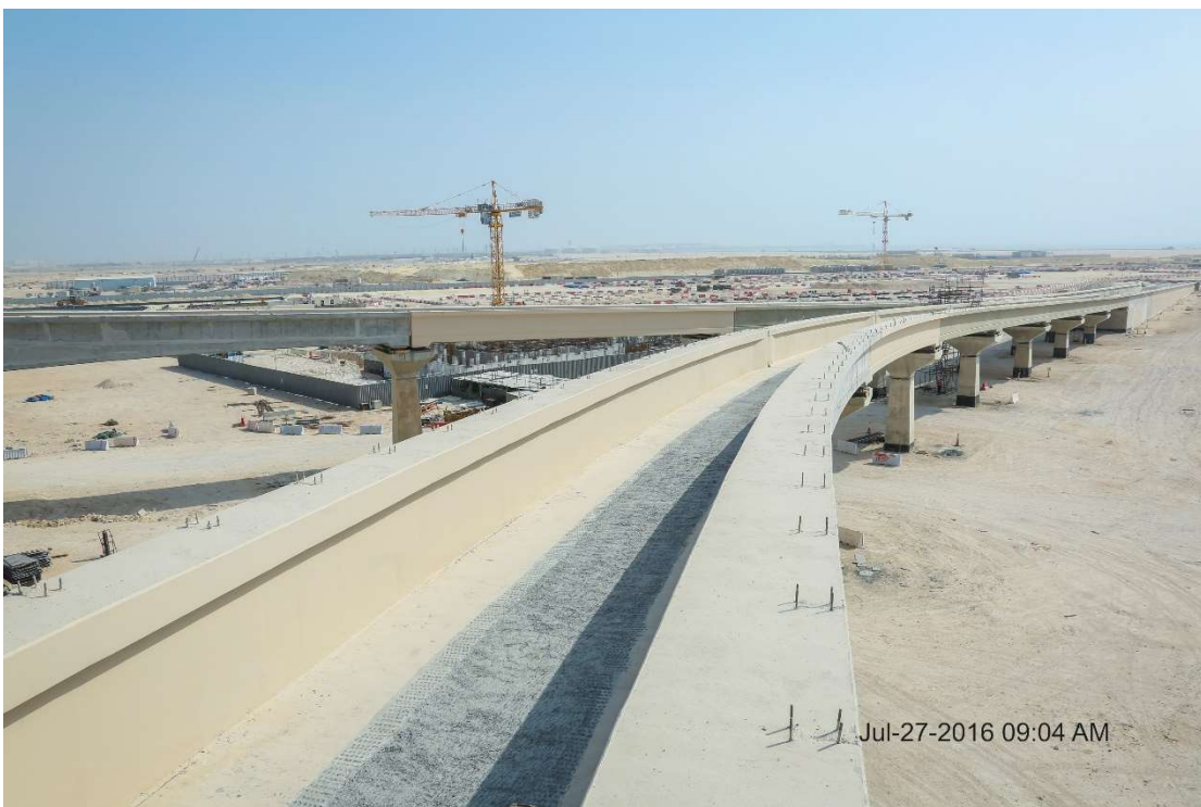
Εικόνα 2.4 Κατασκευή τμήματος της γραμμής ΜΕΤΡΟ στη Ντόχα
