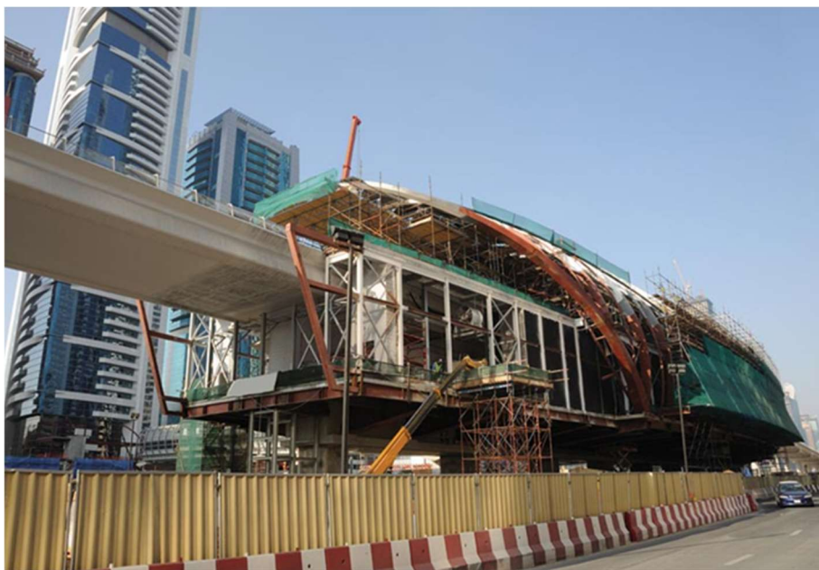
Εικόνα 2.14 Κατασκευή σταθμού, ανεξάρτητη δομή από τη γέφυρα.
