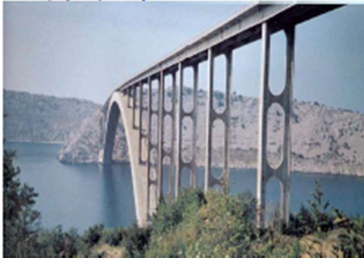
γ. Γέφυρα από σκυρόδεμα
