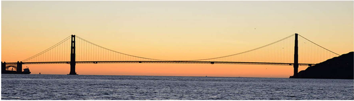
Εικόνα 1.18 Γέφυρα Golden Gate, Σαν Φρανσίσκο, Ηνωμένες Πολιτείες
