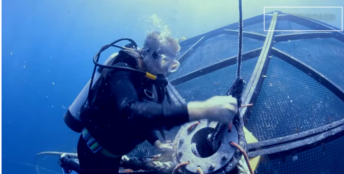
Εικόνα 2.40: Σφαιρικός ιχθυοκλωβός από πολυαιθυλένιο-δέσιμο σχοινού αγκύρωσης. Πηγή: www.livingoceanproductions.com
