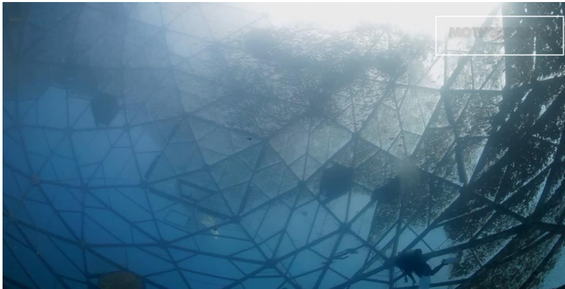
Εικόνα 2.41: Σφαιρικός ιχθυοκλωβός από πολυαιθυλένιο. Πηγή: www.livingoceanproductions.com
