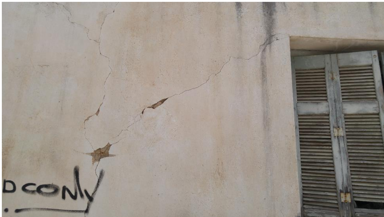
Εικόνα 4.4.98 Αριθμός 89: Τριχοειδής ρωγμή στο επίχρισμα με επέκταση στην τοιχοποιία αριστερά του κουφώματος κύριας όψης μονοκατοικίας στην οδό Ακαρνανίας
