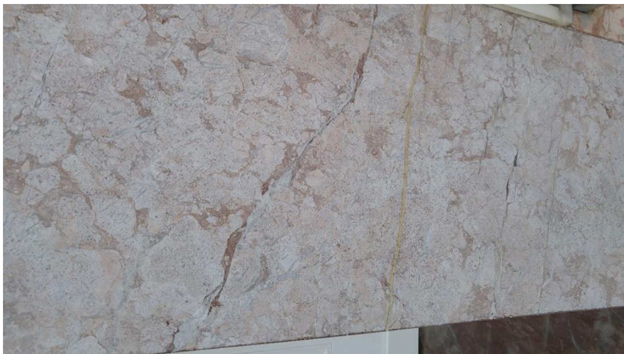
Εικόνα 4.4.109 : Αριθμός 99: Ρωγμή σε ορθομαρμάρωση κολώνας κεντρικής εισόδου πολυκατοικίας στην οδό Καστέλας
