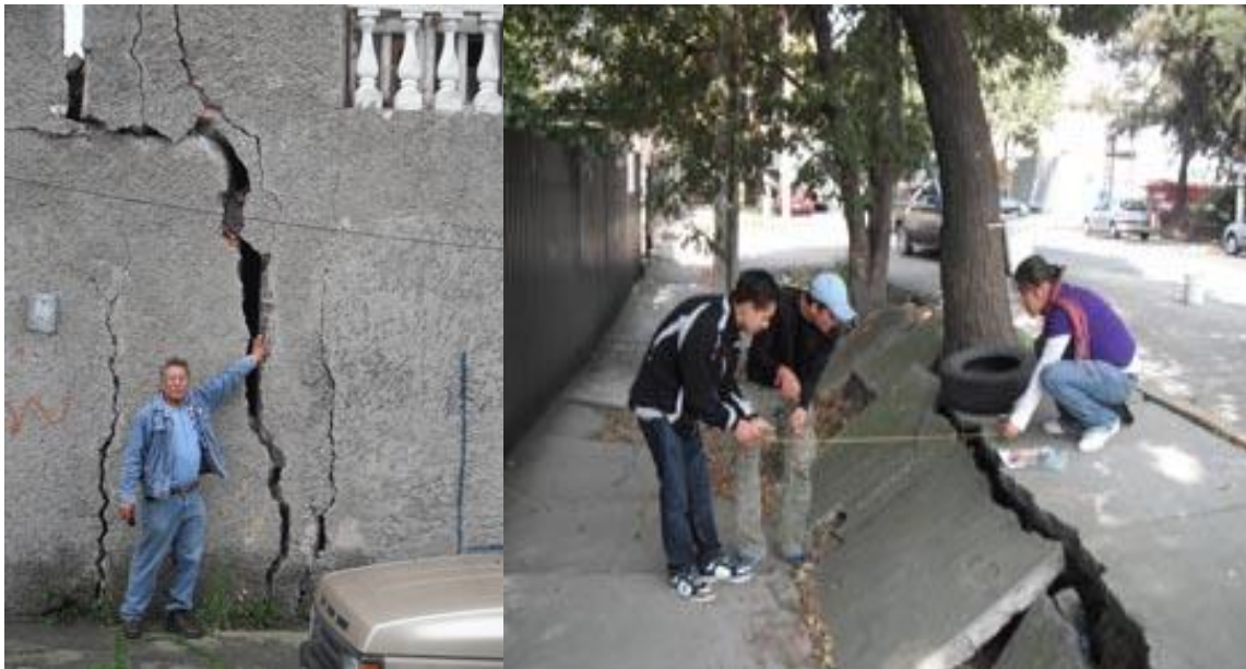
Εικόνα 1.3.1 Αποτελέσματα της επιφανειακής βλάβης που προκλήθηκε από τη διαφοροποίηση της καθίζησης στη μητροπολιτική περιοχή της πόλης του Μεξικού (GSG)
