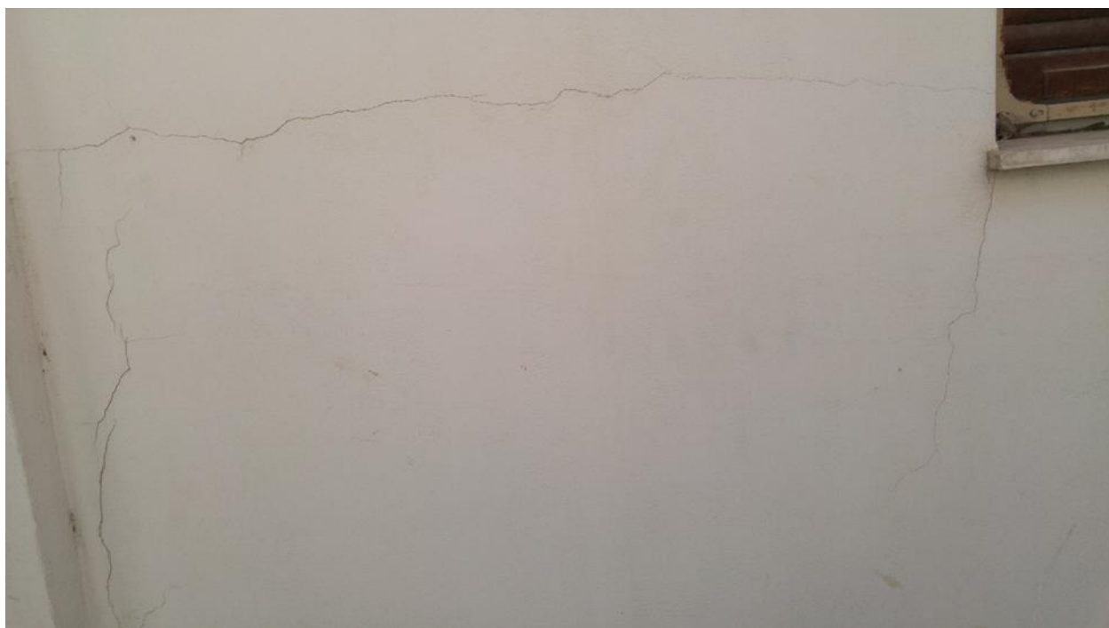
Εικόνα 4.4.42 Αριθμός 39: Ρωγμή γωνίας 45° σε τοιχοποιία βόρειας όψης κτιριακής κατασκευής στην οδό Αρκανίας
