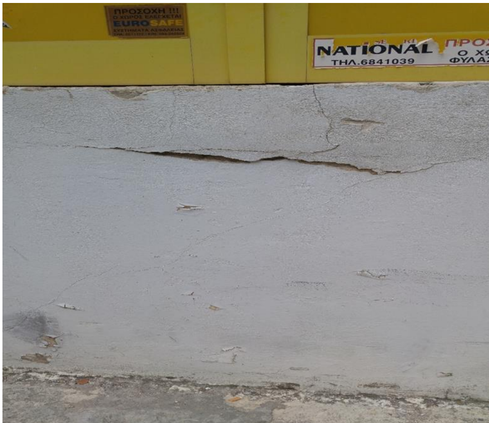
Εικόνα 4.4.107 Αριθμός 97: Ρωγμή γωνίας 45° σε πυλωτή πολυκατοικίας της οδού Βικτωρίας
