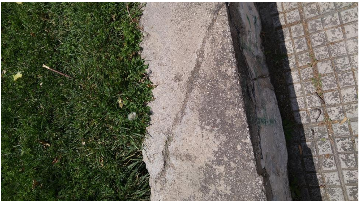
Εικόνα 4.4.93 Αριθμός 84: Ρωγμή γωνίας 45° με, πολλαπλές δευτερεύουσες, σε επικάλυψη ορθομαρμάρωσης πλάγιας όψης κατασκευής στην οδό Αγίου Σωστή
