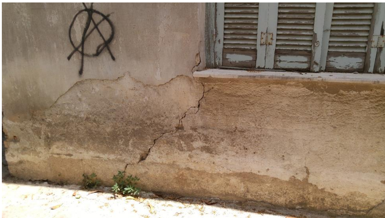
Εικόνα 4.4.104 Αριθμός 94: Εκτενής ρωγή γωνίας 45° σε φέρουσα τοιχοποιία κύριας όψης μονοκατοικίας στην οδό Αζανίας
