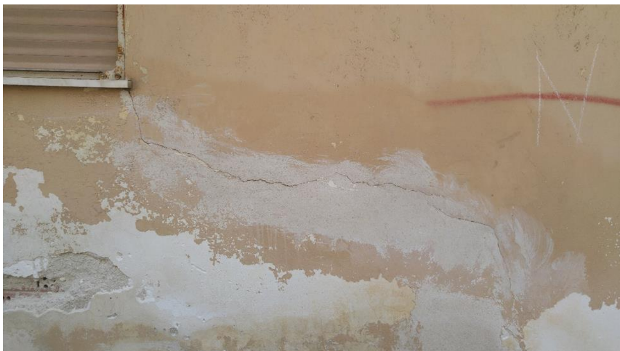
Εικόνα 4.4.109 : Αριθμός 99: Ρωγμή σε ορθομαρμάρωση κολώνας κεντρικής εισόδου πολυκατοικίας στην οδό Καστέλας
