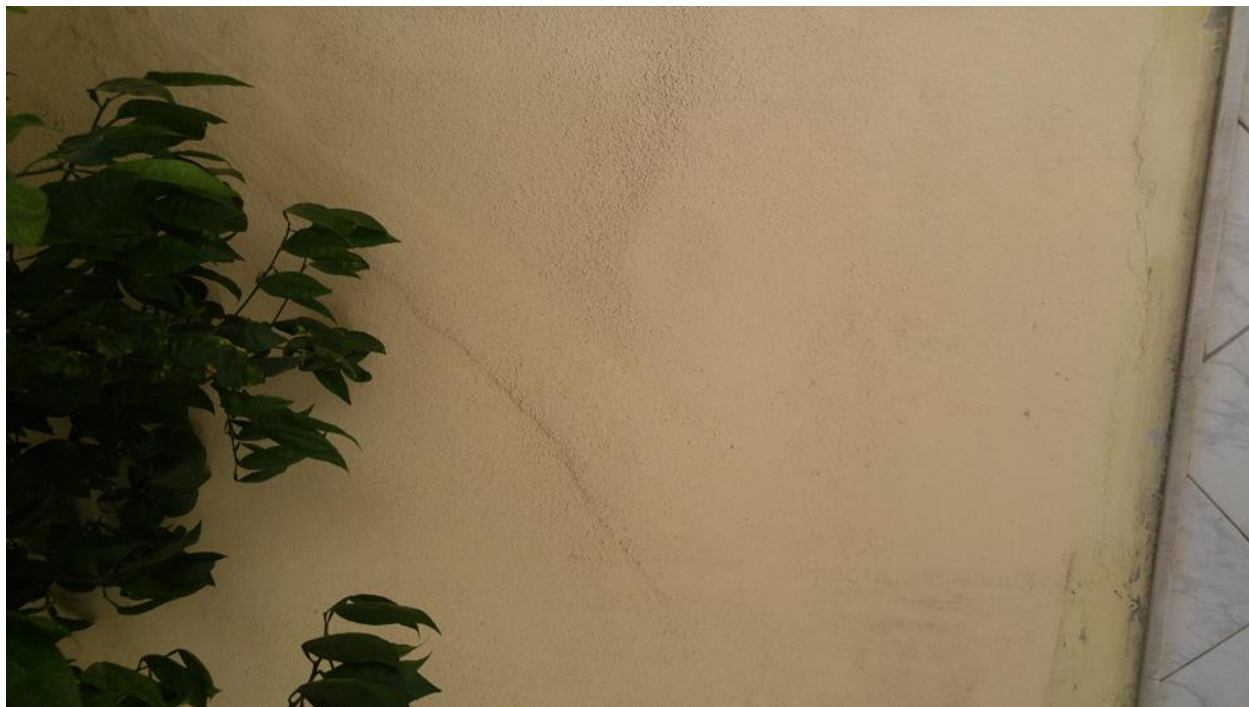
Εικόνα 4.4.38 Αριθμός 35: Ρωγή σημαντικού πάχους γωνίας 45° στην πλάγια όψη κατασκευής στην οδό Αθηνογένους
