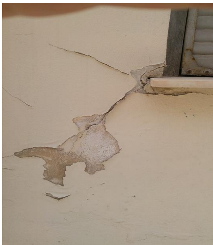
Εικόνα 4.4.104 Αριθμός 94: Εκτενής ρωγή γωνίας 45° σε φέρουσα τοιχοποιία κύριας όψης μονοκατοικίας στην οδό Αζανίας
