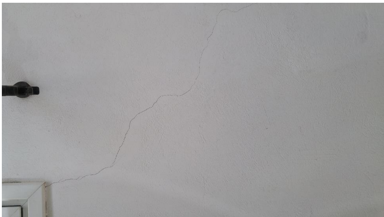
Εικόνα 4.4.61 Αριθμός 55: Ρωγμή γωνίας 45° σε τοιχοποιία ανατολικής όψης στην οδό Αγίου Σωστή
