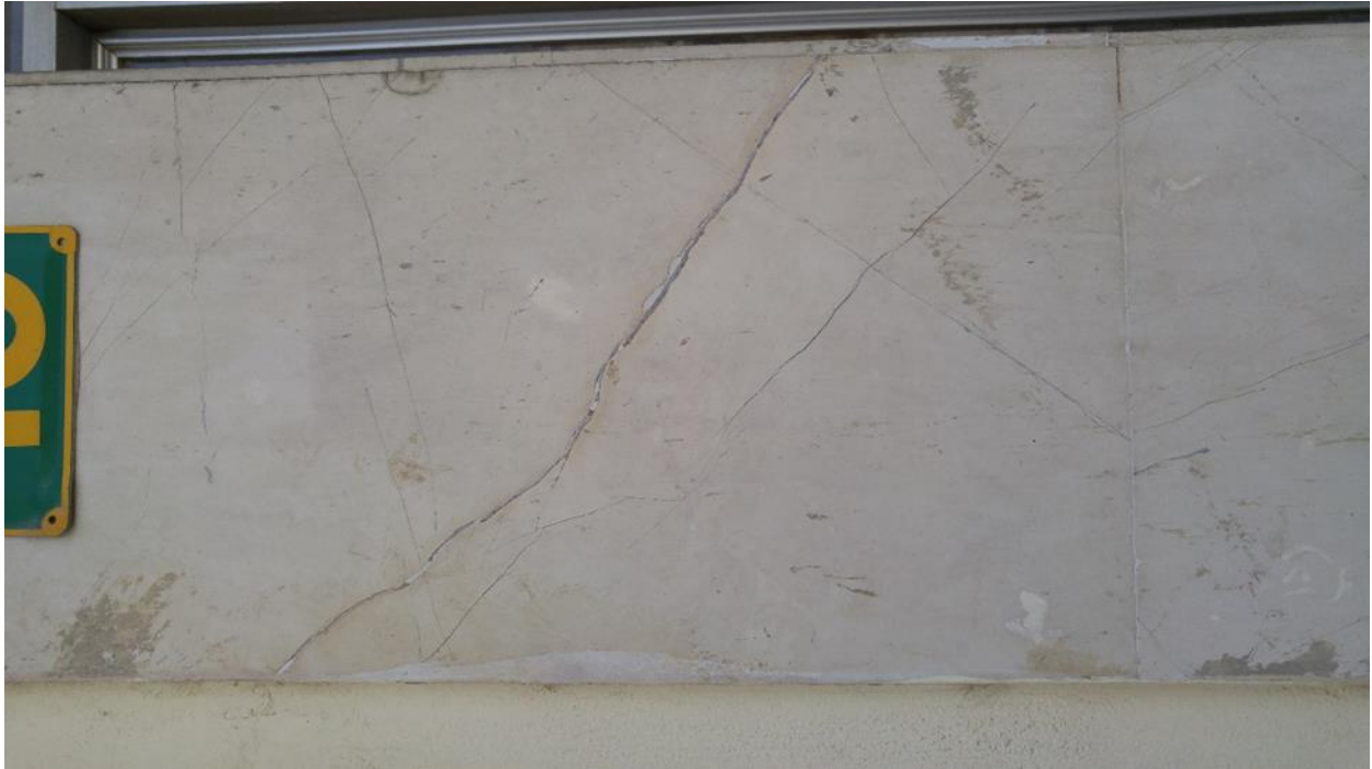
Εικόνα 4.4.93 Αριθμός 84: Ρωγμή γωνίας 45° με, πολλαπλές δευτερεύουσες, σε επικάλυψη ορθομαρμάρωσης πλάγιας όψης κατασκευής στην οδό Αγίου Σωστή
