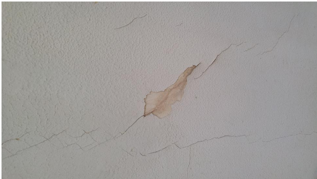
Εικόνα 4.4.61 Αριθμός 55: Ρωγμή γωνίας 45° σε τοιχοποιία ανατολικής όψης στην οδό Αγίου Σωστή
