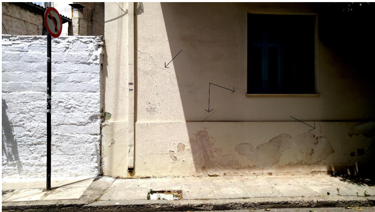
Εικόνα 4.4.69 Αριθμός 62: Ρωγμές στο αριστερό τμήμα τοιχοποιίας της ανατολικής όψης μονοκατοικίας στην οδό Αγίας Μαρίνας με επέκταση στην επένδυση σκυροδέματος
