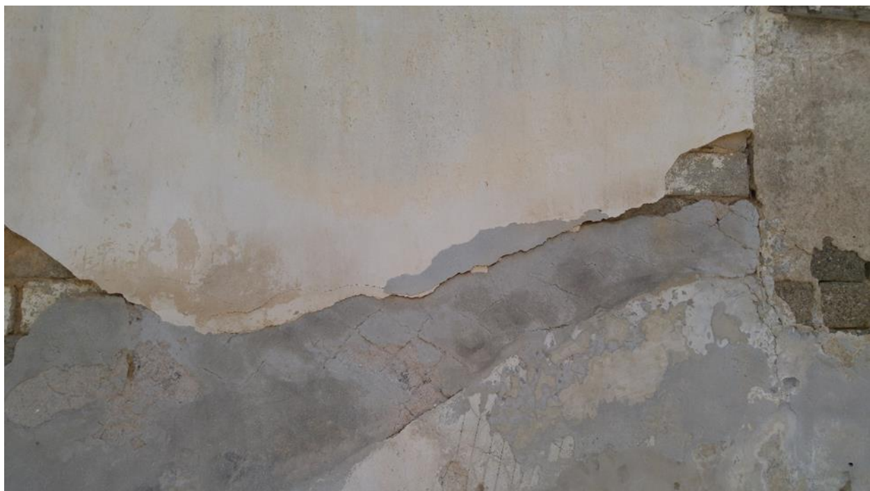
Εικόνα 4.4.98 Αριθμός 89: Τριχοειδής ρωγμή στο επίχρισμα με επέκταση στην τοιχοποιία αριστερά του κουφώματος κύριας όψης μονοκατοικίας στην οδό Ακαρνανίας
