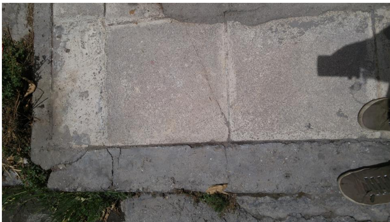
Εικόνα 4.4.69 Αριθμός 62: Ρωγμές στο αριστερό τμήμα τοιχοποιίας της ανατολικής όψης μονοκατοικίας στην οδό Αγίας Μαρίνας με επέκταση στην επένδυση σκυροδέματος
