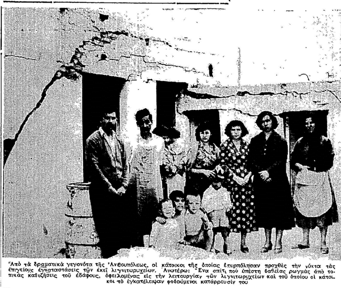
Εικόνα 3.1.2 Ρωγμές λόγω στοών μικροῦ βάθους κοντά σε οικισμό της Ανθούπολης ( http://www.peristerinews.gr , 2013)
