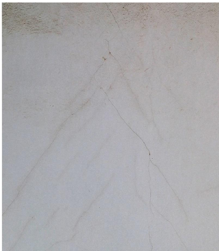
Εικόνα 4.4.38 Αριθμός 35: Ρωγή σημαντικού πάχους γωνίας 45° στην πλάγια όψη κατασκευής στην οδό Αθηνογένους
