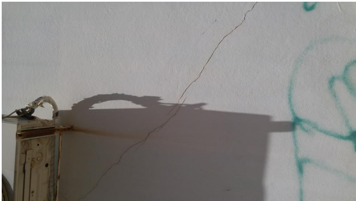
Εικόνα 4.4.42 Αριθμός 39: Ρωγμή γωνίας 45° σε τοιχοποιία βόρειας όψης κτιριακής κατασκευής στην οδό Αρκανίας
