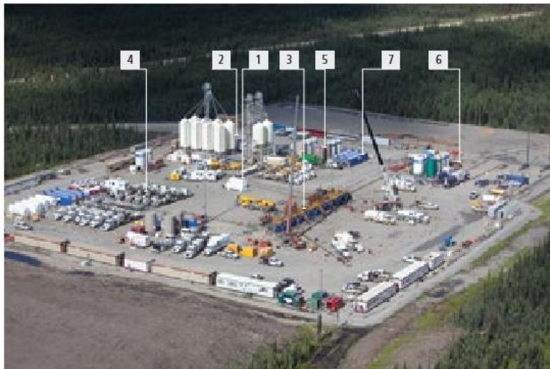
Εικόνα 4-4: Χώρος όρυξης γεώτρησης στον Καναδά με τον απαραίτητο εξοπλισμό για την εφαρμογή της υδραυλικής ρωγμάτωσης (Council of Canadian Academies, 2014).
