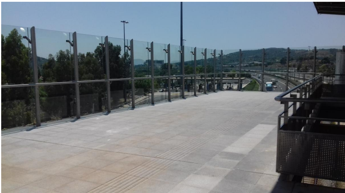
Εικόνα 32: Διαθέσιμος χώρος, σταθμός Παιανία Κάντζα
