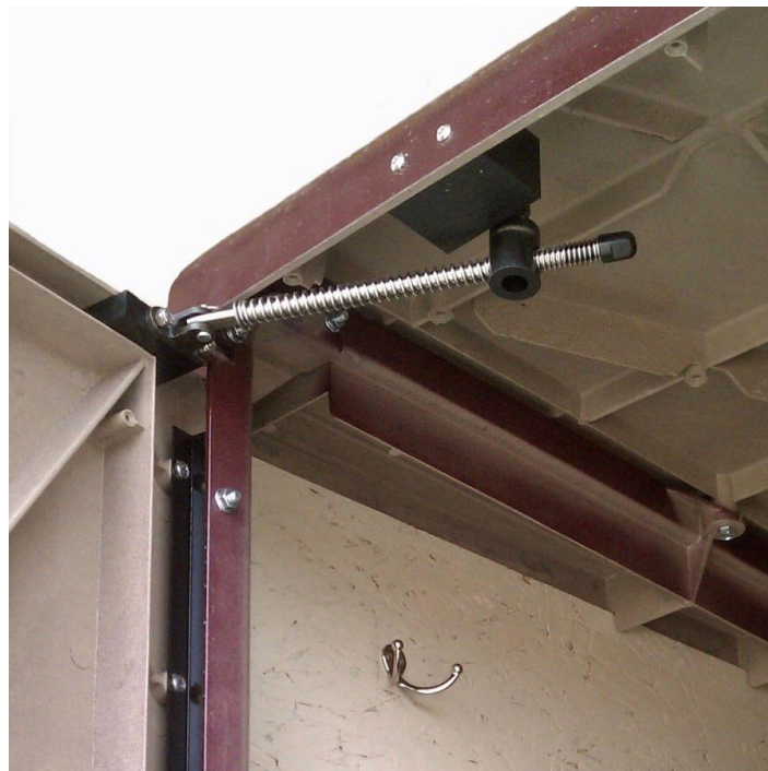
Εικόνα 24: Σύστημα ασφαλείας για τον έλεγχο της πόρτας
