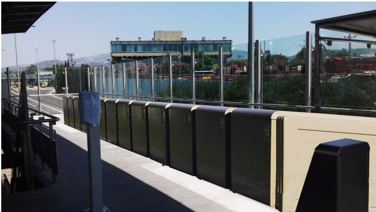
Εικόνα 49: Προτεινόμενος χώρος και διάταξη εντός του σταθμού, Προαστιακός Παλλήνης (χωρίς κλίμακα, ενδεικτικές διαστάσεις)
