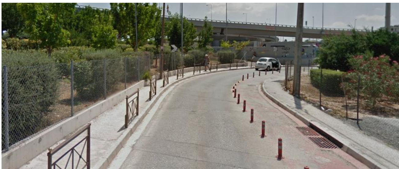
Εικόνα 39: Παράδρομος Αττικής οδού, πρόσβαση στην είσοδο του σταθμού Προαστιακού Δ. Πλακεντίας. Δεξιά διακρίνεται ο ποδηλατόδρομος (Google maps)
