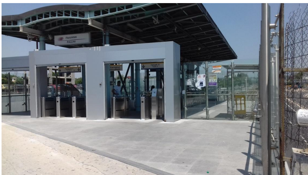
Εικόνα 36: Διαθέσιμος χώρος, σταθμός Παλλήνη
