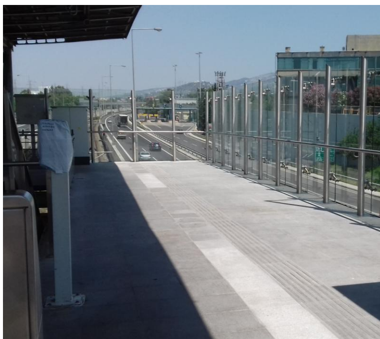
Εικόνα 37: Διαθέσιμος χώρος, σταθμός Παλλήνη
