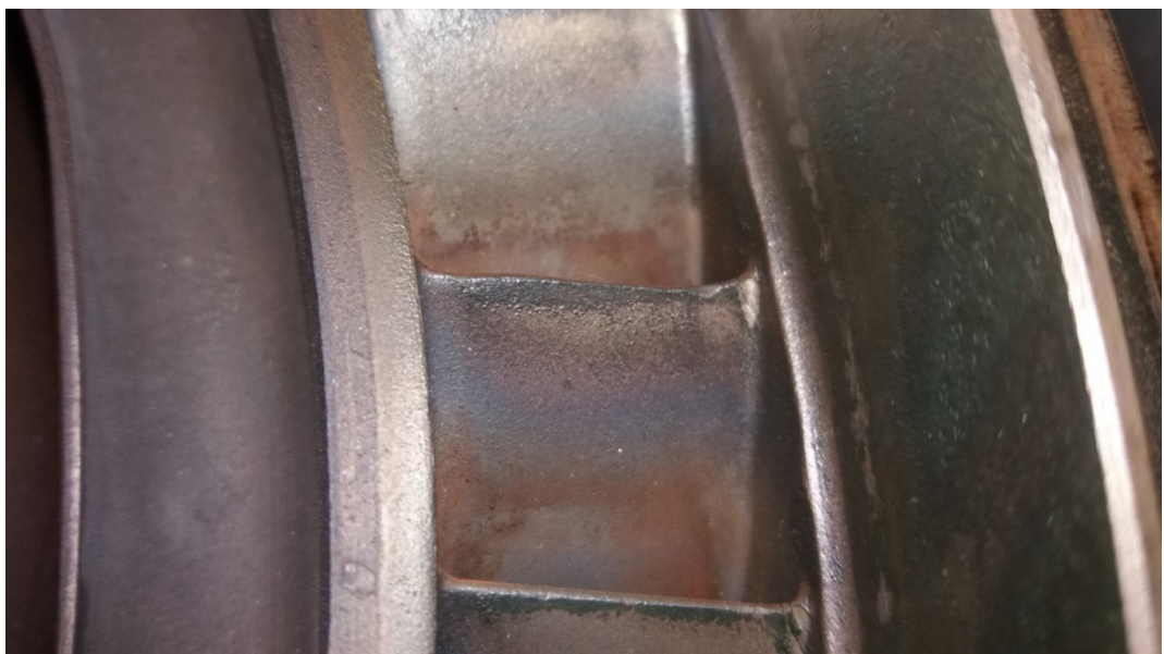
Σχ.4.16 Οξείδωση, αποχρωματισμός, απώλεια επικάλυψης, ρωγμές, αλλοίωση επιφανείας με απώλεια υλικού και επικαθήσεις στο χείλος εκφυγής των πτερυγίων.
