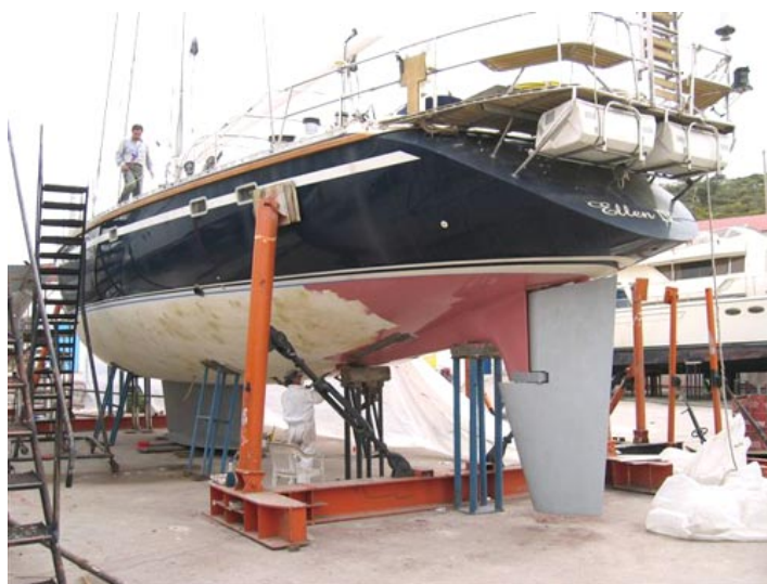
Εικόνα 61 – Στήριξη υπο κατασκευή/ μετασκευή πλαστικού σκάφους
