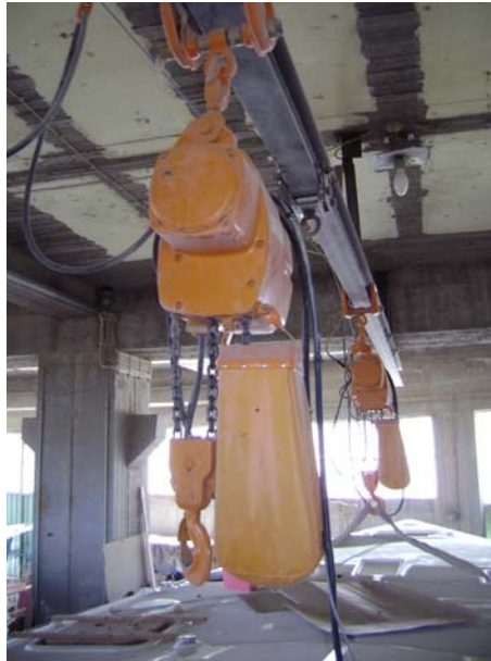
Εικόνα 63 – Ηλεκτρικό βαρούλκο ανύψωσης φορτίου
