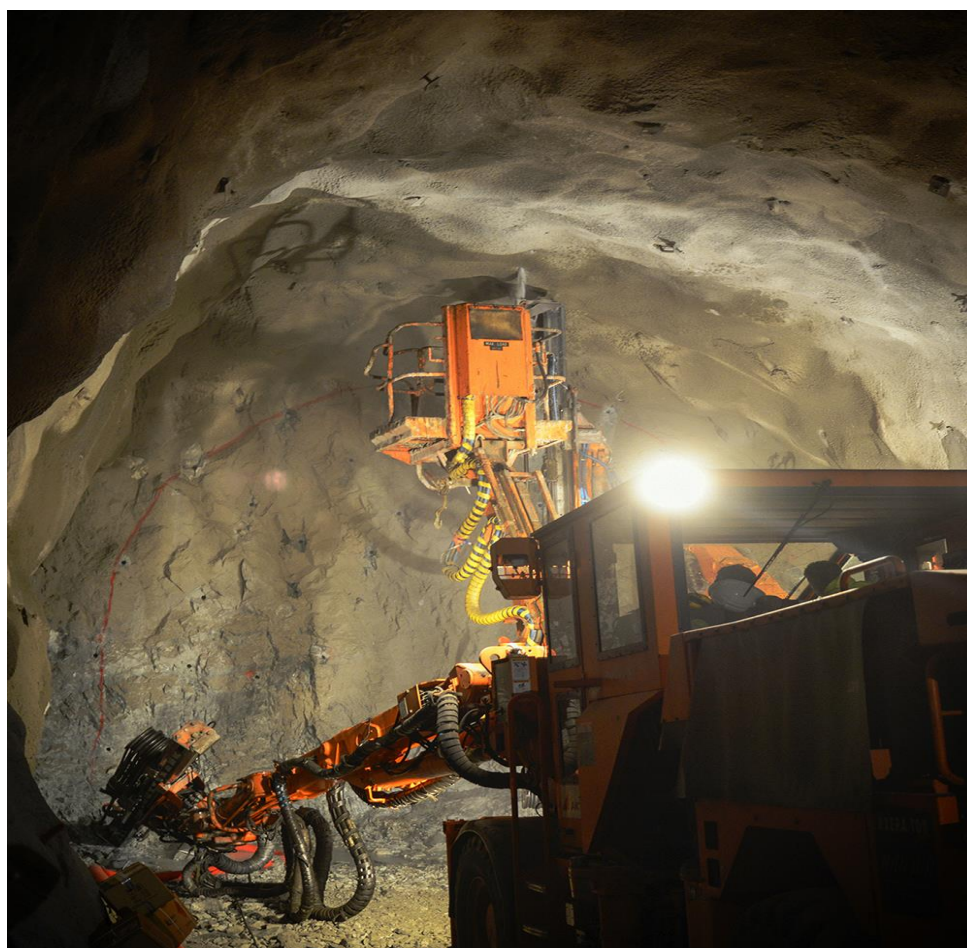
Εικόνα 4.5.: Εργασίες στο μεταλλείο Ολυμπιάδας
