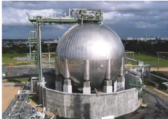
Εικόνα 1.14 : Σφαιρική δεξαμενή αποθήκευσης ΥΦΑ
