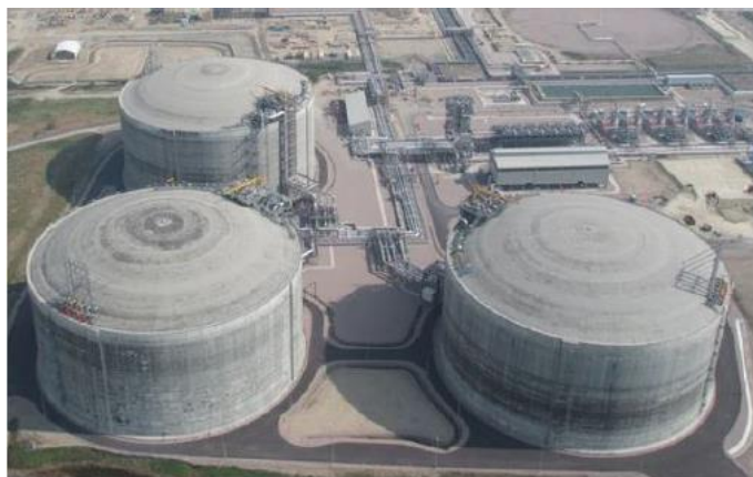
Εικόνα 1.10 : Δεξαμενή πλήρους συγκράτησης ΥΦΑ
