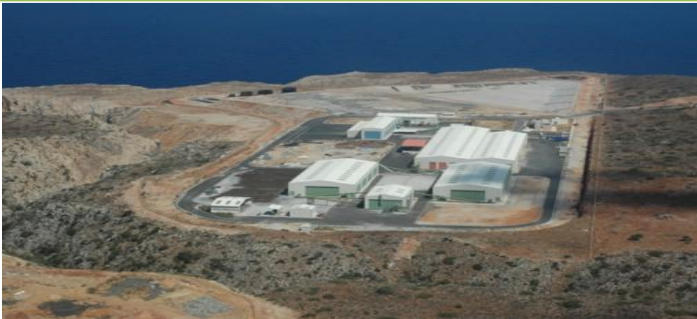
Εικόνα 3.18 Εργοστάσιο Μηχανικής Ανακύκλωσης και Κομποστοποίησης Απορριμμάτων Χανίων
