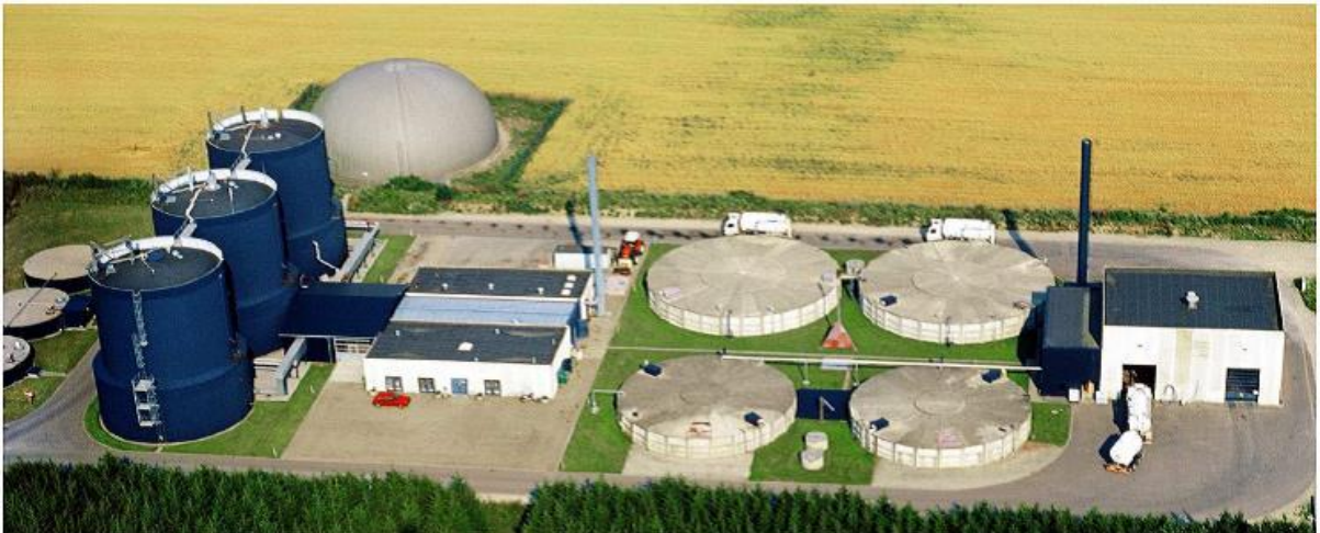
Εικόνα 1.4.2 Μονάδα βιολογικής επεξεργασίας αποβλήτων [11]
