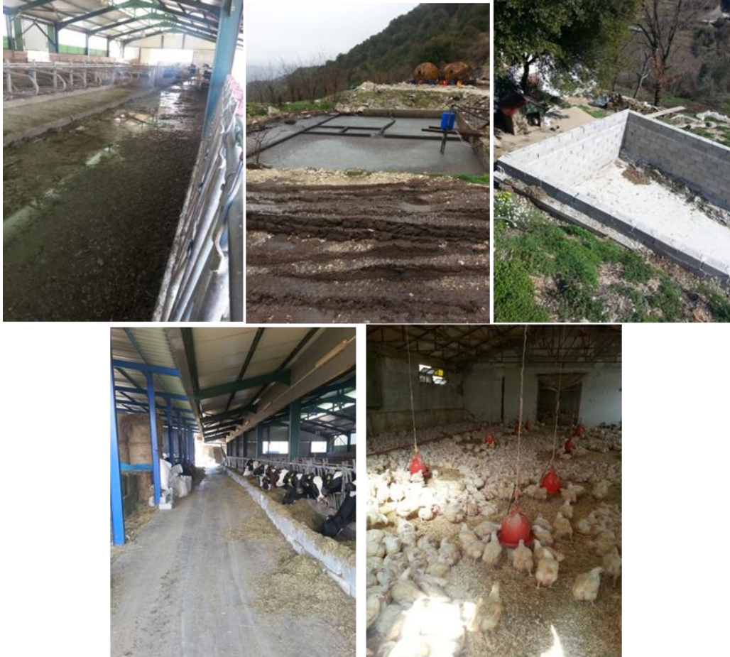
Εικόνα 6.2.1 Κτηνοτροφικές εγκαταστάσεις και διαχείριση κτηνοτροφικών αποβλήτων στην περιοχή του Μετσόβου
