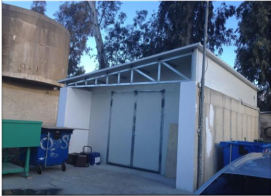
Εικόνα 7.2.4 Ειδικά διαμορφωμένος χώρος 24m 2 για τη συλλογή και επεξεργασία των ζυμώσιμων απορριμμάτων του δήμου Χαλανδρίου
