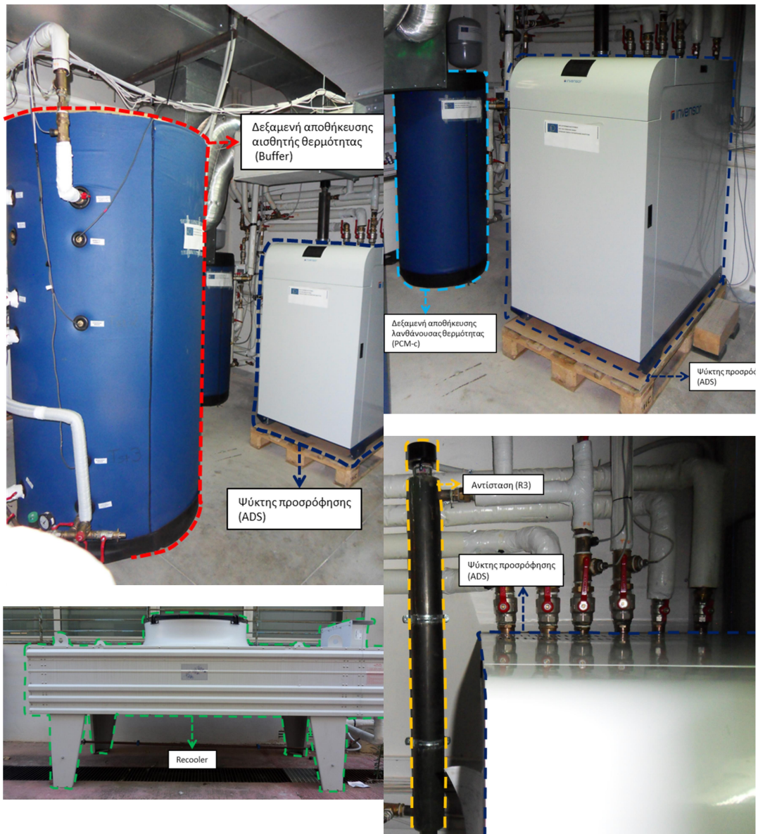
Εικόνα 6.2: Διάταξη των κυριότερων στοιχείων του συστήματος ηλιακής ψύξης στο εργαστήριο εφαρμοσμένης θερμοδυναμικής
