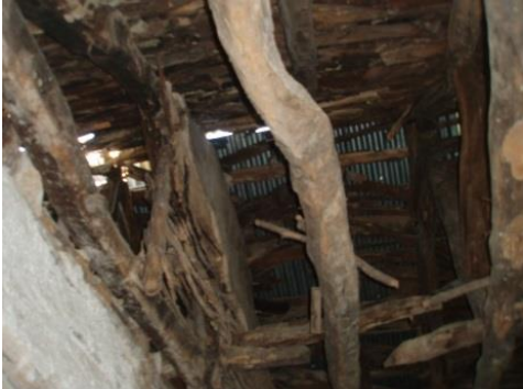
Εικόνα 4.143 - 4.144. Ξύλινο σύστημα στέγης και μπαγδατί (Ιδία λήψη)
