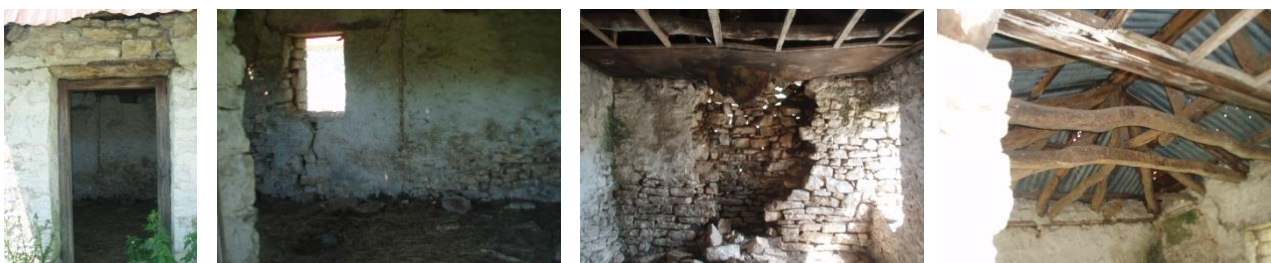
Εικόνα 4.107 - 4.110. Εξώθυρα, εσωτερικό κτιρίου και ξύλινο σύστημα στέγης (Ιδία λήψη)
