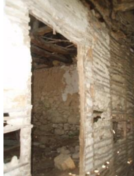
Εικόνα 4.143 - 4.144. Ξύλινο σύστημα στέγης και μπαγδατί (Ιδία λήψη)
