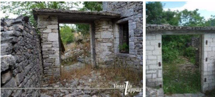
Εικόνα 4.37 - 4.38. Αυλόθυρα (Πηγή: http://klgallery.gr - Φωτογραφική λήψη του Λάππα Βασίλη — Ιδία λήψη)
