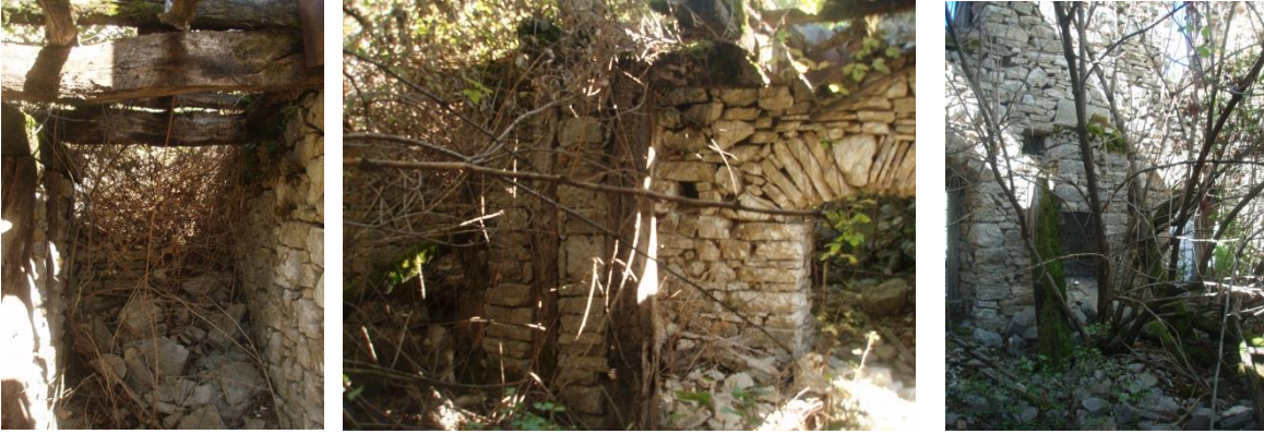
Εικόνα 4.35 - 4.36. Χώρος σάλας όπου υπήρχε η εσωτερική λίθινη κλίμακα και εστία στο επίπεδο του κατωγιού (Ιδία λήψη)
