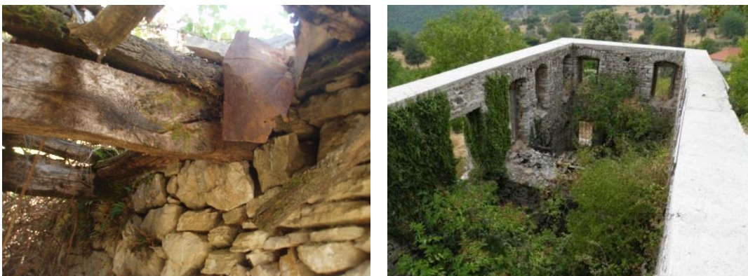
Εικόνα 4.33 - 4.34. Ίχνη ξύλινου πατώματος (Ιδία λήψη) — Εσοχή στην τοιχοποιία, στο ύψος έδρασης της στέγης, που μαρτυρά την ύπαρξη οριζόντιου ξύλινου δοκαριού (Πηγή: http://www.facebook.com - Φωτογραφική λήψη του Πουλίζου Χριστόφορου)
