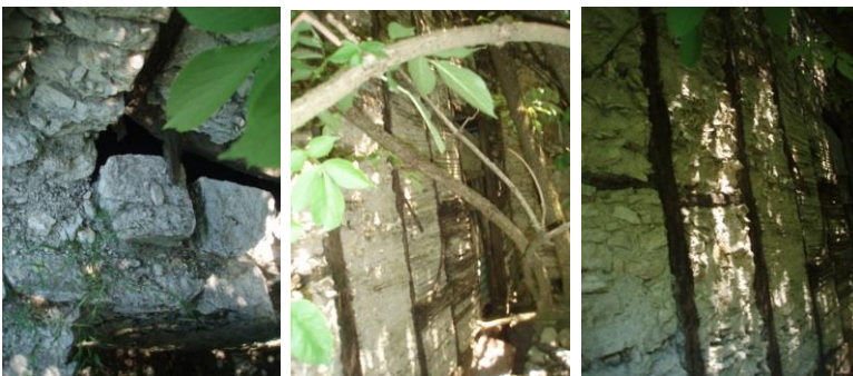
Εικόνα 4.155 - 4.157. Εσωτερικό λίθινο χώρισμα στο κατώι και μαγαδατί στο ανώι (Ιδία λήψη)
