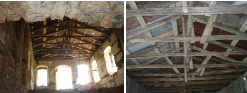
Εικόνα 4.73 - 4.74. Ξύλινο σύστημα στέγης (Ιδία λήψη)
