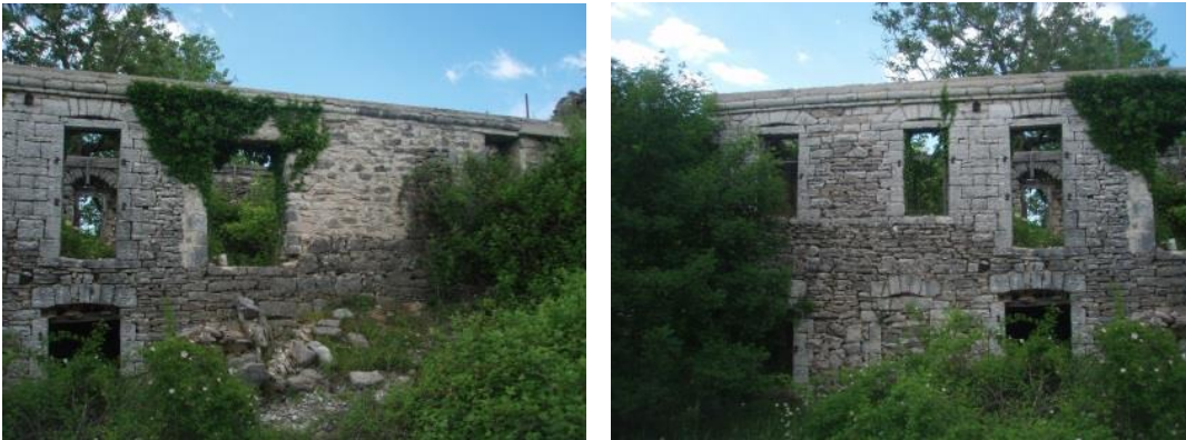
Εικόνα 4.31 - 4.32. Διαφορά στη λιθοδομή και ενίσχυσή της με μπετόν (Ιδία λήψη) — Ίχνη εξώστη και στεγάστρου (Ιδία λήψη)
