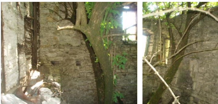
Εικόνα 4.153 - 4.154. Εσοχές στην τοιχοποιία που μαρτυρούν την ύπαρξη ξύλινου πατώματος - Εστία και εντοιχισμένος αποθηκευτικός χώρος (Ιδία λήψη)
