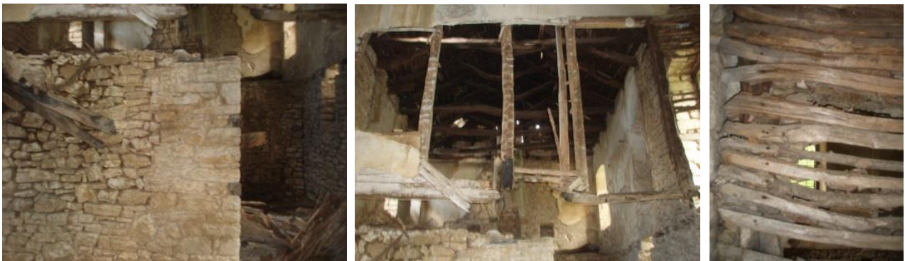
Εικόνα 4.12 - 4.14. Εσωτερικό λίθινο χώρισμα και μπαγδατί (Ιδία λήψη)
