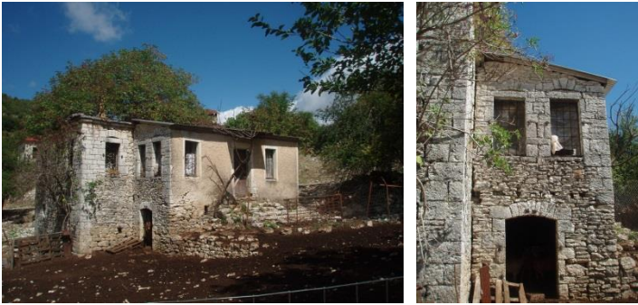
Εικόνα 4.151 - 4.152. Νοτιοανατολική και νοτιοδυτική όψη μεταγενέστερου όγκου (Ιδία λήψη)
