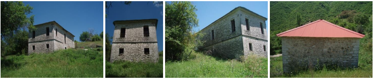
Εικόνα 4.92 - 4.95. Νοτιοανατολική, νοτιοδυτική, βορειοδυτική και βορειοανατολική όψη (Ιδία λήψη)
