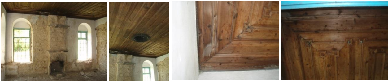
Εικόνα 4.122 - 4.125. Ξύλινο πάτωμα και ταβάνι (Ιδία λήψη)
