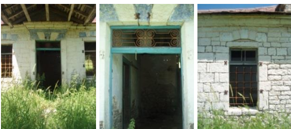
Εικόνα 4.134 - 4.136. Ανοίγματα (Ιδία λήψη)
