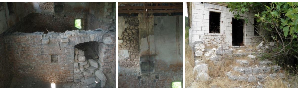
Εικόνα 4.75 - 4.77. Εσωτερικό χώρισμα, εντοιχισμένοι αποθηκευτικοί χώροι, εστία (Ιδία λήψη) — Κλίμακα (Πηγή: http://www.facebook.com - Φωτογραφική λήψη του Πουλίζου Χριστόφορου)
