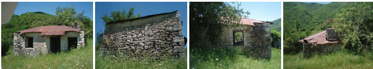
Εικόνα 4.103 - 4.106. Νοτιοανατολική, νοτιοδυτική, βορειοδυτική και βορειοανατολική όψη (Ιδία λήψη)
