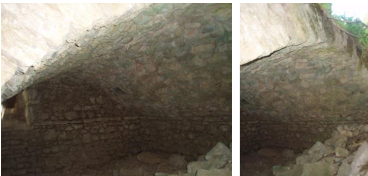
Εικόνα 4.45 - 4.46. Θολοδομία στο επίπεδο του κατωγιού (Ιδία λήψη)
