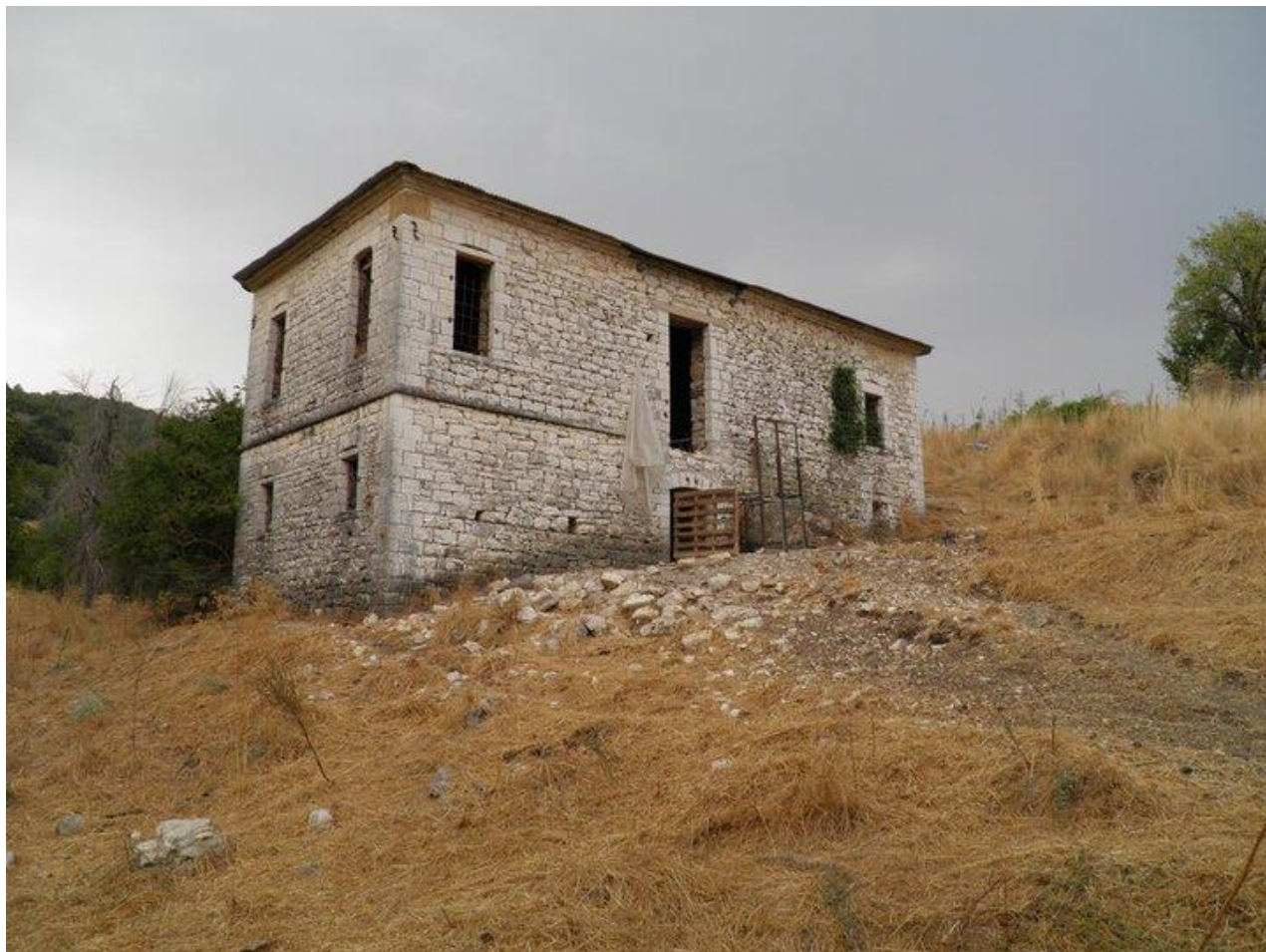
Εικόνα 4.91. Ένταξη του κτιρίου στο φυσικό περιβάλλον (Πηγή: http://www.facebook.com - Φωτογραφική λήψη του Πουλίζου Χριστόφορου)
