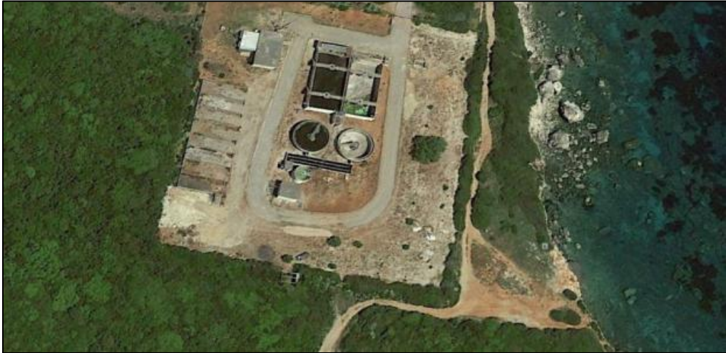
Εικόνα 22. Βιολογικός καθαρισμός δήμου Πύργου- θέση πλησίον μονάδων εκμετάλλευσης υδρογονανθράκων
