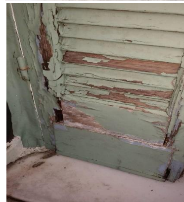
Εικόνες 2.23 Φθορές λόγω χρήσης με το πέρασμα του χρόνου
