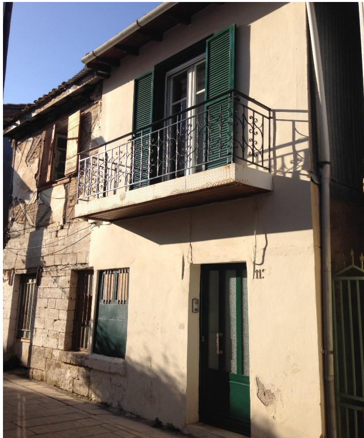
Εικόνα.2.1 Κύρια όψη παραδοσιακής οικίας στο ιστορικό κέντρο της Λευκάδας. Στο διπλανό σπίτι α διακρίνονται τα αρχικά υλικά κατασκευής, πριν τις επεμβάσεις.
