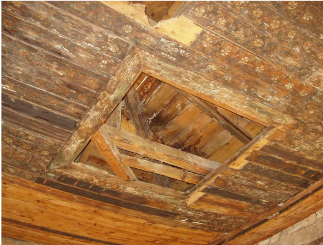
Εικόνα 1.22 Μέρος του ταβανιού του νότιου καλοκαιρινού δωματίου. Φαίνεται ο τετράγωνος κουμπές, ο οποίος έχει καταστραφεί και κάποια σχέδια σε έντονα χρώματα. Σημερινή κατάσταση (πηγή: πρωτότυπη)
