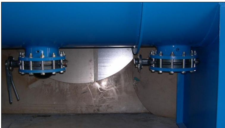
Εικόνα 5.5: Θυρίδες απόληψης βιοαντιδραστήρα
