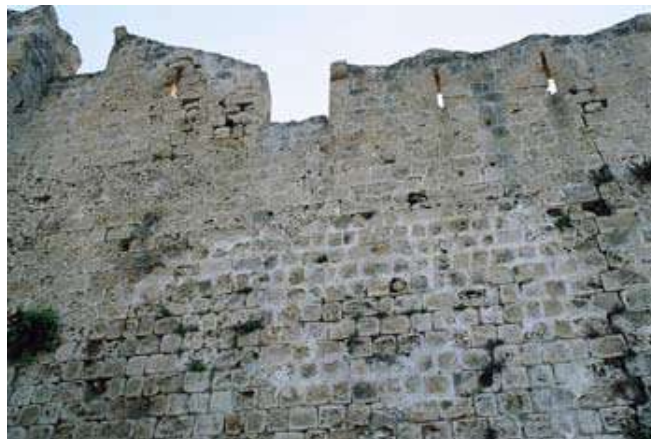
Εικόνα 1.2.2.9: Τοίχος από την Μεσαιωνική Πόλη της Ρόδου.
