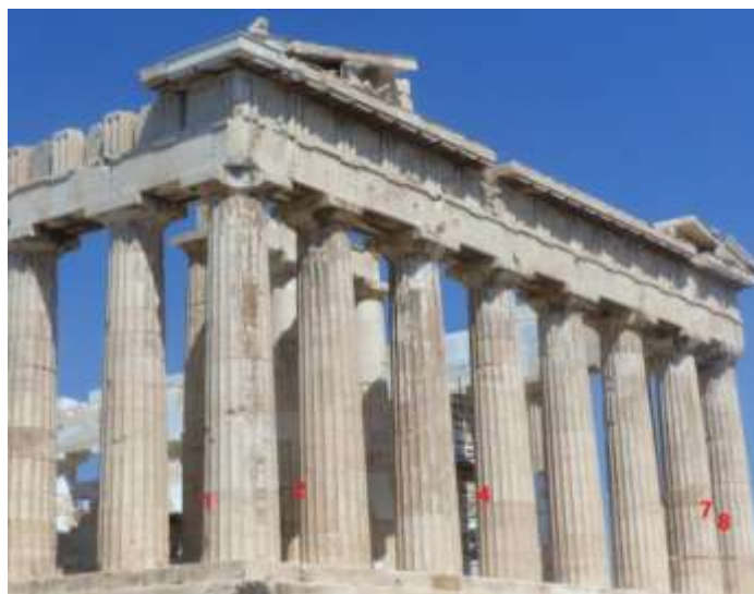
Εικόνα 5.2.1 : Κίονες επιφανειακών μετρήσεων θερμοκρασίας με αισθητήρες
