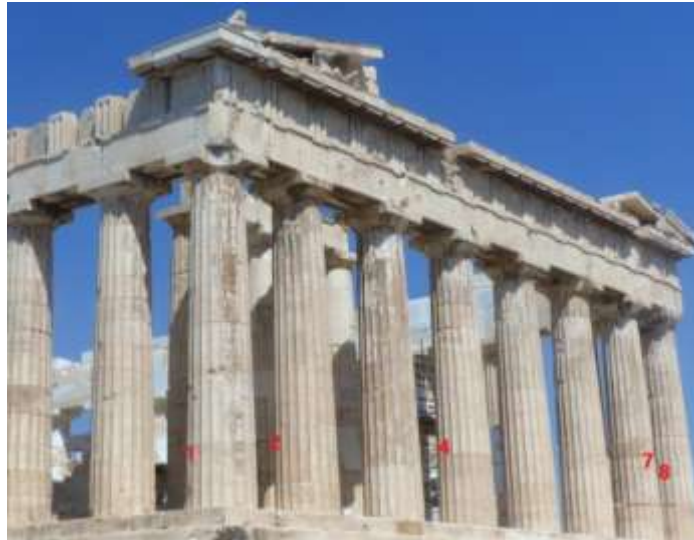
Εικόνα 4.3.5 : Κίονες επιφανειακών μετρήσεων θερμοκρασίας με αισθητήρες
