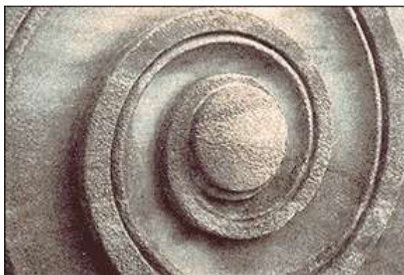
Εικόνα 1.2.2.1: Ζαχαροειδής φθορά στο Jefferson Memorial, Washington D.C.
