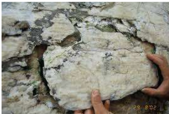
Εικόνα 1.2.2.5: Απολέπιση σε μάρμαρο (φωτογραφία από Εργαστήριο Συντήρησης Λίθου Τ.Ε.Ι. Αθήνας)
