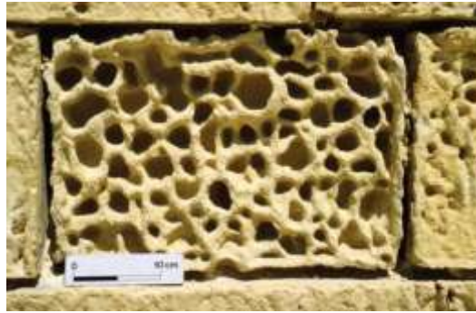
Εικόνα 1.2.2.2: Κυψελοειδής διάβρωση (Malta, Rabat-Gozo, Citadel, 1994.
