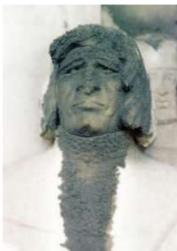
Εικόνα 1.2.2.11: Μαύρη κρούστα σε μάρμαρο Carrara (φωτογραφία από το Πανεπιστήμιο FedericoII της Νάπολης, Ιταλία)
