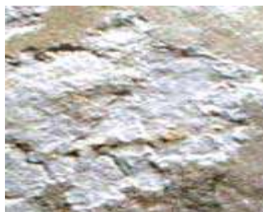
Εικόνα 1.2.2.4: Διαφορική φθορά σε μάρμαρο (Portugal, Queluz Palace, 2003)
