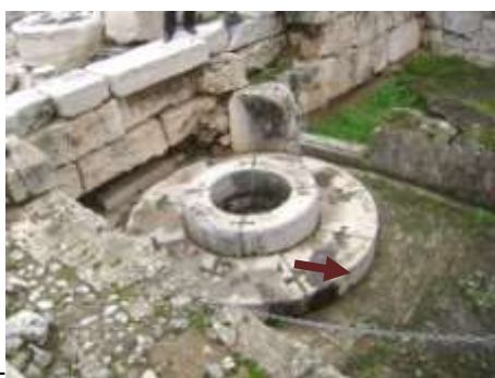
Εικόνα 1.2.2.10: Τσιμεντιτική κρούστα στον αρχαιολογικό χώρο Ελευσίνας
