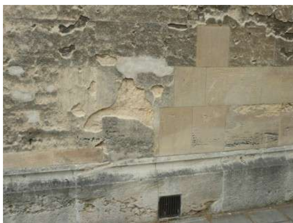
Εικόνα 1.2.2.13: Η αντικατάσταση λίθων οδήγησε στην επιτάχυνση φθοράς των παλαιότερων λίθων στο Κολλέγιο της Οξφόρδης [34]
