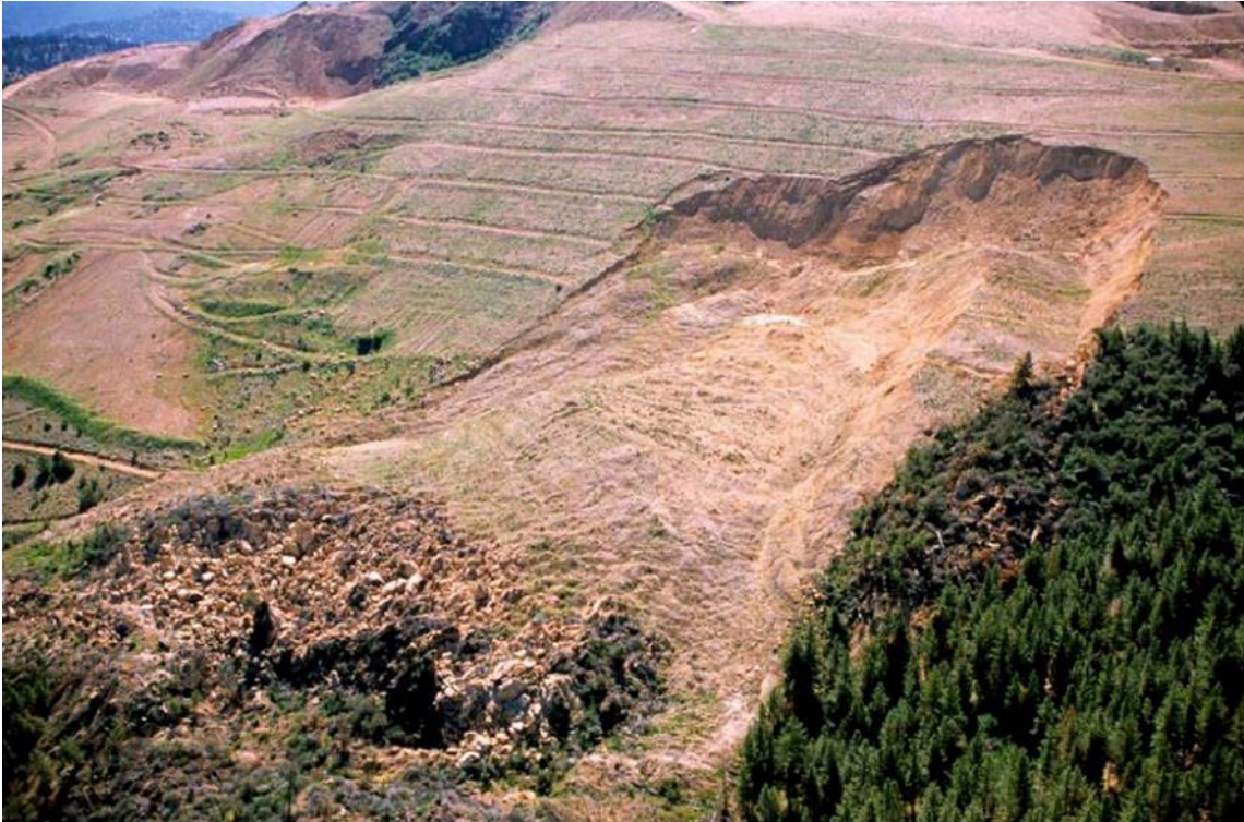
Εικόνα 1 Αστοχία Πρανούς στο Hayden Hill, California
