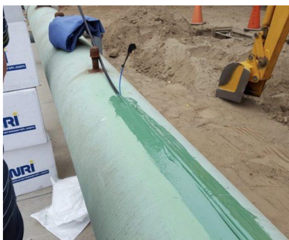
Εικόνα 25 Τοποθέτηση οπτικών ινών σε αγωγό, Πηγή: scvnews.com,
