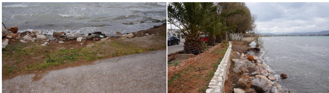
Εικόνα 4.3: Διάβρωση του παραλιακού δρόμου στο σημείο 2 της περιοχής μελέτης
