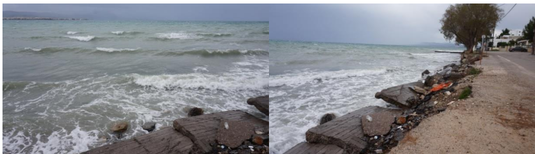
Εικόνα 4.2: Κατάρρευση προστατευτικών τοιχίων κατά μήκος του παραλιακού δρόμου
