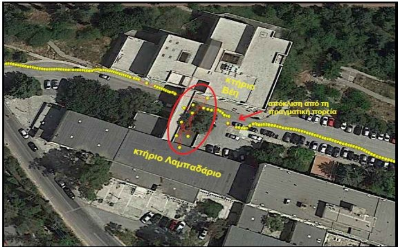
Εικόνα 4.5 Σφάλματα κάτω από τη γέφυρα της ΣΑΤΜ Πηγή: [Google Earth]
