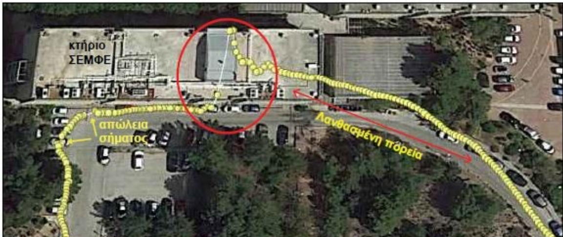
Εικόνα 4.11 Σφάλματα μπροστά από παλαιό το κτήριο της ΣΕΜΦΕ Πηγή: [Google Earth]
