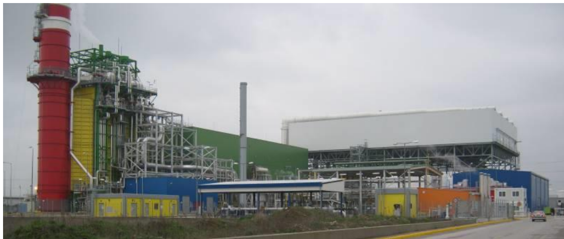
Σχήμα 2-14 Εργοστάσιο ΗΡΩΝ II Θήβα
