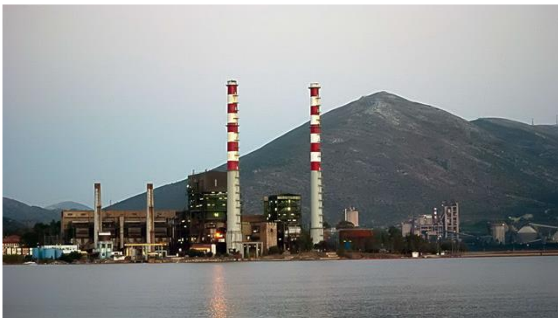
Σχήμα 2-3 ΔΕΗ Εύβοιας στο Αλιβέρι
