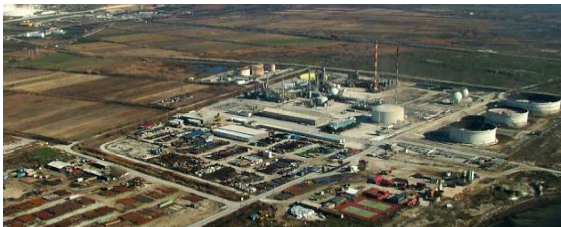
Σχήμα 2-17 ΚΑΒΑΛΑ ΟΪΛ Εργοστάσιο ΣΙΓΜΑ
