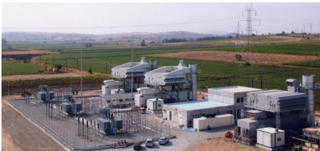
Σχήμα 2-13 Εργοστάσιο ΗΡΩΝ I - Θερμοηλεκτρική
