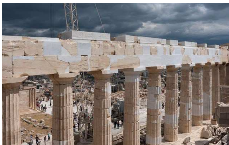
Εικ. 6. Τμήμα της βόρειας πλευράς του Παρθενώνα, από το εσωτερικό του μνημείου, μετά την αναστήλωση.
