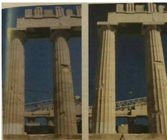
Εικ. 7. Νέο μάρμαρο, σε σπόνδυλο του πέμπτου κίονα της νότιας πλευράς του Παρθενώνα πριν και μετά την τεχνητή πάτινα.
