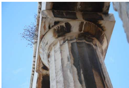
Εικ. 4. Σχηματισμός μαύρης κρούστας στην επιφάνεια του μαρμάρου.
