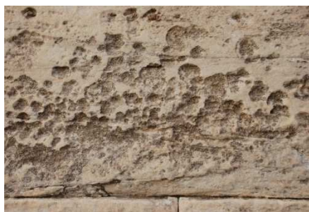
Εικ.2. Κυψελοειδής φθορά από βιολογική δράση.
