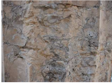
Εικ. 5. Εφαρμογή κονίας Meyer.
