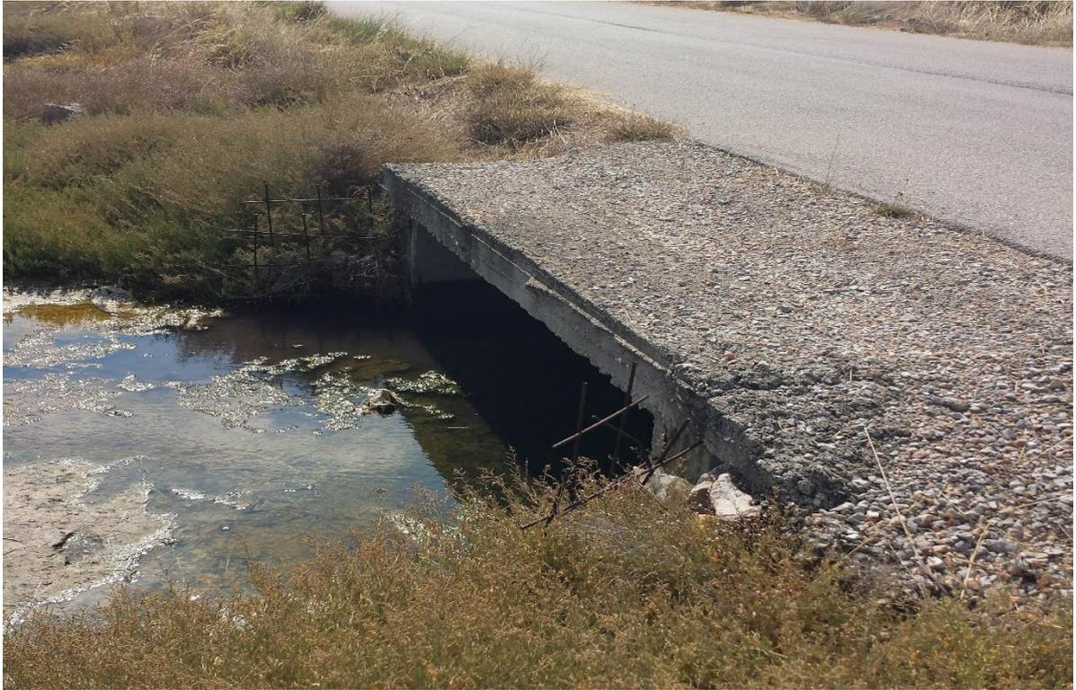
**Εικόνα 4.4:** Όψη σχετού όμβριων υδάτων ορθογωνικής διατομής
