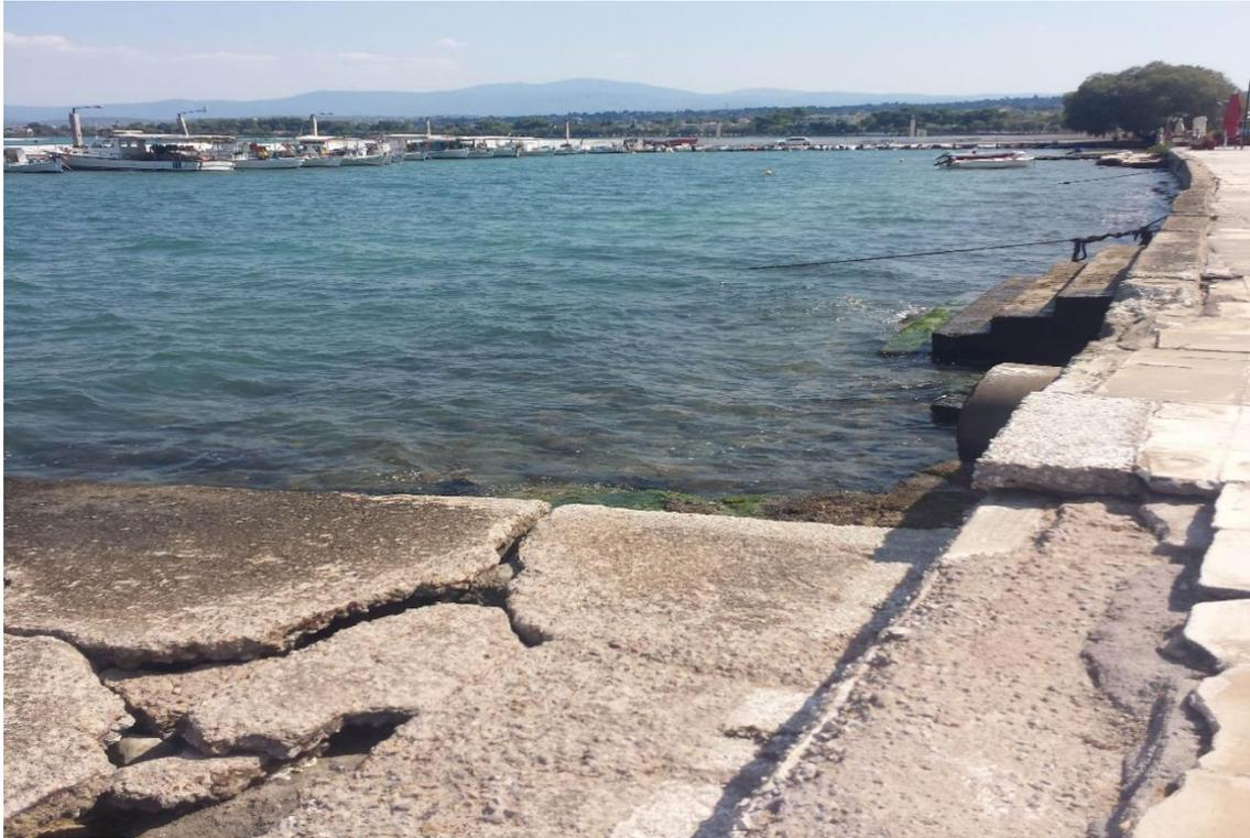
**Εικόνα 4.19:** Καθίζηση κρηπιδωμάτων και όψη του λιμενοβραχίονα Αυλίδας
