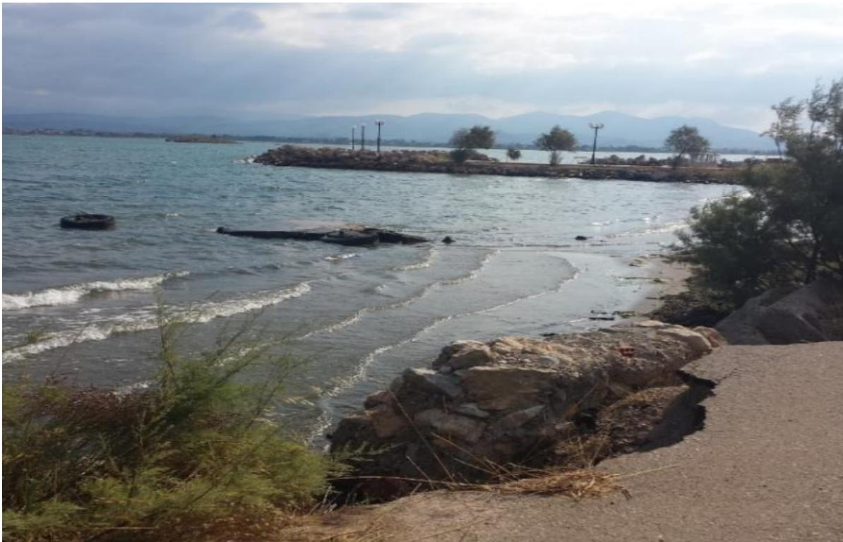
**Εικόνα 4.1:** Όψη του προσήνεμο μόλου του λιμενίσκου και εμφανής η επίδραση της κυματικής δράσης στη διάβρωση του παραλιακού μετώπου.
