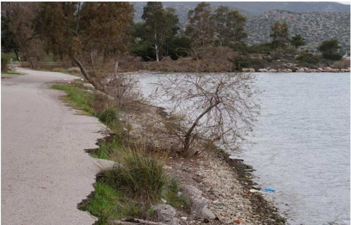
**Εικόνα 4.3:** Φθορά του οδοστρώματος εξαιτίας της διάβρωσης
