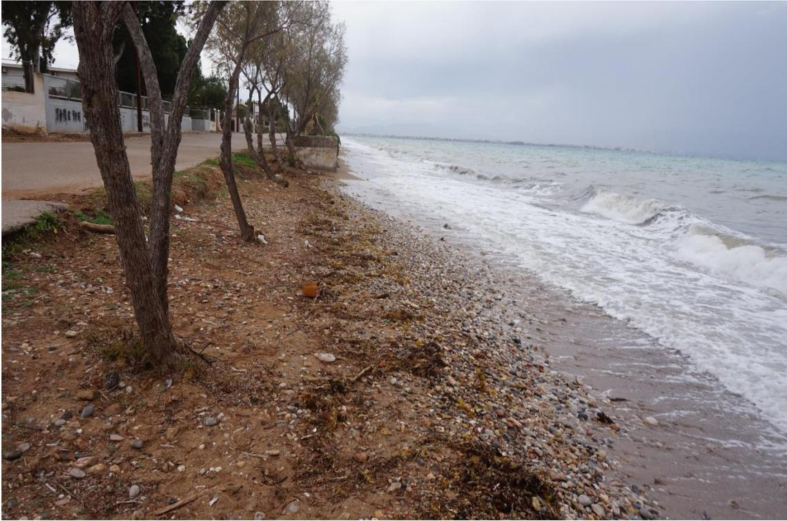
**Εικόνα 4.25:** Όψη παραλιακού μετώπου. Σημεία διάβρωσης στο μέτωπο του παραλιακού δρόμου
