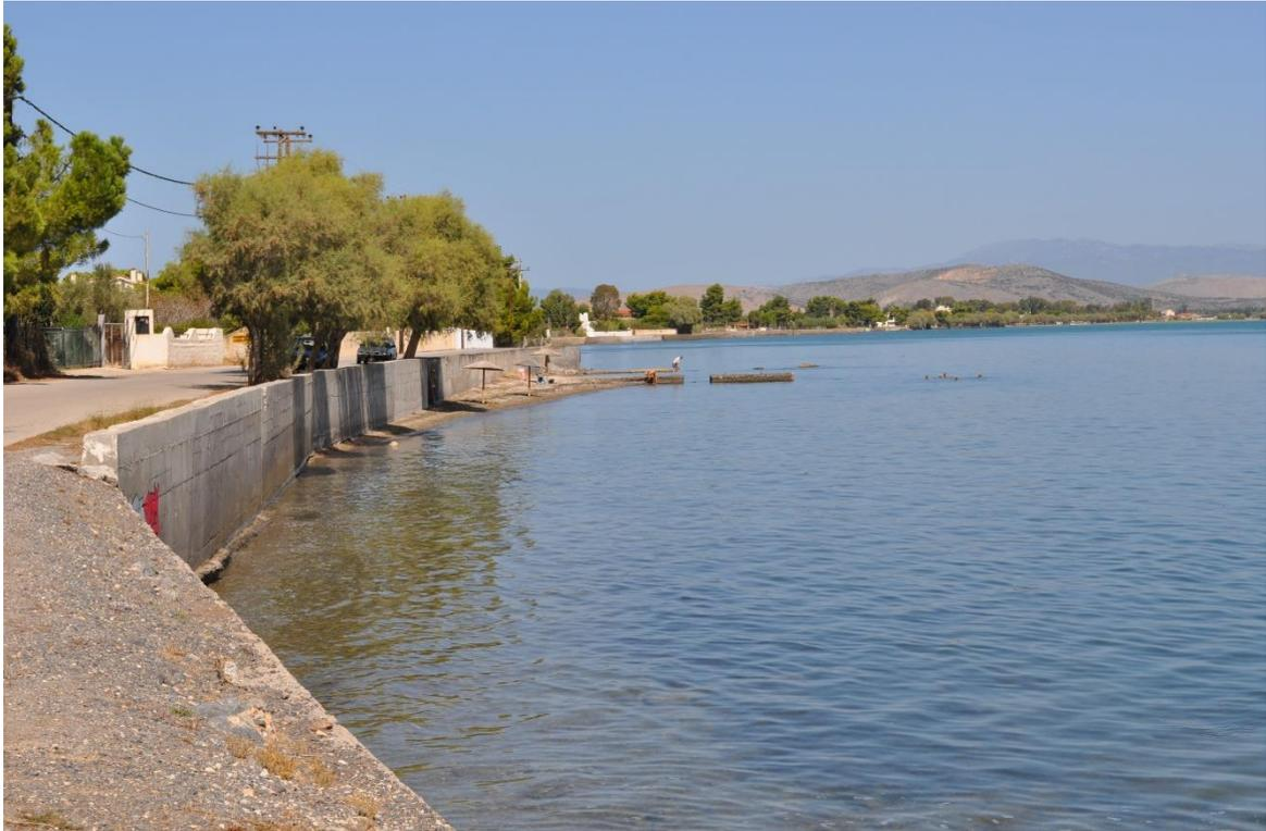
**Εικόνα 4.9:** Κατασκευή προστατευτικού ανακλαστικού τοιχίου
