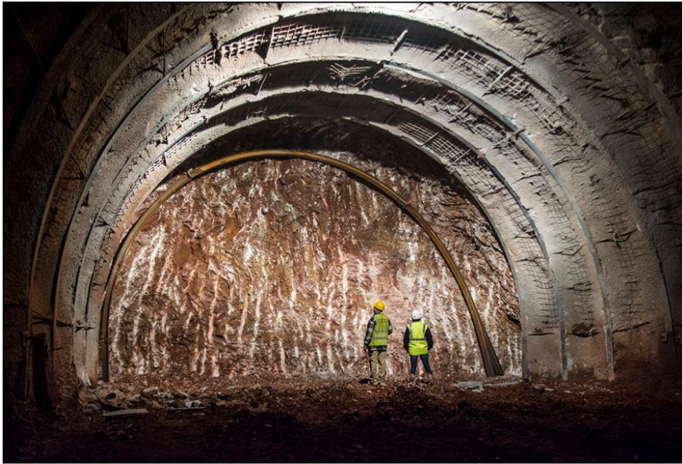
Εικόνα 4.3 (Τοποθέτηση Μεταλλικού Πλαισίου)
