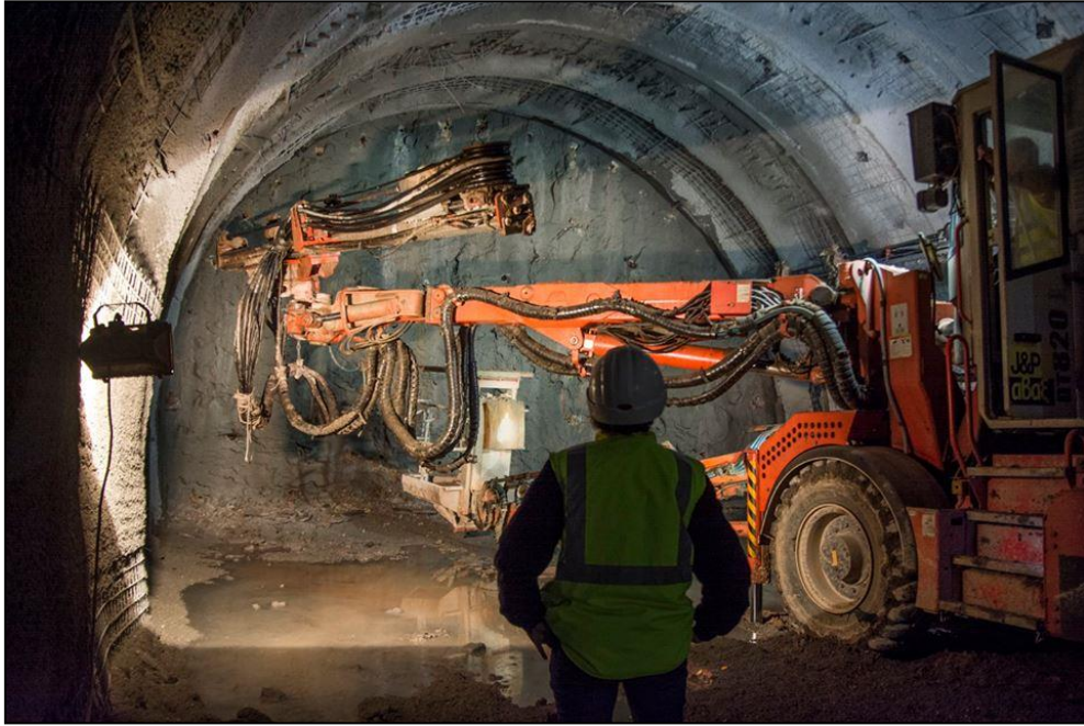
Εικόνα 4.4 (Διάτρηση για Αγκύρωση)
