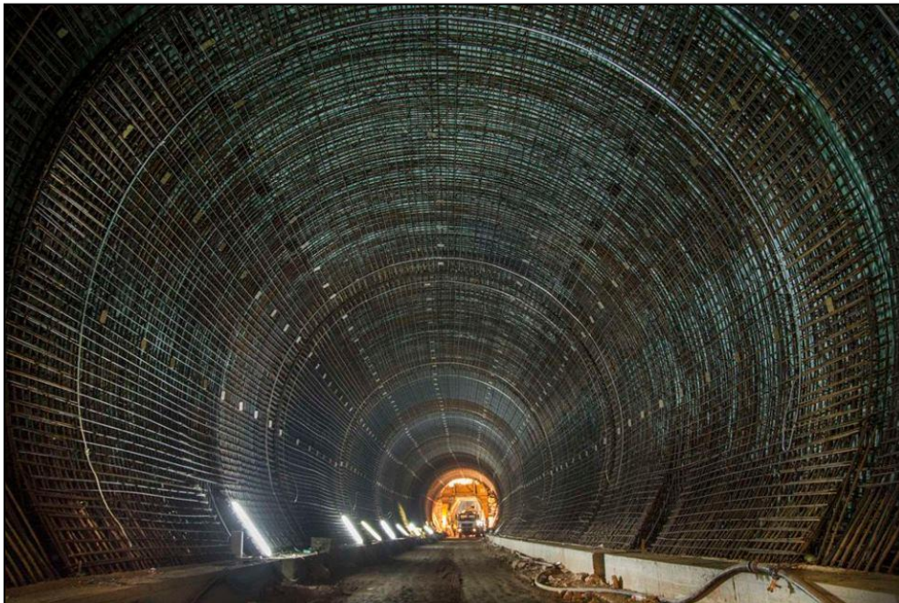
Εικόνα 4.8 (Τοποθέτηση Οπλισμού στην Σήραγγα)
