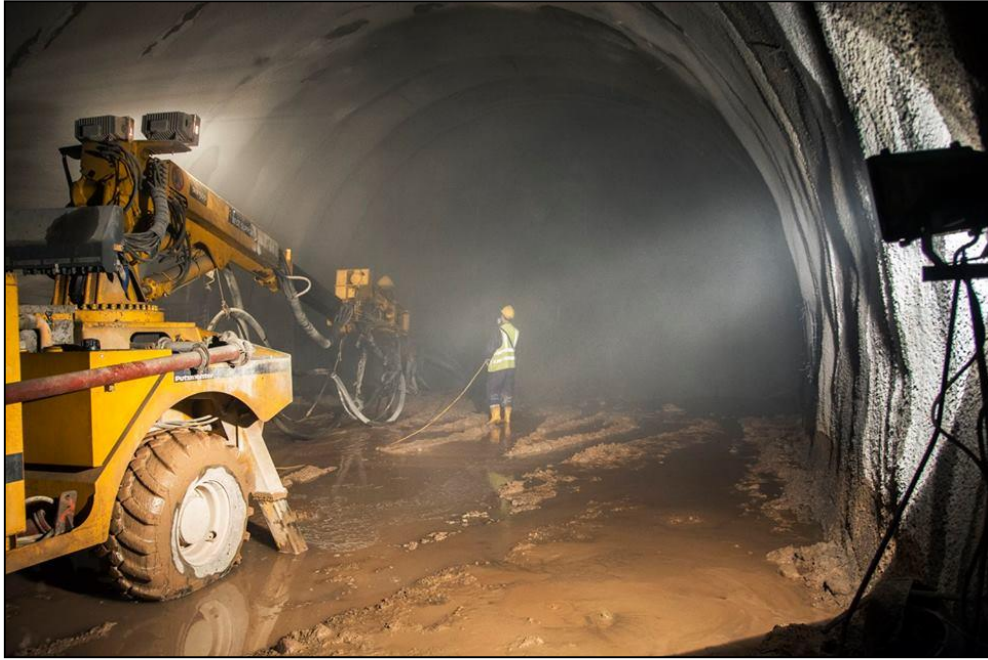
Εικόνα 4.2 (Τοποθέτηση Εκτοξευόμενου Σκυροδέματος)
