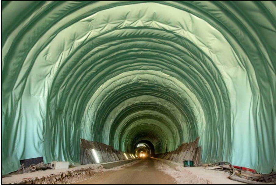
Εικόνα 4.7 (Υδατοστεγάνωση Σήραγγας)
