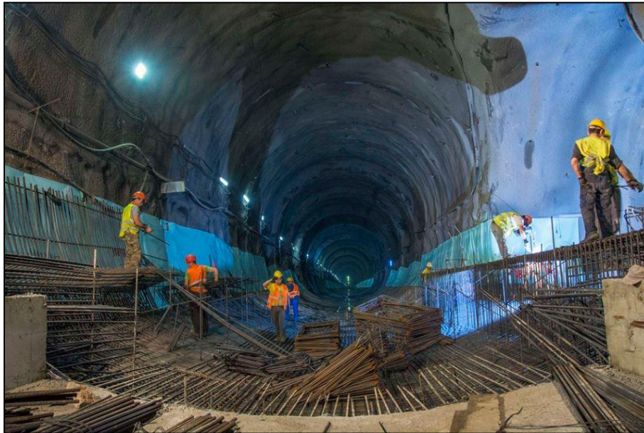
Εικόνα 4.6 (Τοποθέτηση Οπλισμού στο Invert)
