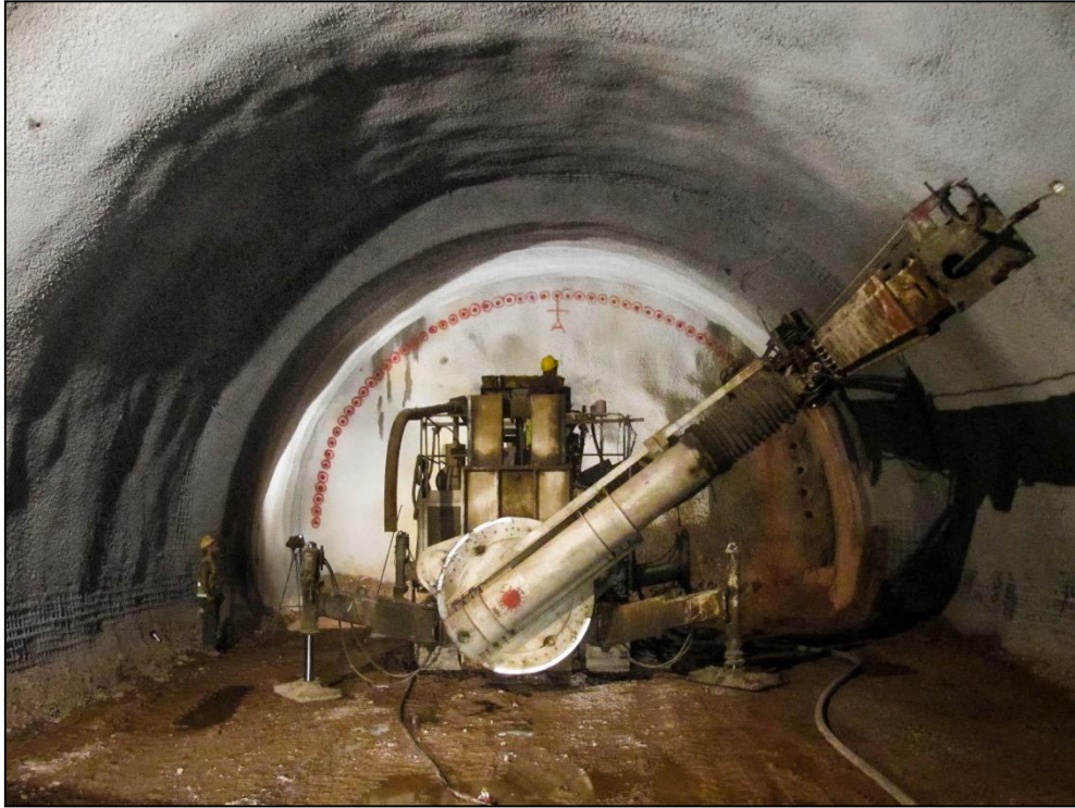
Εικόνα 4.5 (Διάτρηση για Κατασκευή Forepoling)
