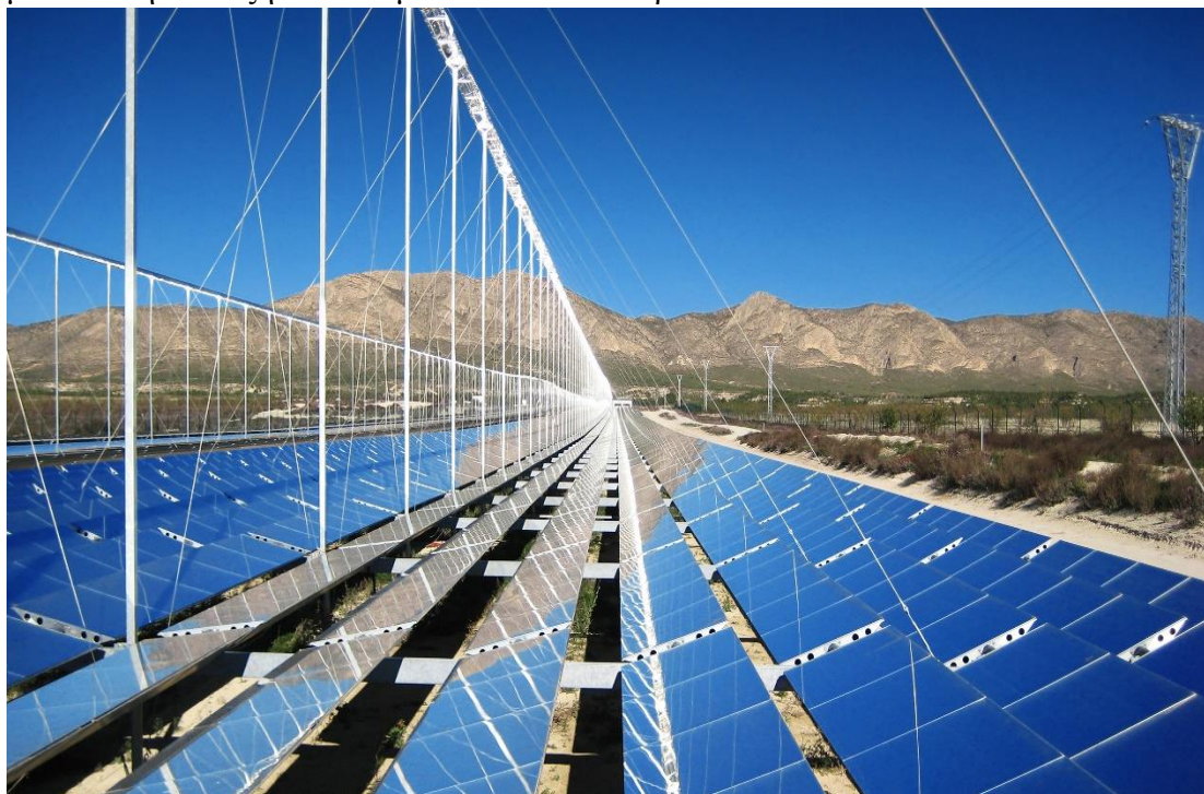
Εικόνα 3.1 Συλλέκτης Fresnel χωρίς δευτερεύον κάτοπτρο [3.1]
