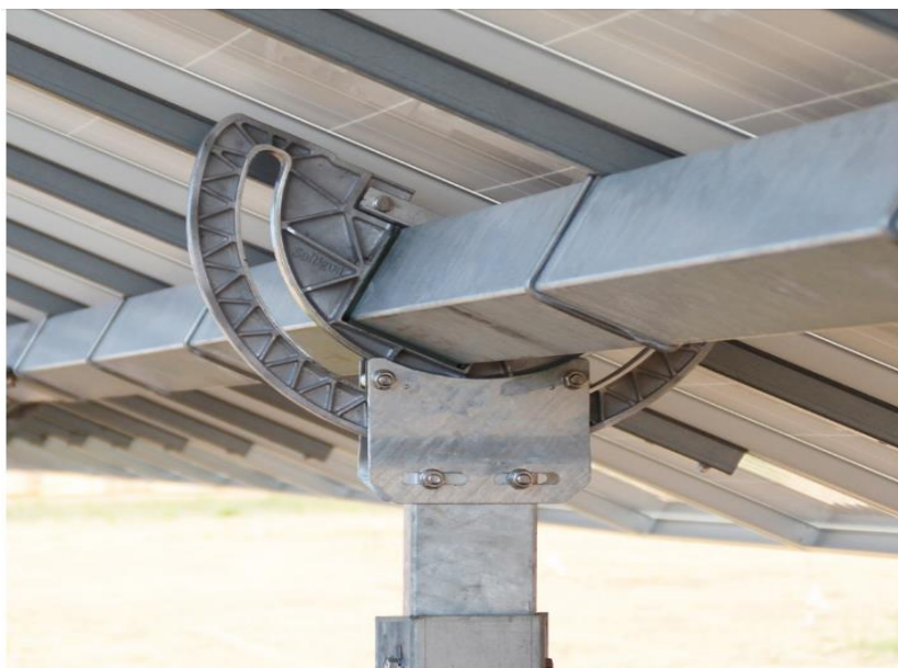
Εικόνα 3.11 Μηχανισμός tracking, iTracker της Soltigua [3.14]
