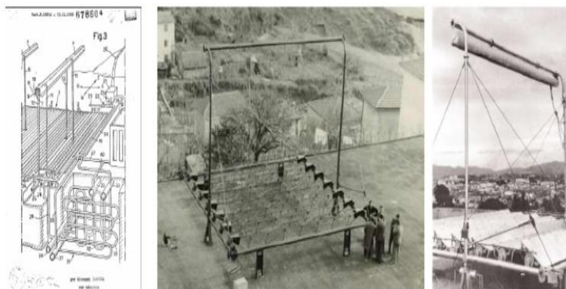
Εικόνα 3.6 Ο πειραματικός συλλέκτης του Francia, Τζένοα, 1960 [3.10]
