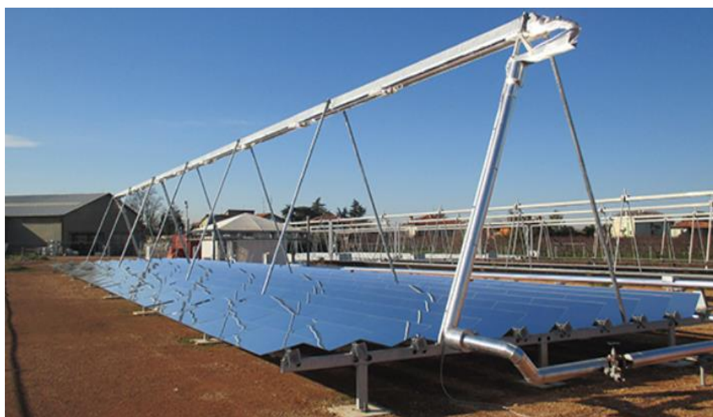
Εικόνα 3.10 Συλλέκτης Fresnel FLT10v-48, Soltigua [3.14]
