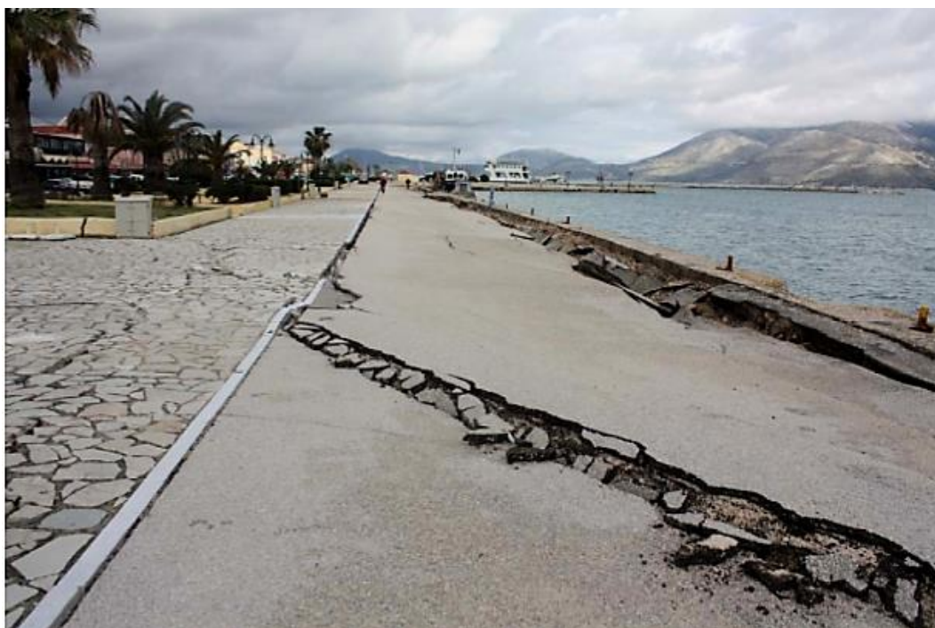
Σχήμα 3.8 (γ) : Γενική αστοχία του εδάφους λόγω μεγάλης μετακίνησης ή/και στροφής των κρηπιδοτοίχων.
