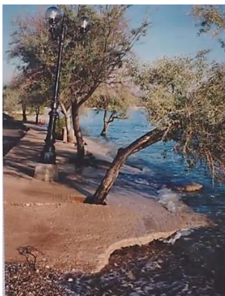
Σχήμα 1.16: Εμφάνιση πλευρικής εξάπλωσης κατά την ρευστοποίηση του εδάφους στον σεισμό του Αιγίου (1995).
