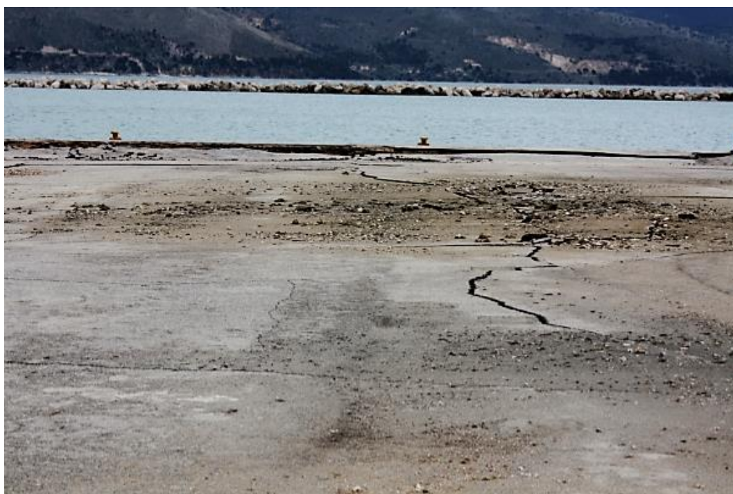
Σχήμα 3.8 (ε) (συνέχεια) : Ενδείξεις πιθανής ρευστοποίησης σε διάφορα σημεία εντός της λιμενικής περιοχής.
