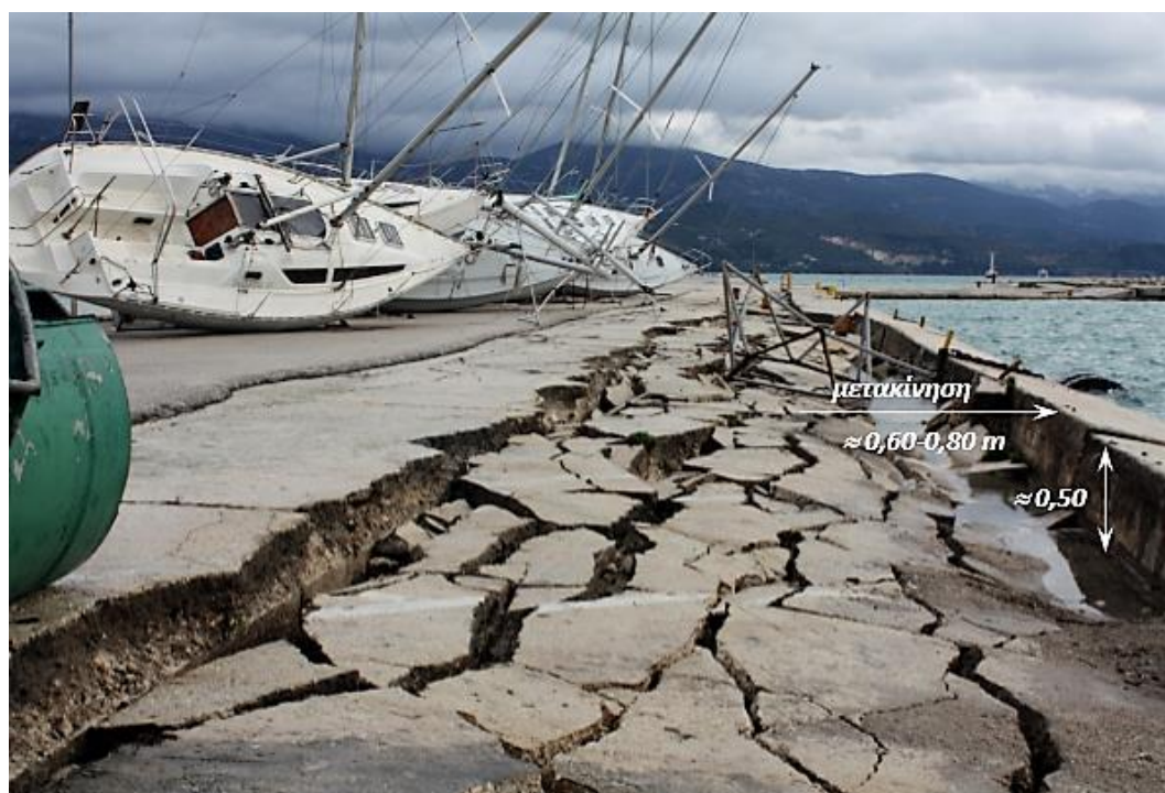
Σχήμα 3.8 (β) : Οριζόντιες μετακινήσεις μέχρι 60-80 cm λόγω στροφής και ολίσθησης των κρηπιδοτοίχων.
