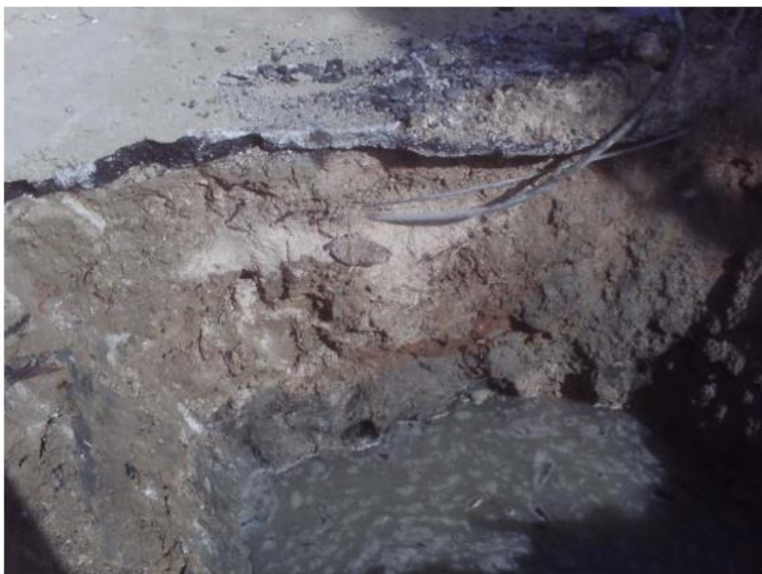
Σχήμα Α.1: Άποψη των υλικών από τα οποία έχουν κατασκευαστεί οι επιχώσεις των χερσαίων χώρων του λιμένα (σε μεγάλο ποσοστό από τα υλικά των κατεδαφίσεων των σεισμών του 1953). (Υλικό από την έρευνα της εταιρείας ΓΕΩΣΥΜΒΟΥΛΟΙ Ε.Π.Ε στην περιοχή)
