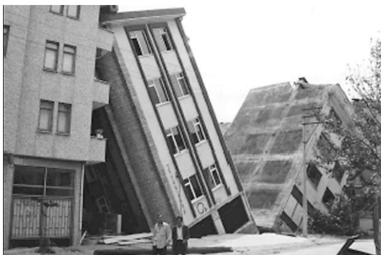
Σχήμα 1.17: Ανατροπή κτιρίων εξαιτίας της ρευστοποίησης του εδάφους στη Niigata (1964) (πάνω) και στο Ανταπαζάρι (1999) (κάτω).
