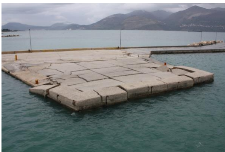
Σχήμα Β.2: Αστοχίες στο βόρειο υπήνεμο μόλο – πρόβολος εντός της λιμενολεκάνης (τμήμα Ε – Ζ – Η – Θ).
