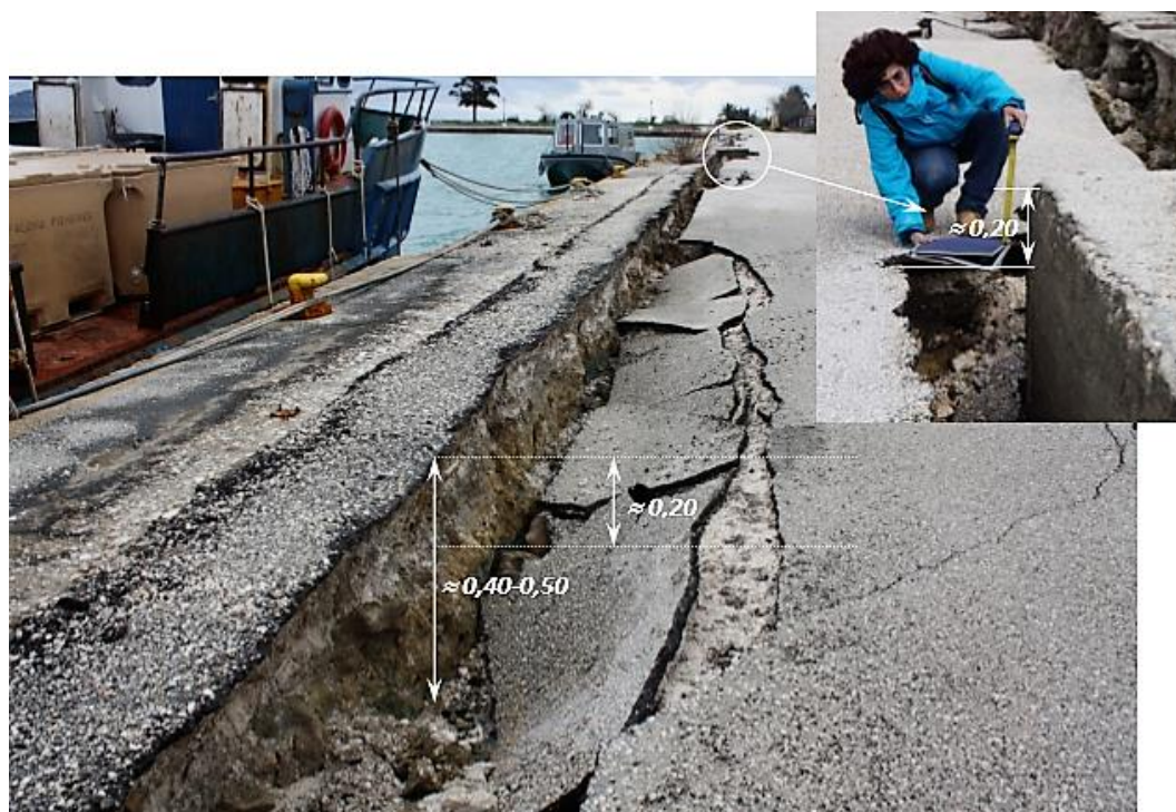
Σχήμα 3.8 (δ) : Καθιζήσεις όπισθεν κρηπιδοτοίχων
