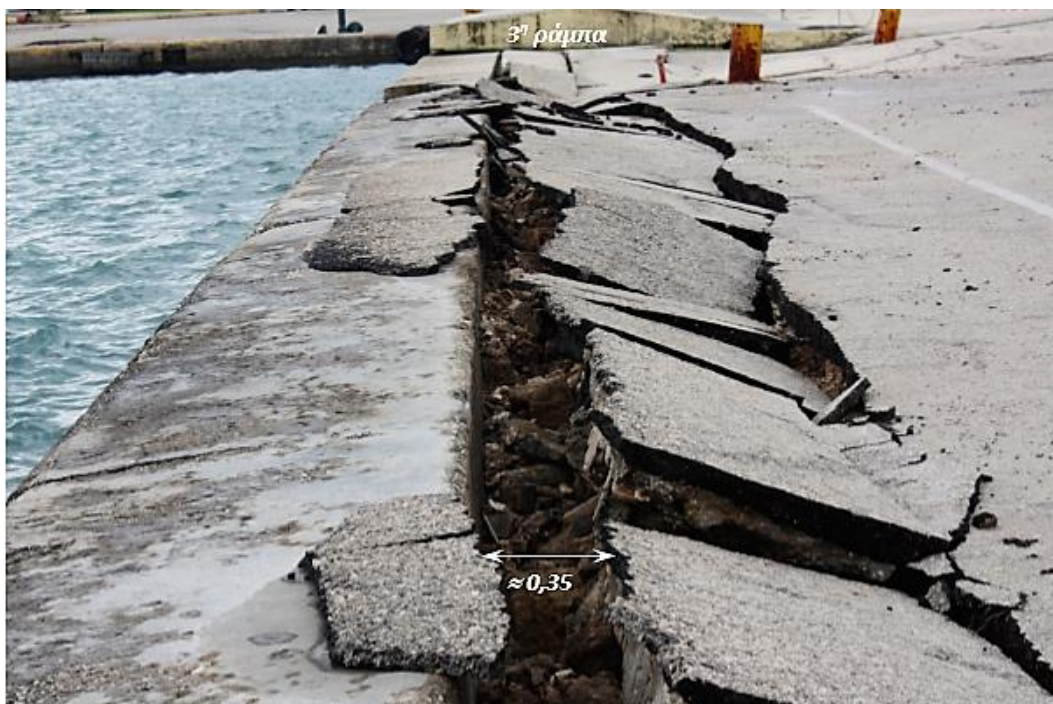
Σχήμα 3.8 (α) : Οριζόντιες μετακινήσεις του κρηπιδότοιχου της τάξεως των 35 cm λόγω ολίσθησης.
