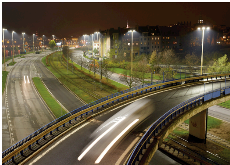
Εικόνα 4.2: Άποψη της νέας εγκατάστασης οδοφωτισμού σε δρόμο του Szczecin.
