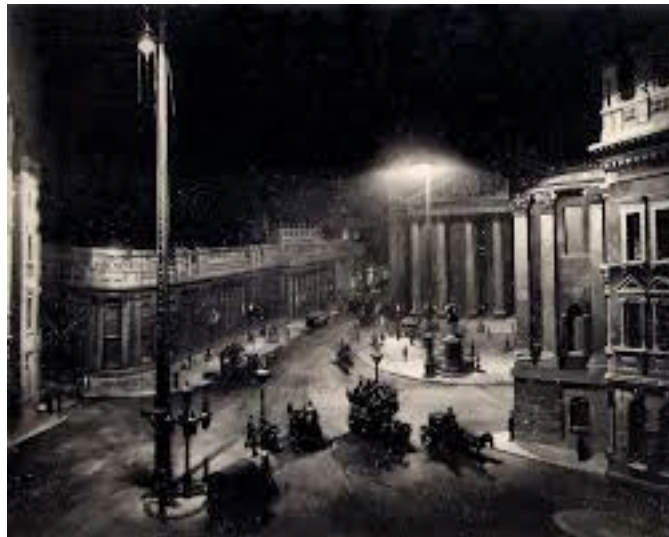
Εικόνα 2.2: Ηλεκτρικός φωτισμός, Λονδίνο 1881. [4]
