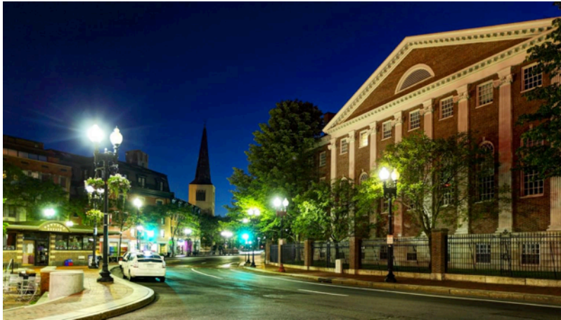
Εικόνα 4.1: Άποψη της νέας εγκατάστασης οδοφωτισμού σε δρόμο του Cambridge
