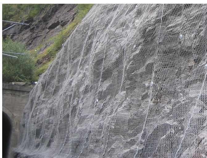
Εικόνα 2.17: Μεταλλικό πλέγμα συγκράτησης βραχοτεμαχίων
