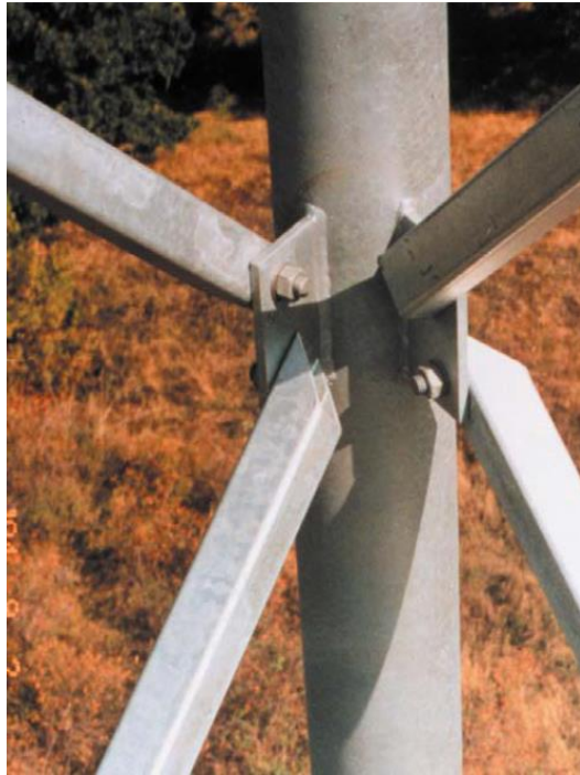
Σχήμα 4.9: Σύνδεση των συνδέσμων με τους ορθοστάτες [Andersen, 2002]
