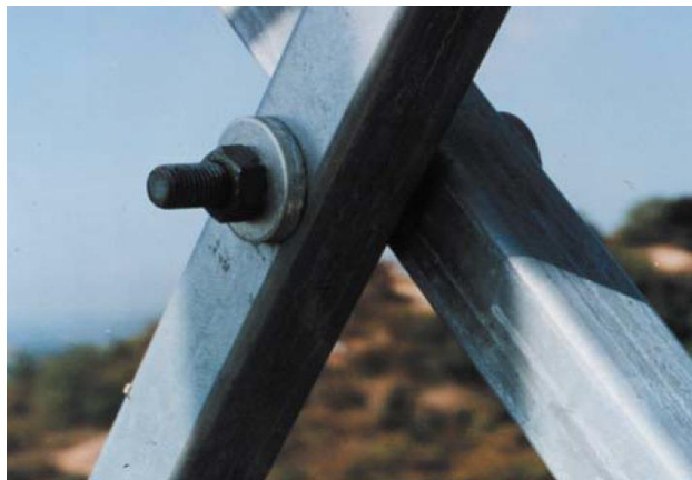
Σχήμα 4.10: Σύνδεση των χιαστί συνδέσμων στο σημείο τομής τους [Andersen, 2002]
