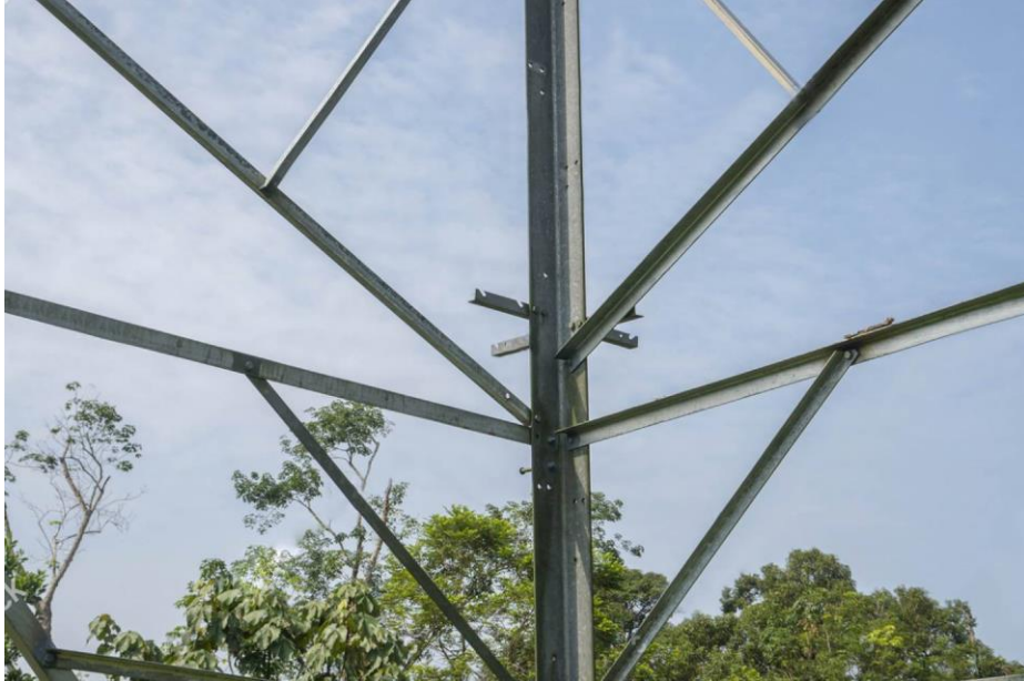
Σχήμα 3.5: Σύνδεση συνδέσμων με τους ορθοστάτες με την χρήση ενός κοχλία
