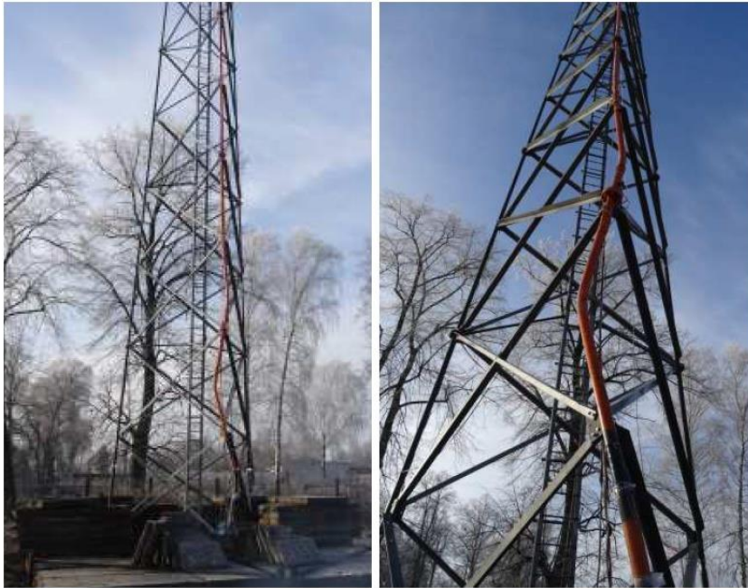
Σχήμα 4.2: Λυγισμός υποστυλώματος κυκλικής διατομής [Szafran, 2016]
