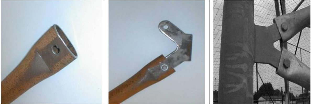
Σχήμα 4.16: Διαγώνιοι κυκλικής διατομής με μερικώς συμπίεσμένες άκρες [Andersen, 2017]
