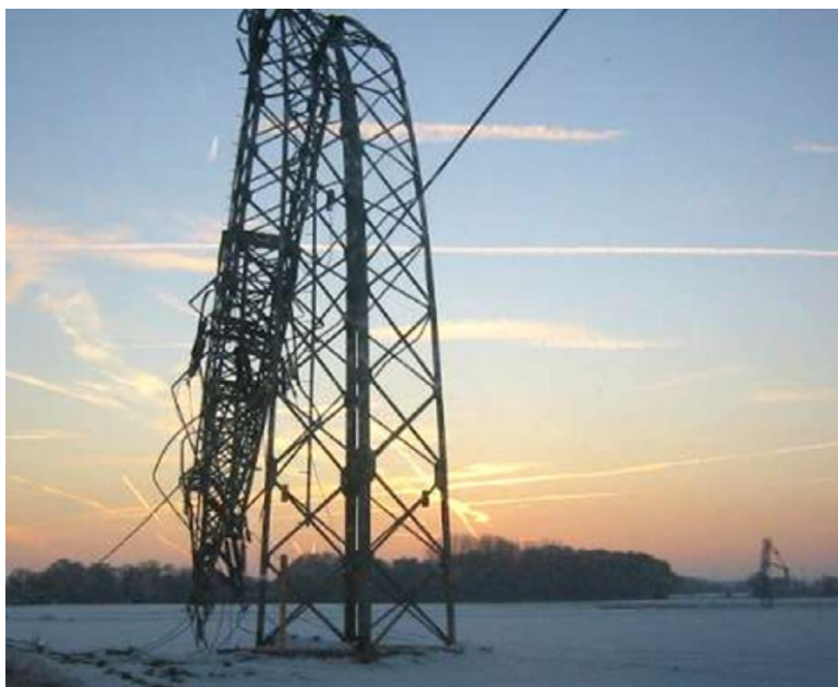
Σχήμα 1.2: Παράδειγμα κατάρρευσης πυλώνα από φόρτιση ανέμου με την συνύπαρξη παγετού [Klinger, 2011]
