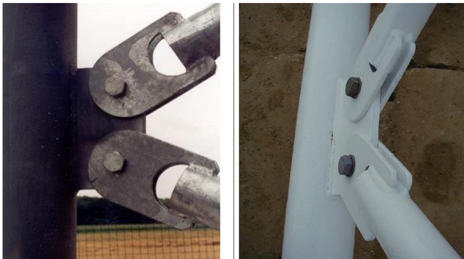
Σχήμα 4.15: Συνήθης τρόπος σύνδεσης χιαχτί συνδέσμων με ορθοστάτες, και τα δύο κυκλικής διατομής [Andersen, 2017]
