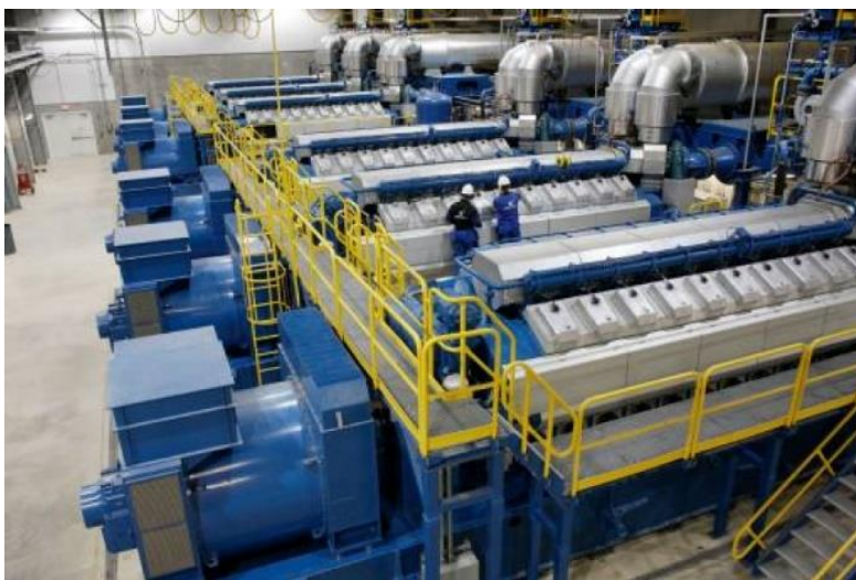
Εικόνα 3.4: Σύστοιχία GenSets, www.abb.com
