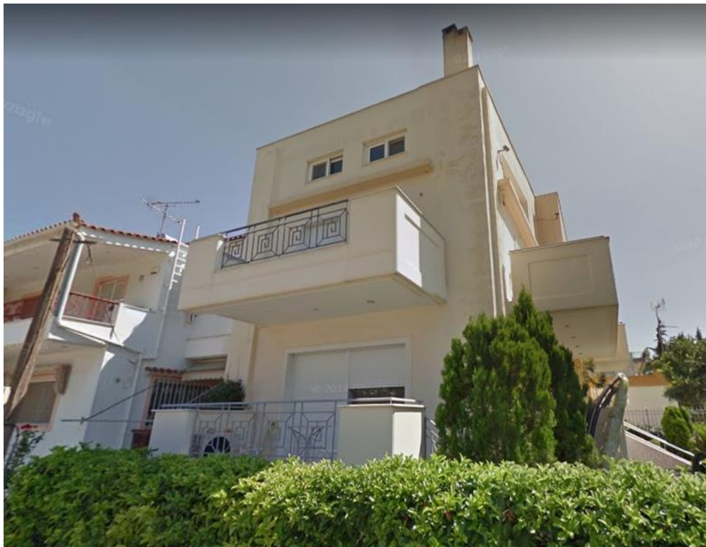
Εικόνα 5.4: Πρόσοψη κτιρίου στην οδό Νισύρου
