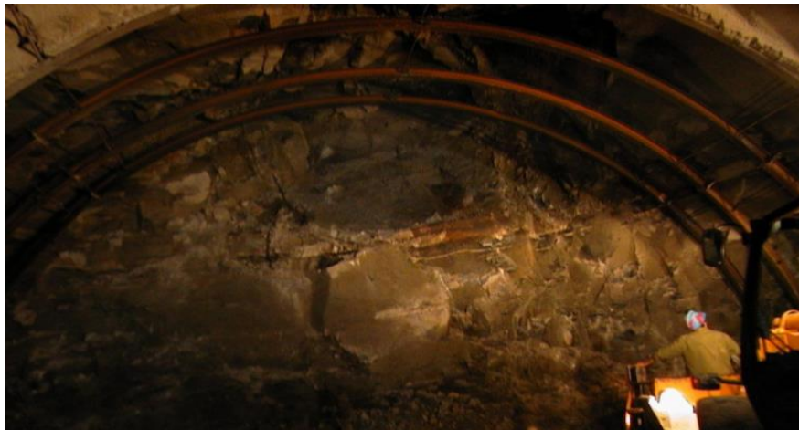
Εικόνα 2.2: Ολίσθηση σφήνας από το μέτωπο (Σήραγγα Περιοχής Πολύμυλου)
