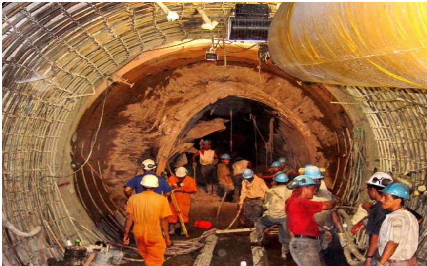
Εικόνα 2.1 : Έντονη σύνθλιψη στη σήραγγα Yasambu – Quibor, με υπερκείμενα 1200m σε περιβάλλον με γραφιτικούς φυλλίτες (Hoek, 2007)
