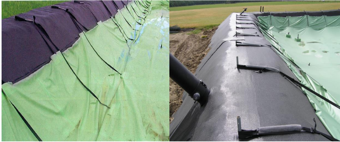
Εικόνα 6. Ειδική μεμβράνη (geotextile) βάσης λιμνοδεξαμενής για την στεγανή αποθήκευση του παραγόμενου υγρού χωνεμένου υπολείμματος
