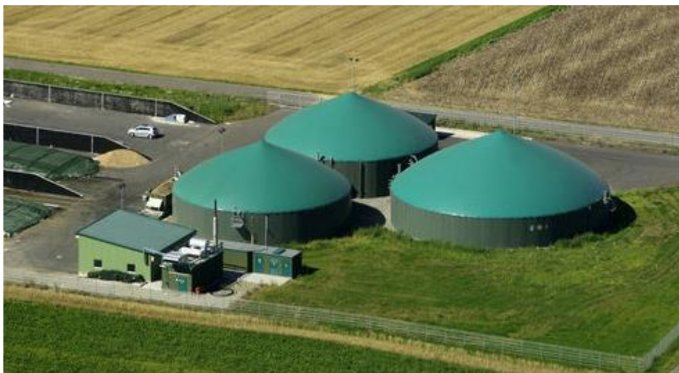
Εικόνα 5. Χωνευτές, δεξαμενές όπου λαμβάνει χώρα η διεργασία της ΑΧ
