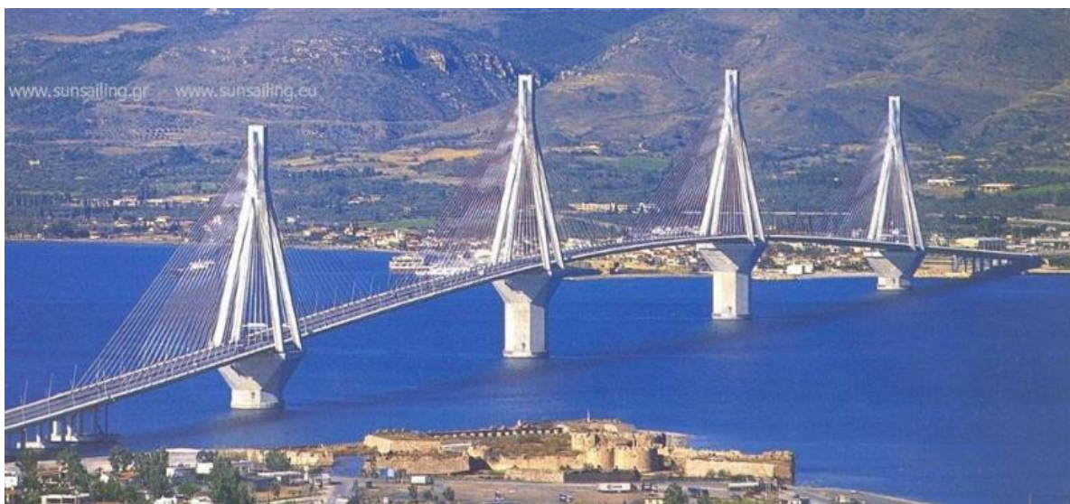
Σχήμα 1.5: Καλωδιωτή γέφυρα Ριο-Αντίρριο
