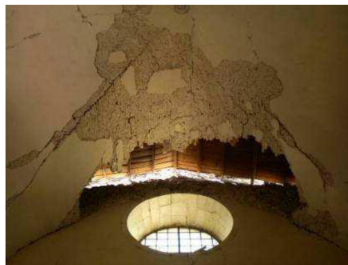
Εικόνα 3-67: Μερική κατάρρευση θόλου της εκκλησίας Santa Maria del Soccorso (Modena et al., 2010)
