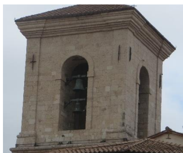
Εικόνα 3-21: Ύπαρξη μεταλλικών ελκυστήρων σε κτίρια της Norcia (Φραγκιαδάκης, 2017)
