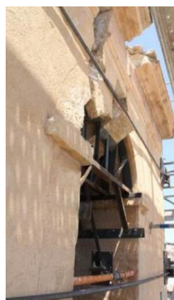
Εικόνα 3-47: Αποδιοργάνωση της τοιχοποιίας στην περιοχή του κλειδιού του τόξου, κωδωνοστάσιο εκκλησίας San Francisco (Romão et al., 2013)
