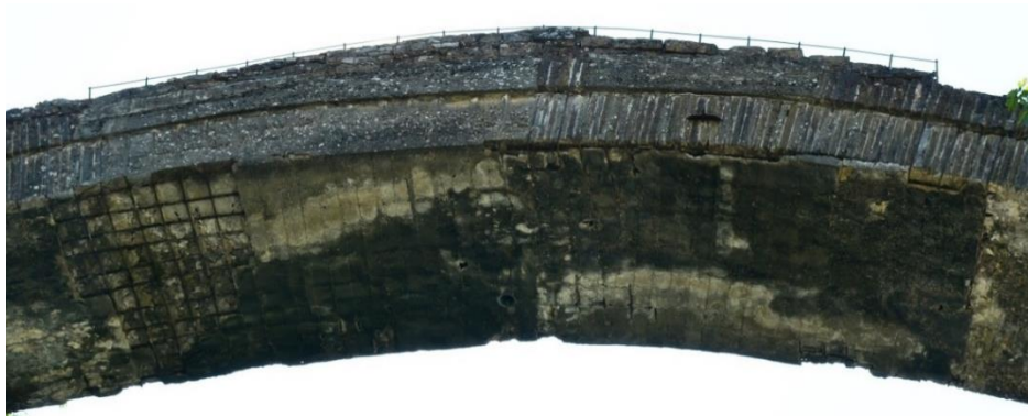
Εικόνα 6-19: «Μανδύας» σκυροδέματος με πάχος 10-12cm, απόλεια επικάλυψης και εκτεθειμένες εσχάρες, χρωματικές αλλοιώσεις και εξανθήσεις σκυροδέματος εξαιτίας διαβρωτικού περιβάλλοντος. Ο «μανδύας» αναρτάται επισφαλώς από το εσωράχιο χάρις σε μεταλλικούς αναβολείς, οι οποίοι εισέρχονται έως την διεπιφάνεια μεταξύ κυρίως και δευτερεύοντος τόξου.
