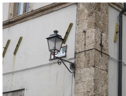
Εικόνα 3-20: Χρήση αντιρήδων σε κατασκευή στην Norcia (Φραγκιαδάκης, 2017)
