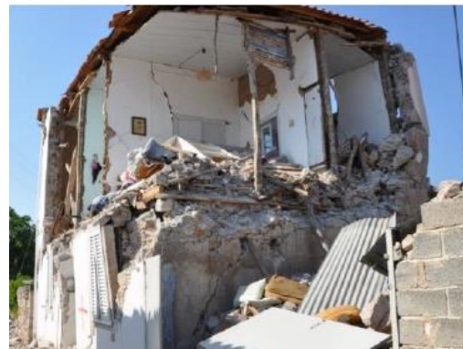
Εικόνα 3-11: Έλλειψη σύνδεσης μεταξύ πατώματος ορόφου και στέγης με την τοιχοποιία (ΕΜΠ, 2017)
