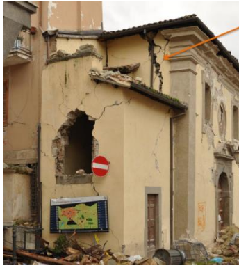
Εικόνα 3-34: Ρωγμή από εκτός επιπέδου κάμψη τοίχου στην Santa Maria del Suffragio (Combescure, and Nistico, 2017)
