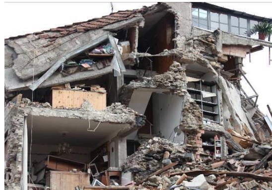
Εικόνα 3-36: Κατασκευή στην οποία είχε τοποθετηθεί πλάκα σκυροδέματος χωρίς ενίσχυση της υποκείμενης τοιχοποιίας (Quest et al., 2016)
