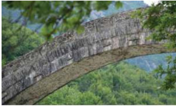
Εικόνα 6-8: Δόμηση με διπλό τόξο στην γέφυρα της Πλάκας
