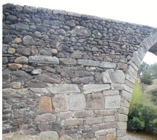
Εικόνα 6-30: Ύπαρξη ενδιάμεσων στρώσεων με πλακοειδείς λίθους και χρήση ημιλαξευτών λίθων πλησίον του τόξου στο κάτω μέρος της κατασκευής
