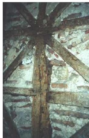
Εικόνα 3-80: Ενώσεις των ξύλινων στοιχείων με μεταλλικά παρεμβλήματα (Bento et al., 2004)
