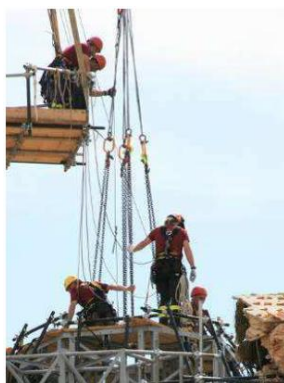
Εικόνα 3-53: Εργασίες διάσωσης του θόλου της Εκκλησίας Anime Sante από το Πυροσβεστικό Σώμα ( Modena et al., 2010 )
