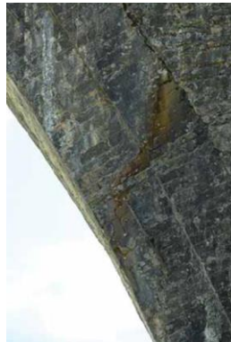
Εικόνα 6-10: Τοπική αποκόλληση του διπλού τόξου από το τόμπανο στην γέφυρα της Πλάκας
