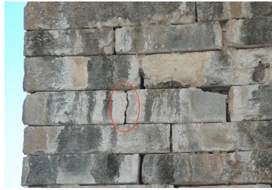
Εικόνα 6-32: Ρωγμές, αποκολλήσεις και χρωματικές αλλοιώσεις σε λίθους του τόξου
