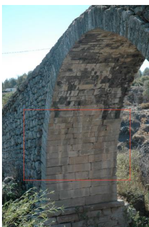
Εικόνα 6-29: Δόμηση του τόξου με λαξευτούς λίθους
