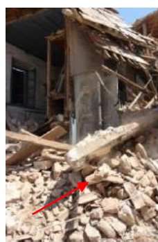
Εικόνα 3-13: Καταρρέσεις τοιχοποιίας και διαζωμάτων σκυροδέματος (ΕΜΠ, 2017)
