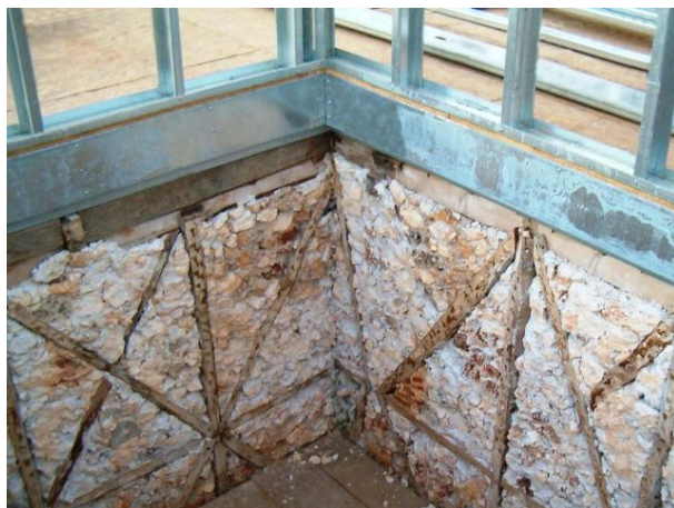
Εικόνα 3-79: Ξύλινος κλωβός “rombalino” ενσωματωμένος σε τοιχοποιία ( http://observador.pt/especiais/se-lisboa-abanar-cai-como-amatrice/ )
