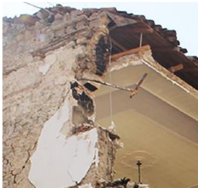
Εικόνα 3-35: Αυθαίρετες επεμβάσεις σε κατασκευή στο Amatrice: είναι εμφανές το μεταλλικό στοιχείο που είχε εγκιβωτιστεί ελλιπώς στην τοιχοποιία, το οποίο δεν εμπόδισε την εκτός επιπέδου κατάρρευση (Fiorentino et al., 2017)
