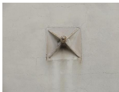
Εικόνα 3-21: Ύπαρξη μεταλλικών ελκυστήρων σε κτίρια της Norcia (Φραγκιαδάκης, 2017)
