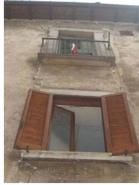
Εικόνα 3-64: Κατακόρυφες ρωγμές στα άκρα των υπέρθυρων από εντός επιπέδου κάμψη (Kouris et al., 2010)
