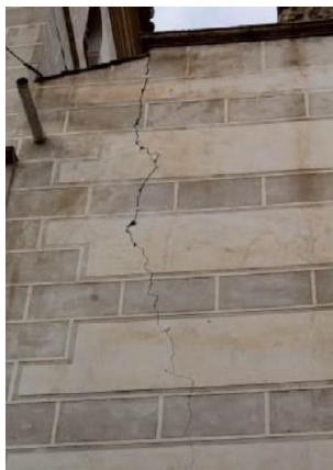
Εικόνα 3-48: Κατακόρυφες ρωγμές από εκτός επίπεδου καμπτική καταπόνηση, με μειούμενο προς τα κάτω εύρος, στην εκκλησία Nuestra Señora del Rosario. Δεξιά: προσωρινή συγκράτηση τοίχων με ελκυστήρες (Romão et al., 2013)
