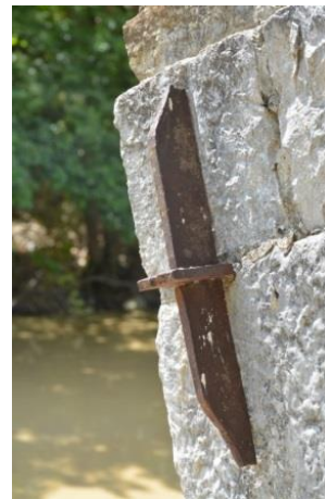
Εικόνα 6-12: Μεταλλικό παρέμβλημα (άρπιζα) που συναντάται και στις δύο γέφυρες.
