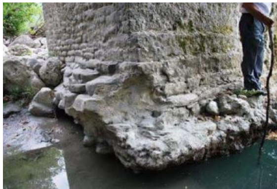
Εικόνα 6-25: Έντονη διάβρωση βάθρου και υποσκαφή της θεμελίωσης (φωτογραφικό αρχείο ΕΜΠ)
