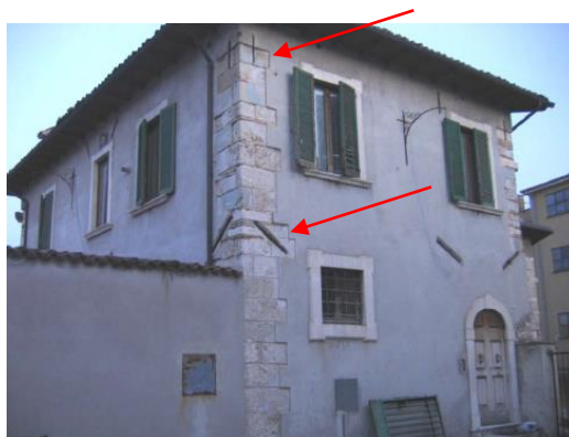
Εικόνα 3-73: Αβλαβής κατασκευή στην οποία είχαν τοποθετηθεί μεταλλικοί ελκυστήρες και στους δύο ορόφους. Από την διαφορετική τους εμφάνιση μπορεί να συναχθεί ότι τοποθετήθηκαν σε διαφορετικές φάσεις. (Monaco, 2017)
