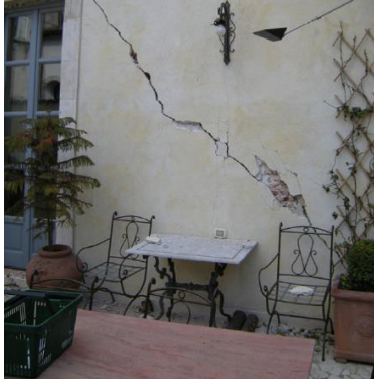
Εικόνα 3-74: Διαγώνια διαμεπής ρωγμή (α) λήψη από το εξωτερικό της κατασκευής (β) λήψη από το εσωτερικό της κατασκευής, όπου η ρωγμή διαπερνά τοιχογραφία (Parisi and Augenti, 2013)
