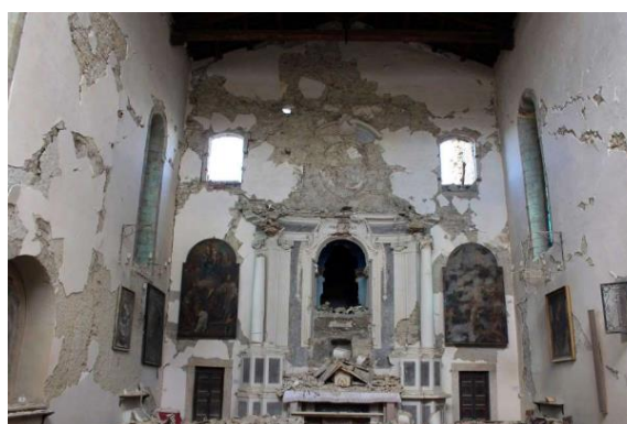
Εικόνα 3-32: Εικόνες βλαβών από το εσωτερικό της εκκλησίας San Agostino. Ο επιχρισματικός ιστός παρουσιάζει εκτεταμένη ρηγμάτωση και αποκολλήσεις. ( http://www.michiganstthumb.com/news/world/article/Lost-heritage-Quake-deals-blow-to-Italy-s-art-9190060.php#photo-10843229 )
