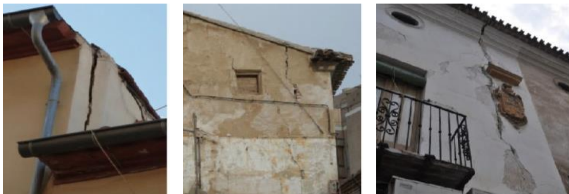
Εικόνα 3-42: Κατακόρυφες ρωγμές από εκτός επίπεδου κάμψη της τοιχοποιίας (Basset-Salom and Guardiola-Villora, 2014)
