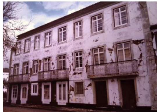
Εικόνα 3-86: Διαγώνιες ρωγμές σε πεσσούς μεταξύ ανοιγμάτων (Fagundes et al., 2017)
