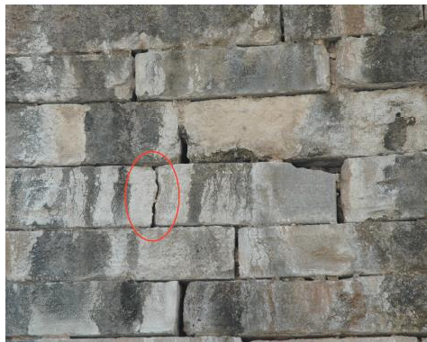
Εικόνα 6-44: Ρωγμές, αποκολλήσεις και χρωματικές αλλοιώσεις σε λίθους του τόξου της γέφυρας της Κρεμαστής
