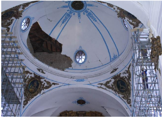
Εικόνα 3-49: Αποδιοργάνωση τοιχοποιίας της εκκλησίας San Francisco (α) στον τρούλο (β) σε έναν εκ των θόλων (Romão et al., 2013)
