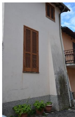
Εικόνα 3-20: Χρήση αντιρήδων σε κατασκευή στην Norcia (Φραγκιαδάκης, 2017)
