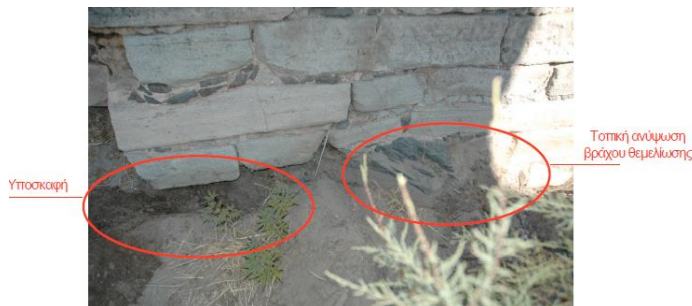
Εικόνα 6-46: Υποσκαφή και τοπική ανύψωση βραχώδους υποβάθρου στο δυτικό βάθρο της γέφυρας της Κρεμαστής
