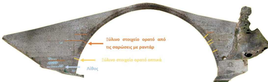
Εικόνα 6-17: Τρισδιάστατη απεικόνιση γέφυρας Κόνιτσας (απεικονίζονται οι ξύλινες εσχάρες εσωραχίων, οι άρπιζες εσωραχίων, οι λίθοι και τα ξύλινα στοιχεία του σώματος της γέφυρας)
