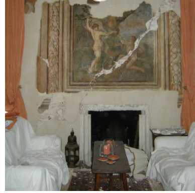
Εικόνα 3-74: Διαγώνια διαμεπής ρωγμή (α) λήψη από το εξωτερικό της κατασκευής (β) λήψη από το εσωτερικό της κατασκευής, όπου η ρωγμή διαπερνά τοιχογραφία (Parisi and Augenti, 2013)
