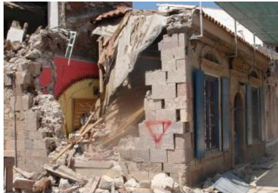
Εικόνα 3-8: Κατάρρευση τοιχοποιίας ισόγειου κτίσματος από εκτός επιπέδου κάμψη, με απώλεια έδρασης στέγης. Παρατηρείται η απουσία κονιάματος των τσιμεντόλιθων της εξωτερικής παρειάς διατεταγμένων σε ισόδομο σύστημα, η σχετική ολίσθηση και η πτωχή ποιότητα λίθων της εσωτερικής παρειάς. Οι δύο παρειές είναι μεταξύ τους ασύνδετες. Στην κάθετη όψη του κτιρίου δεν διακρίνονται βλάβες ίδιας έκτασης. (ΕΜΠ, 2017)
