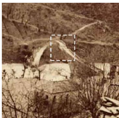
Εικόνα 6-4: Βλάβες τόξου από την απόπειρα ανατίναξης της γέφυρας της Πλάκας το 1944 (Βιντζηλαίου, Γιαννέλος, 2015)
