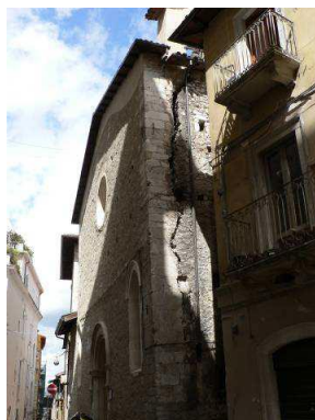
Εικόνα 3-66: Εκτός επιπέδου κατάρρευση της πρόσοψης της εκκλησίας San Giuseppe dei Minimi (Modena et al., 2010)
