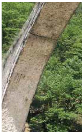
Εικόνα 6-26: Βλάβη στο εσωράχιο του κυρίως τόξου, λήψη του 1995
