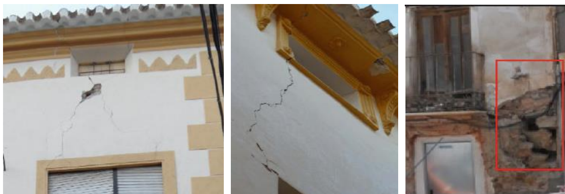
Εικόνα 3-43: Βλάβες σε υπέρθυρα από εντός επιπέδου δράση: (α) Διαγώνιες διατμητικές ρωγμές (β) Κατακόρυφη καμπτική ρωγμή (Basset-Salom and Guardiola-Villora, 2014)
