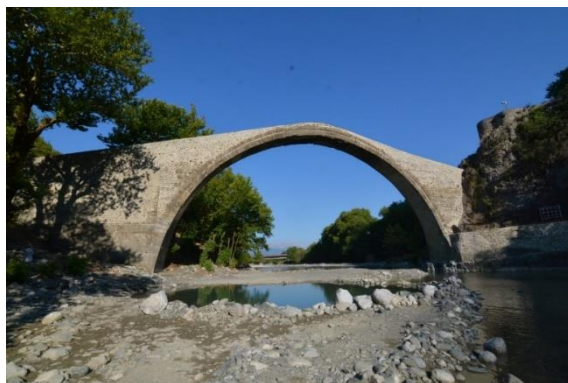
Εικόνα 6-2: Η γέφυρα της Κόνιτσας, όψη από ανάντη (λήψη του 2017)
