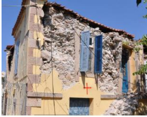
Εικόνα 3-7: Κατάρρευση εξωτερικής παρειάς τοιχοποιίας. Διακρίνεται η χαμηλή ποιότητα δομίσεως της τοιχοποιίας (ΕΜΠ, 2017)
