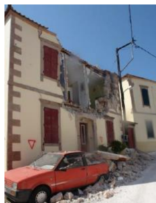
Εικόνα 3-14: Πρόκληση αστοχιών εξαιτίας πρόσθετου εξώστη από ωπλισμένο σκυρόδεμα (α) Βλάβη υπέρθυρου (β) Ανατροπή τοιχοποιίας (ΕΜΠ, 2017)
