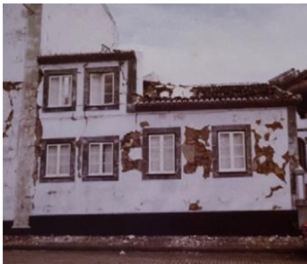
Εικόνα 3-86: Διαγώνιες ρωγμές σε πεσσούς μεταξύ ανοιγμάτων (Fagundes et al., 2017)
