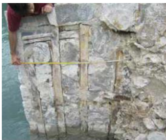
Εικόνα 6-14: Εύρεση ξύλινων στοιχείων σε θραύσμα της γέφυρας της Πλάκας.
