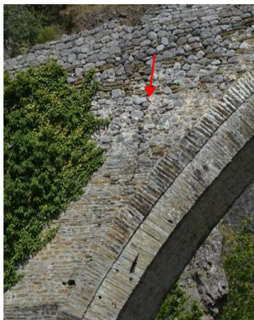
Εικόνα 6-20: Κατακόρυφη ρωγμή στο κατάντη τύμπανο του Βόρειου βάθρου, όπως φαίνεται πριν το αρμολόγημα του 2015
