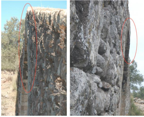
Εικόνα 6-31: Εκτός επιπέδου μετάθεση του τόξου
