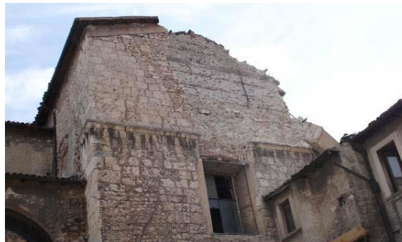
Εικόνα 3-59: Εκτός επιπέδου κατάρρευση τμήματος τοιχοποιίας (Kouris et al., 2010)
