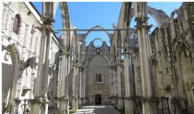
Εικόνα 2-10: Convento da Ordem do Carmo, μνημείο του 14 ου αιώνα (1389) στην Λισαβόνα. Υπέστη σοβαρές βλάβες στους σεισμούς του 1755 και 1969. Στην φωτογραφία απεικονίζονται οι επεμβάσεις που έχουν πραγματοποιηθεί ( https://theculturetrip.com/europe/portugal/articles/most-impressive-buildings-in-lisbon/ ).
