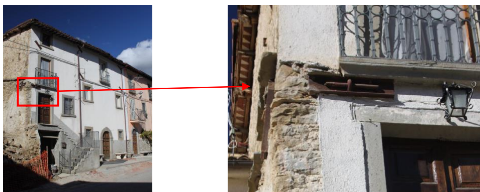
Εικόνα 3-23: Περίπτωση εξαιρέσης στο Amatrice: κατασκευή η οποία είχε περιδεθεί με μεταλλικά στοιχεία (Combescure and Nistico, 2017)
