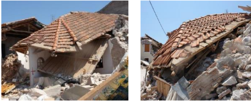
Εικόνα 3-15: Κατάρρευση στεγών και τοιχοποιιών χωρίς στρωτήρες (ΕΜΠ, 2017)
