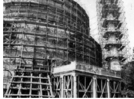
Εικόνα 2-3: Προσωρινές αντιστηρίξεις στην Ροτόντα μετά τον σεισμό του 1978 στην Θεσσαλονίκη (Πολυτεχνική Σχολή ΑΠΘ, 2008)
