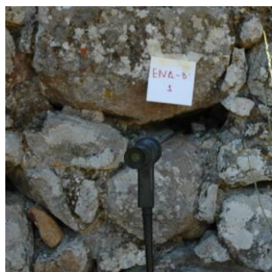
Εικόνα 6-35: Παράδειγμα ενδοσκόπησης σε υπάρχουσα οπή σε πρόσβαση
