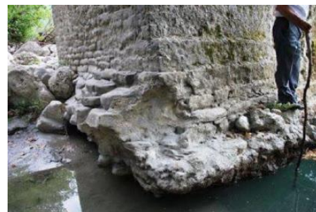
Εικόνα 6-47: Έντονη διάβρωση βάθρου και υποσκαφή της θεμελίωσης της γέφυρας της Πλάκας (φωτογραφικό αρχείο ΕΜΠ)
