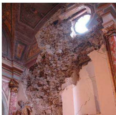
Εικόνα 3-68: Πολύ χαμηλής ποιότητας υλικά σε τοίχους μεγάλου πάχους σε εκκλησίες (α) San Michele Arcangelo in Celano (Modena et al., 2010) (β) Santa Maria di Paganica (Parisi and Augenti, 2013)
