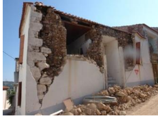
Εικόνα 3-7: Κατάρρευση εξωτερικής παρειάς τοιχοποιίας. Διακρίνεται η χαμηλή ποιότητα δομίσεως της τοιχοποιίας (ΕΜΠ, 2017)
