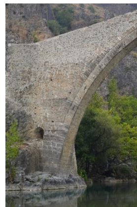
Εικόνα 6-7: Παραμερής δόμηση των τυμπάνων, των βάθρων και των τόξων των δύο γεφυρών (α) Πλάκα (β) Κόνιτσα
