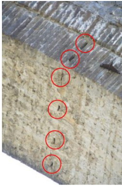
Εικόνα 6-15: Οπές στο εσωράχιο και στην όψη του τόξου, ενδεικτικές των θέσεων ξύλινων στοιχείων στην γέφυρα της Κόνιτσας
