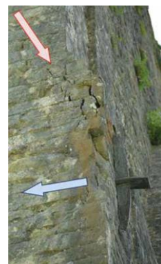
Εικόνα 6-42: Ρηγμάτωση λίθων τόξου γέφυρας (α) Κρεμαστής (β) Πλάκας
