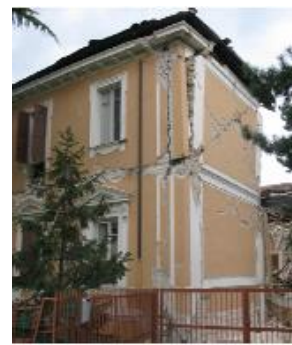
Εικόνα 3-61: Κατακόρυφη ρωγμή πλησίον γωνίας στον ανώτερο όροφο κατασκευής. Η ρωγμή σχηματίστηκε στον τοίχο που συνδέεται κάθετα με αυτόν που τείνει να ανατραπεί εκτός επιπέδου (Karlan et al., 2010).
