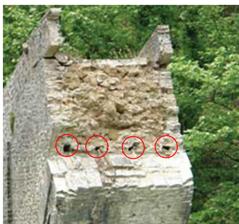
Εικόνα 6-13: Το γέμισμα μεταξύ των τυμπάνων της γέφυρας της Πλάκας είναι δομημένο με μικρούς και μεσαίου μεγέθους λίθους, από ασβεστόλιθο ή ασβεστιτικό ψαμμίτη. Επιβεβαιώθηκε και η χρήση πωρόλιθων για το γέμισμα, με σκοπό την μείωση του ίδιου βάρους του γεμίσματος. Στην εικόνα επιπροσθέτως διακρίνονται οι οπές που αντιστοιχούν σε θέσεις ξύλινων στοιχείων.
