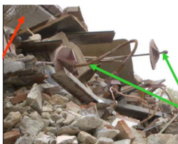
Εικόνα 3-72: Κατασκευή που κατέρρευσε παρά την ύπαρξη πλάκας ωπλισμένου σκυροδέματος και μεταλλικών ελκυστήρων (Monaco, 2017)
