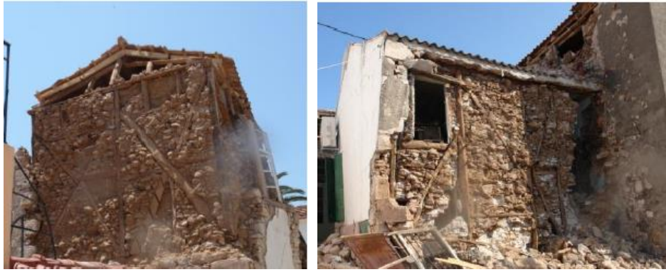
Εικόνα 3-9: Αποκόλληση εξωτερικής παρειάς και αποκάλυψη εσωτερικής παρειάς σε κτίσματα από λιθοδομή. Διακρίνονται τα εγκιβωτισμένα στην τοιχοποιία διαγώνια ξύλινα στοιχεία. (ΕΜΠ, 2017)
