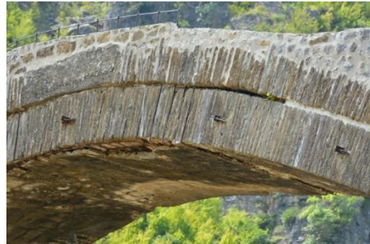
Εικόνα 6-9: Δόμηση με διπλό τόξο στην γέφυρα της Κόνιτσας.
