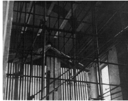
Εικόνα 2-6: Προσωρινή υποστήλωση στην Cappella Rucellai της Φλωρεντίας. Φωτογραφική λήψη στο εσωτερικό του ναού. (UNESCO, 1972)
