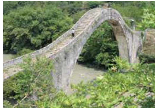
Εικόνα 6-41: Ανάπτυξη βλάστησης στο άνω μέρος των τυμπάνων, στο στηθαίο και στο κατάστρωμα της γέφυρας της Πλάκας
