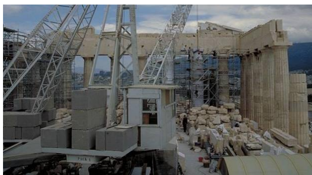
Εικόνα 2-1: Εργασίες συντήρησης στον Παρθενώνα (Ιωαννίδου, 2015)
