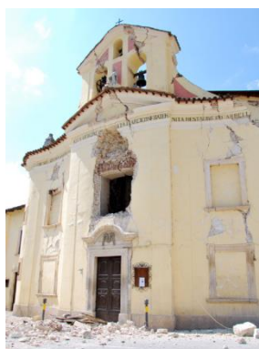
Εικόνα 3-68: Πολύ χαμηλής ποιότητας υλικά σε τοίχους μεγάλου πάχους σε εκκλησίες (α) San Michele Arcangelo in Celano (Modena et al., 2010) (β) Santa Maria di Paganica (Parisi and Augenti, 2013)
