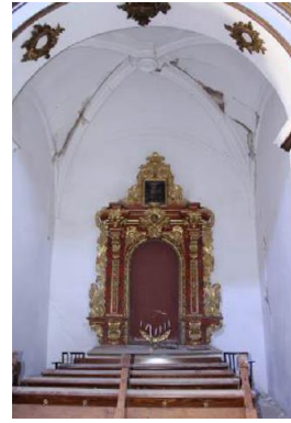
Εικόνα 3-49: Αποδιοργάνωση τοιχοποιίας της εκκλησίας San Francisco (α) στον τρούλο (β) σε έναν εκ των θόλων (Romão et al., 2013)
