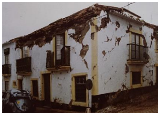
Εικόνα 3-84: Απώλεια έδρασης στέγης και κατάρρευση (Fagundes et al., 2017)
