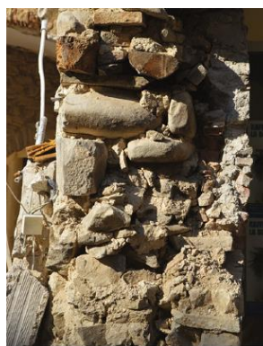
Εικόνα 3-30: Εγκάρσια όψη τοιχοποιίας: απουσία διάτονων λίθων (Fiorentino et al., 2017)
