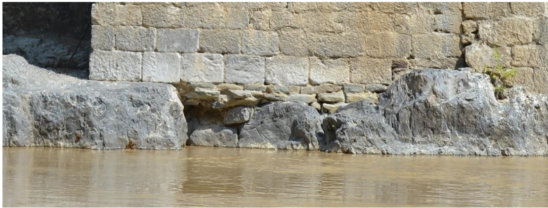
Εικόνα 6-23: Στάθμη έδρασης βόρειου βάθρου και αποκόλληση λίθων
