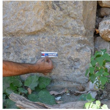
Εικόνα 6-22: Μέτρηση εύρους ρωγμών των λαξευτών λίθων σε βάθρο
