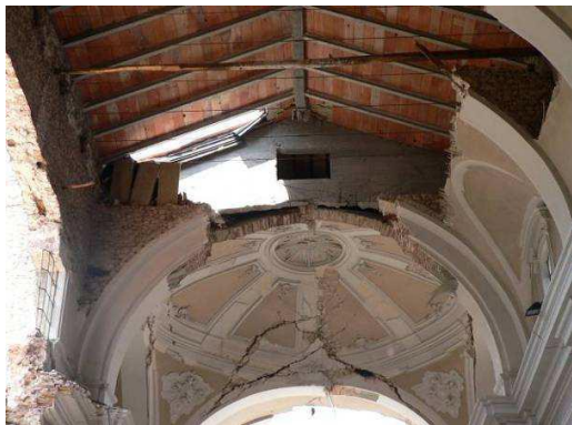
Εικόνα 3-70: Αστοχία στο εσωτερικό της εκκλησίας San Marco (Modena et al., 2010)
