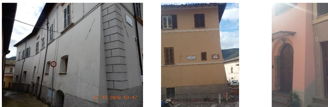
Εικόνα 3-22: Γραμμική αύξηση του πάχους της τοιχοποιίας στον κατώτερο όροφο και διατήρηση σταθερού πάχους στους ανώτερους ορόφους σε κατασκευές της Norcia (Φραγκιαδάκης, 2017)
