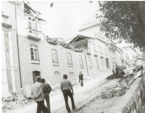
Εικόνα 3-85: Εκτός επιπέδου κατάρρευση τοιχοποιίας τρίτου ορόφου και κατάρρευση στέγης (α) Fagundes et al., 2017 (β) https://www.publico.pt/2014/03/08/ciencia/noticia/memorias-do-sismo-de-1980-nos-acores-reunidas-num-site-1627466
