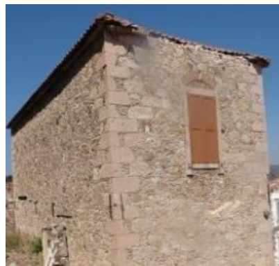
Εικόνα 3-4: Αβλαβής κατασκευή - οι παράλληλοι τοίχοι συγκρατούνται με μεταλλικούς ελκυστήρες από εκτός επιπέδου κατάρρευση. (EMΠ, 2017)
