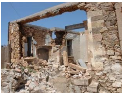
Εικόνα 3-12: Κατάρρευση τοιχοποιίας χωρίς κατάρρευση διαζώματος σκυροδέματος (ΕΜΠ, 2017)
