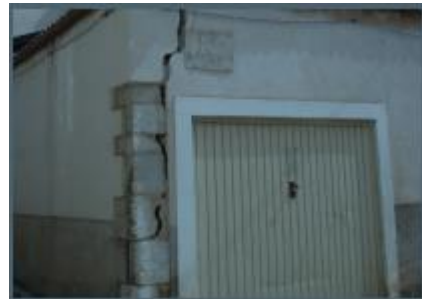
Εικόνα 3-63: Παρουσία ανοίγματος σε μεγάλη εγγύτητα με την γωνία της τοιχοποιίας (Karlan et al., 2010).
