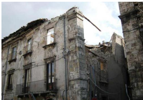
Εικόνα 3-60: Εκτός επιπέδου κατάρρευση τοίχου στον οποίο είχαν τοποθετηθεί ξυλοδεσιές μετά τον σεισμό του 1703, ελλιπώς συντηρημένες (Augenti and Parisi, 2010).
