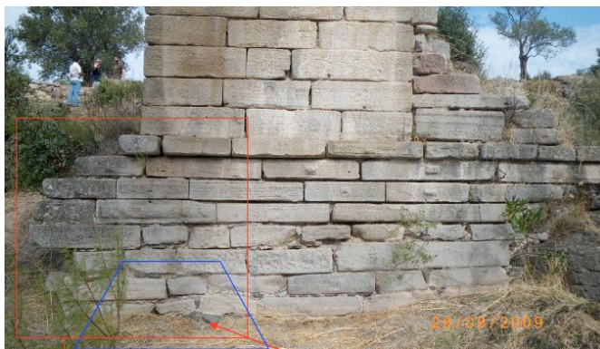
Εικόνα 6-33: Δυτικό βάθρο: τοπική ανύψωση βραχώδους υποβάθρου
