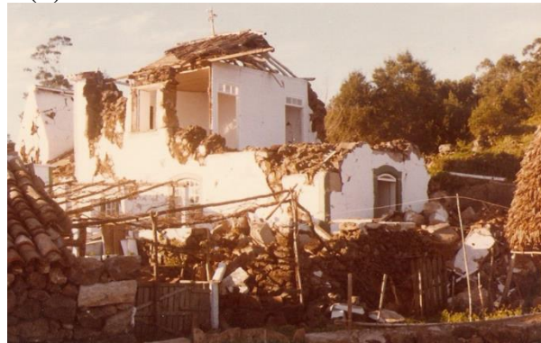
Εικόνα 3-85: Εκτός επιπέδου κατάρρευση τοιχοποιίας τρίτου ορόφου και κατάρρευση στέγης (α) Fagundes et al., 2017 (β) https://www.publico.pt/2014/03/08/ciencia/noticia/memorias-do-sismo-de-1980-nos-acores-reunidas-num-site-1627466
