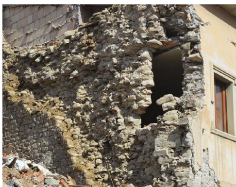
Εικόνα 3-29: Αργολιθοδομή χαμηλής ποιότητας, σχεδόν θρυσματισμένη (Fiorentino et al., 2017)
