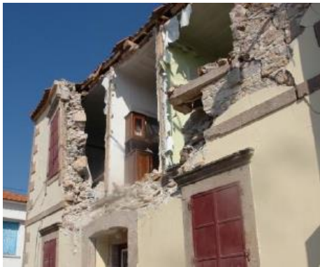
Εικόνα 3-10: Κατάρρευση από εκτός επιπέδου κάμψη τοιχοποιίας ανώτερου ορόφου κτίσματος - έλλειψη εξασφάλισης από κάθετους ξυλόπηκτους τοίχους. (ΕΜΠ, 2017)
