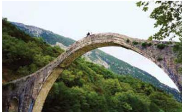
Εικόνα 6-45: Ύετια διαλυτική δράση εντός της λιθοδομής της γέφυρας της Πλάκας-χρωματικές αλλοιώσεις και εκροή υδάτων από διάφορα σημεία της κατασκευής
