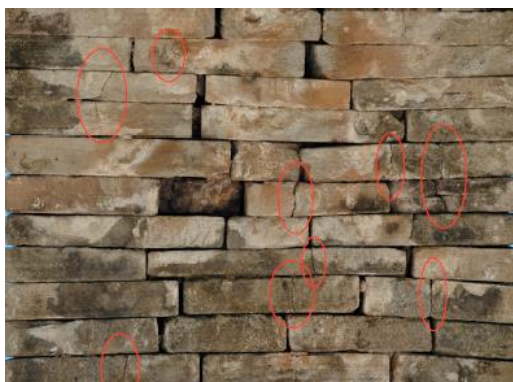
Εικόνα 6-42: Ρηγμάτωση λίθων τόξου γέφυρας (α) Κρεμαστής (β) Πλάκας
