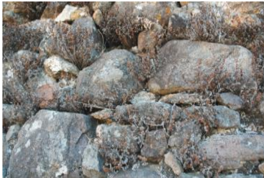
Εικόνα 6-40: Βλάστηση στο ανώτερο τμήμα τυμπάνου της γέφυρας της Κρεμαστής
