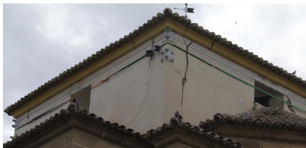
Εικόνα 3-48: Κατακόρυφες ρωγμές από εκτός επίπεδου καμπτική καταπόνηση, με μειούμενο προς τα κάτω εύρος, στην εκκλησία Nuestra Señora del Rosario. Δεξιά: προσωρινή συγκράτηση τοίχων με ελκυστήρες (Romão et al., 2013)
