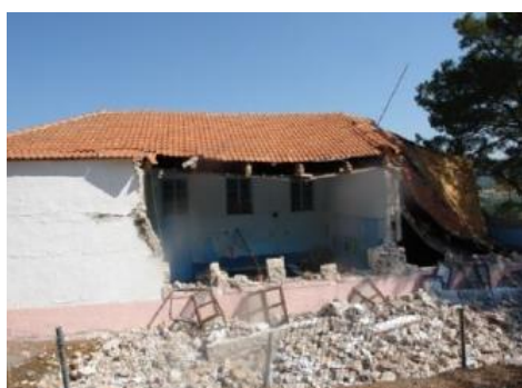
Εικόνα 3-13: Καταρρέσεις τοιχοποιίας και διαζωμάτων σκυροδέματος (ΕΜΠ, 2017)
