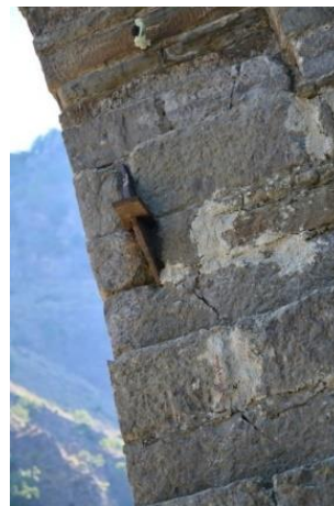
Εικόνα 6-21: Κατάντη ακμή Νότιου βάθρου: ρηγματώση λίθων στη θέση συναρμογής κυρίως τόξου – βάθρου, δηλωτική της ανάπτυξης σημαντικών θλιπτικών τάσεων.
