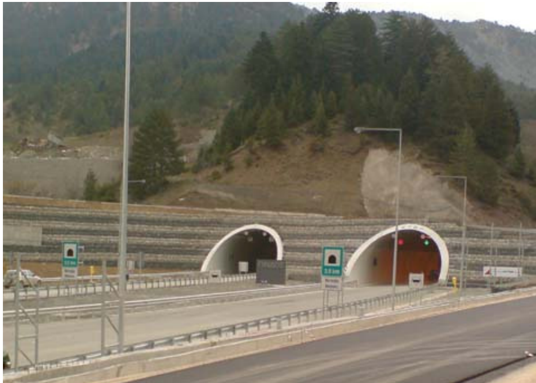
Εικόνα 2.1. Δυτική είσοδος Σήραγγας Μετσόβου
