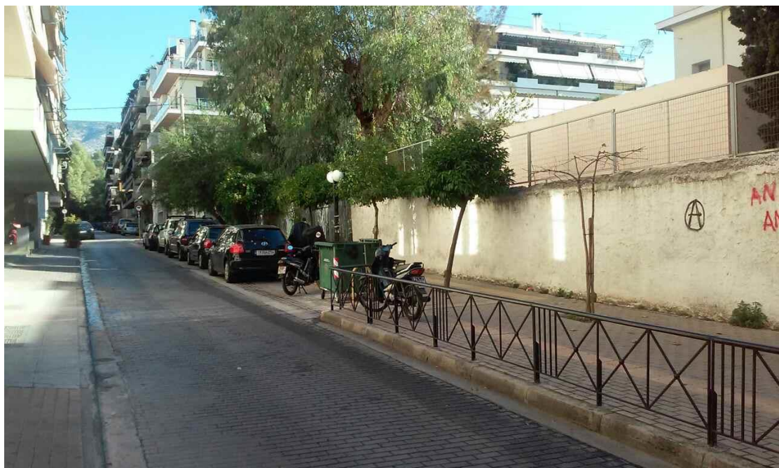
Εικόνα 13 : Διαπλάτυνση πεζοδρομίου, οριοθέτηση θέσεων στάθμευσης και τοποθέτηση προστατευτικών κγκλιδωμάτων έξω από την είσοδο του 1 ου Δημοτικού σχολείου, Πηγή : προσωπικό αρχείο.
