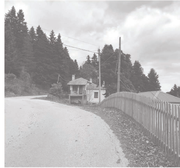
ΚΑΤΟΙΚΙΑ ΑΡΧΙΤΕΚΤΟΝ Δ. ΠΙΚΙΩΝΗΣ
