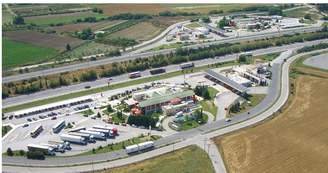
Σχήμα 2.18 Αμφίπλευρος Σταθμός Εξυπηρέτησης Αυτοκινητιστών (ΣΕΑ) Κορινού, 447 χλμ, ΝΕΟ Αθήνας – Θεσσαλονίκης ( http://www.aegeanmotorway.gr )
